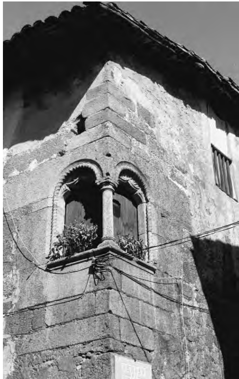
Fig. 3. Ventana angular erudita en una casa de la calle Álvarez de Castro
