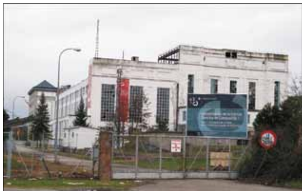
FIG. 12. Central térmica de Compostilla I, futura sede de la Fundación de la Energía.
