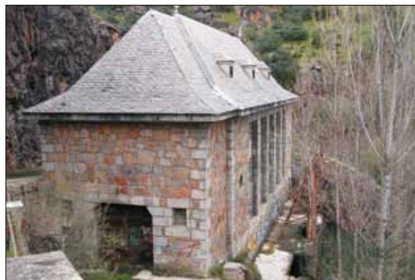
FIG. 11. Central hidroeléctrica de Fuente del Azufre.
