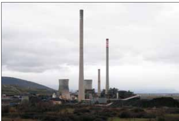
FIG. 9. Central térmica de Compostilla II.
