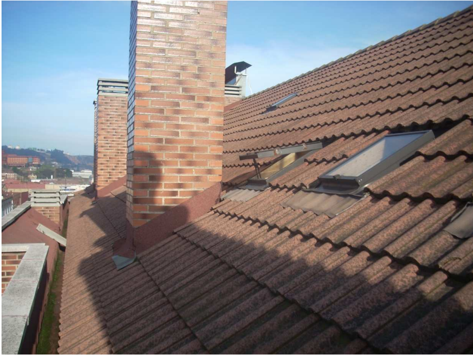
Figura 3.20. En la zona central puede verse la abertura al exterior del almacenamiento abierto utilizado. Al fondo de la imagen la Campa de Torres de la ciudad de Gijón.
