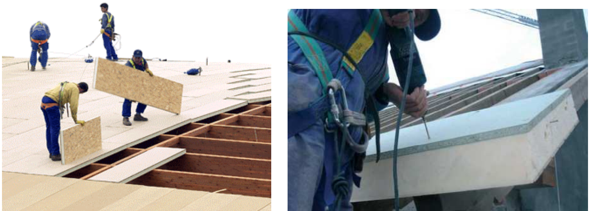
Figura 1.2. Colocación de panel sándwich
