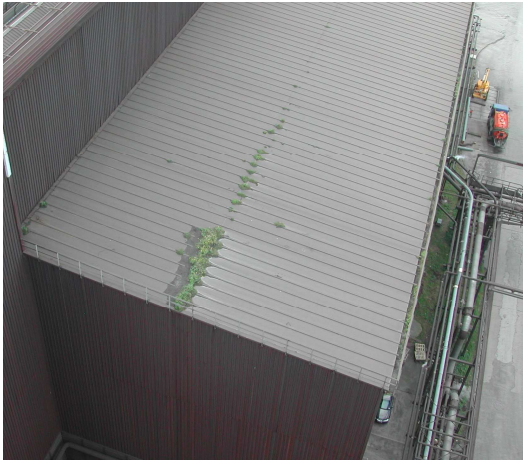
Figura 1.4. Estado de la cubierta. Vista exterior
