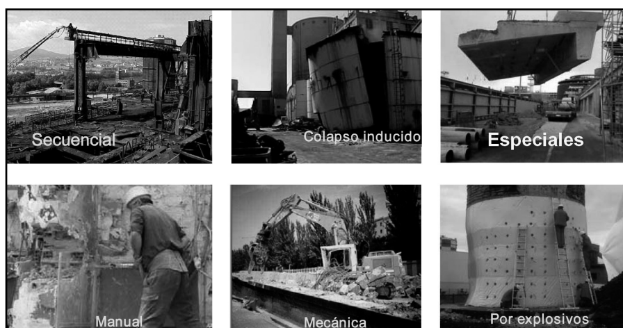
Figura 1. Principales métodos de demolición.
