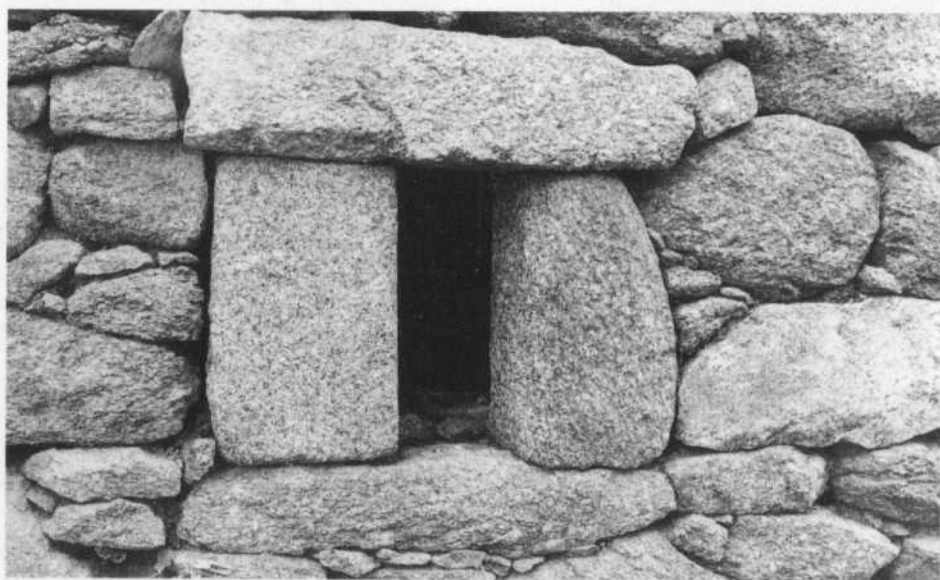
Ventana de piedra
