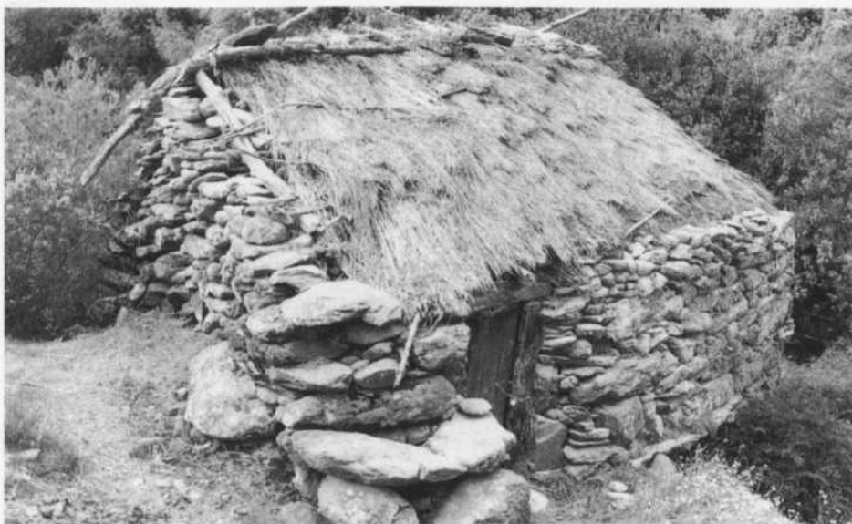
Cubierta vegetal. Muro redondeado
