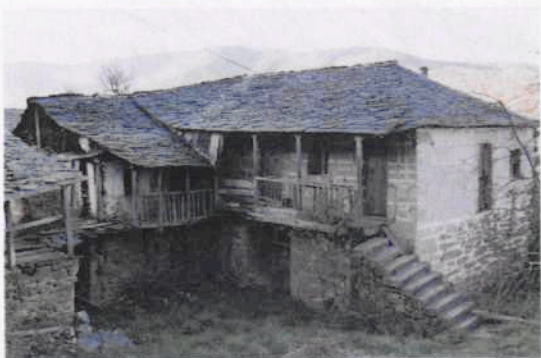
Corredores abiertos y muro de Cañizo
