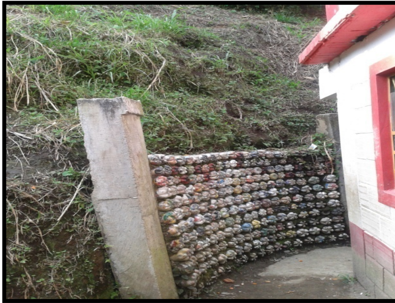
Foto 4: Muro elaborado con eco ladrillos
