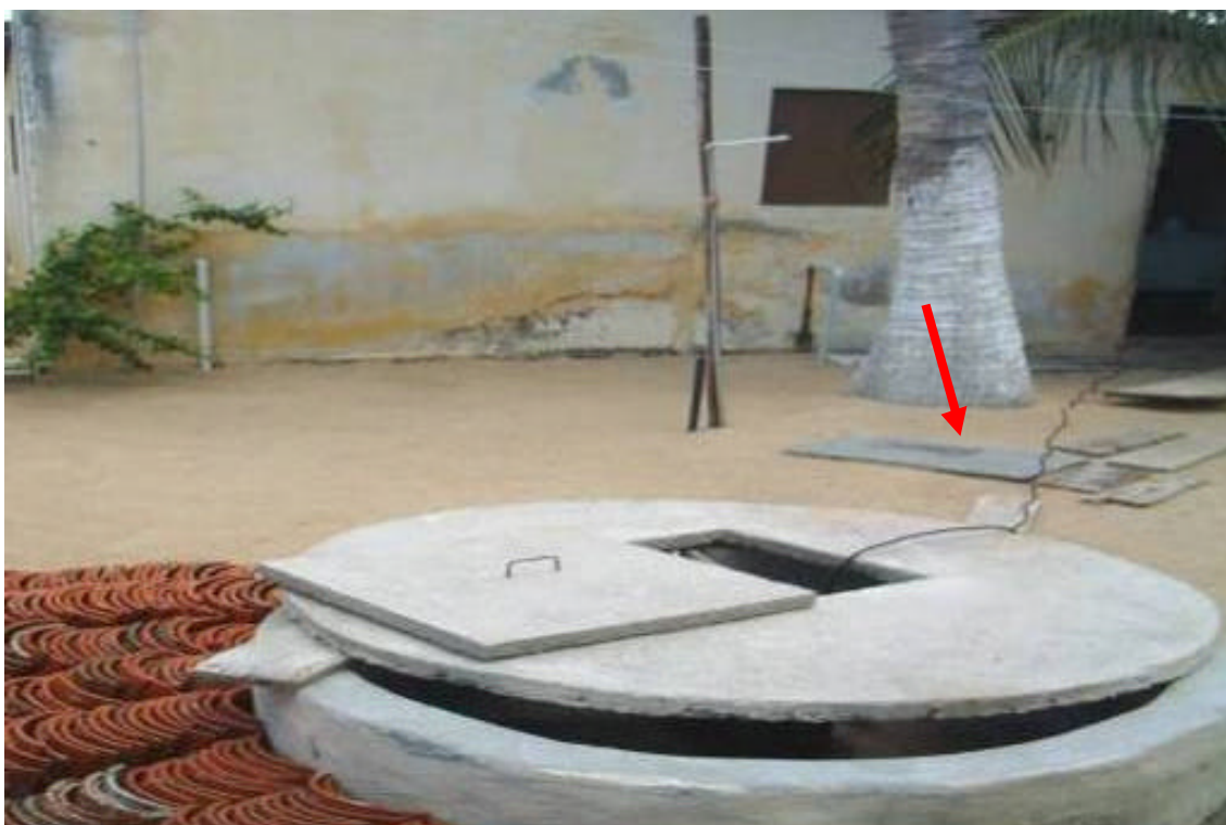
Fotografia 57 – A imagem mostra a proximidade dos poços para abastecimento de água e a localização das fossas (seta vermelha) da residência em novembro de 2006, Galinhos-RN (Foto: Adriana Rocha, novembro/2006).
