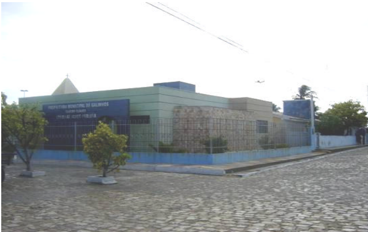
Fotografia 32 – A imagem mostra a Unidade Integrada de Saúde da sede municipal, Galinhos-RN (Foto: Adriana Rocha, novembro/2006).
