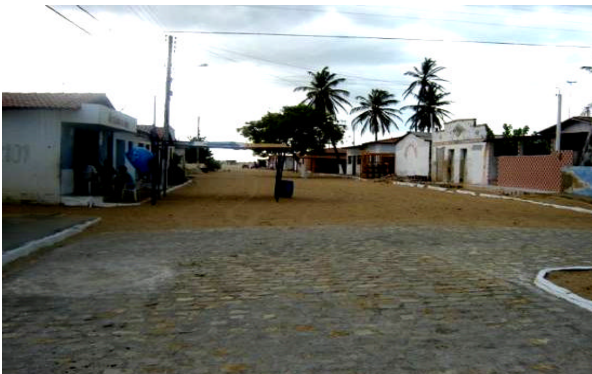
Fotografia 35 – A imagem mostra ruas parcialmente pavimentadas na sede municipal, Galinhos-RN (Foto: Adriana Rocha, novembro/2006).
