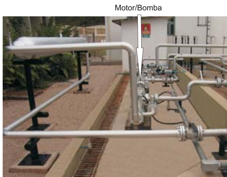
Sistema de aquecimento com resistências de imersão
