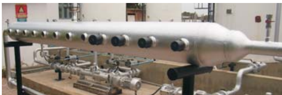
Sistema de aquecimento com resistências de imersão
