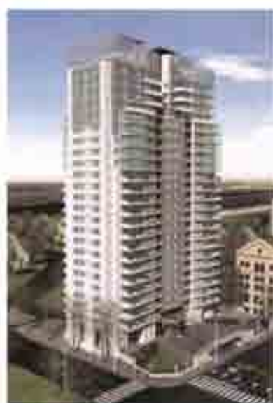
Figura 131 – Torre El Mirador - Dique 1 (Buenos Aires)
