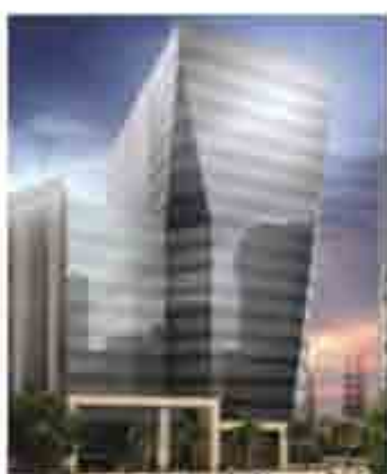
Figura 296 – Edifício Porto Brasília. Operação Urbana Porto Maravilha (Rio de Janeiro)
