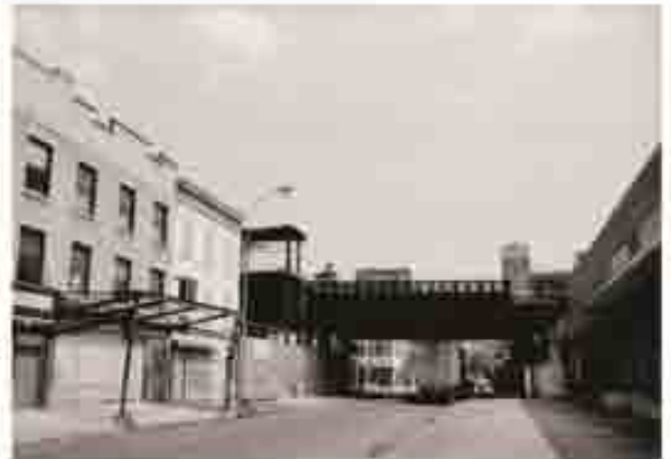
Figura 27 – Ferrovia High Line e arredores subutilizados
