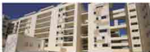
Figura 107 - Área residencial em Joliette (Marselha)
