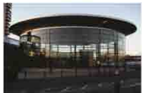
Figura 81 – Estação de Canada Water, Surrey Docks (Londres)
