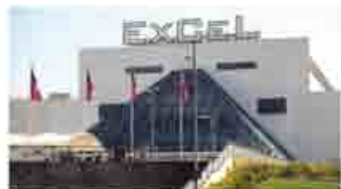
Figura 80 – Excel London (novo Centro de Convenções de Londres)
