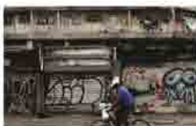
Figura 240 – Santa Ifigênia. Abandono/degradação (São Paulo)
