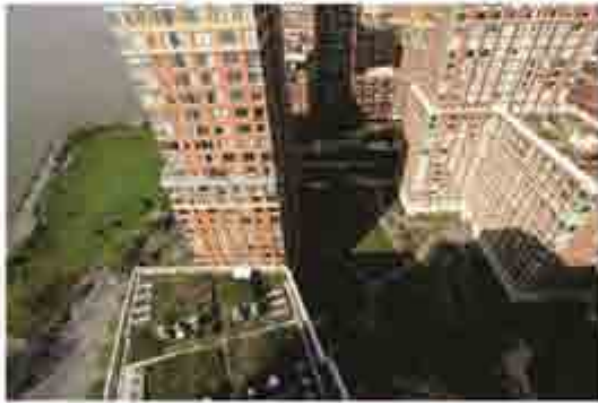
Figura 176 – Edifício residencial Solaire (Nova Iorque)
