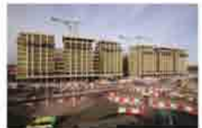
Figura 164 – Vila Olímpica Londres 2012, futura área residencial
