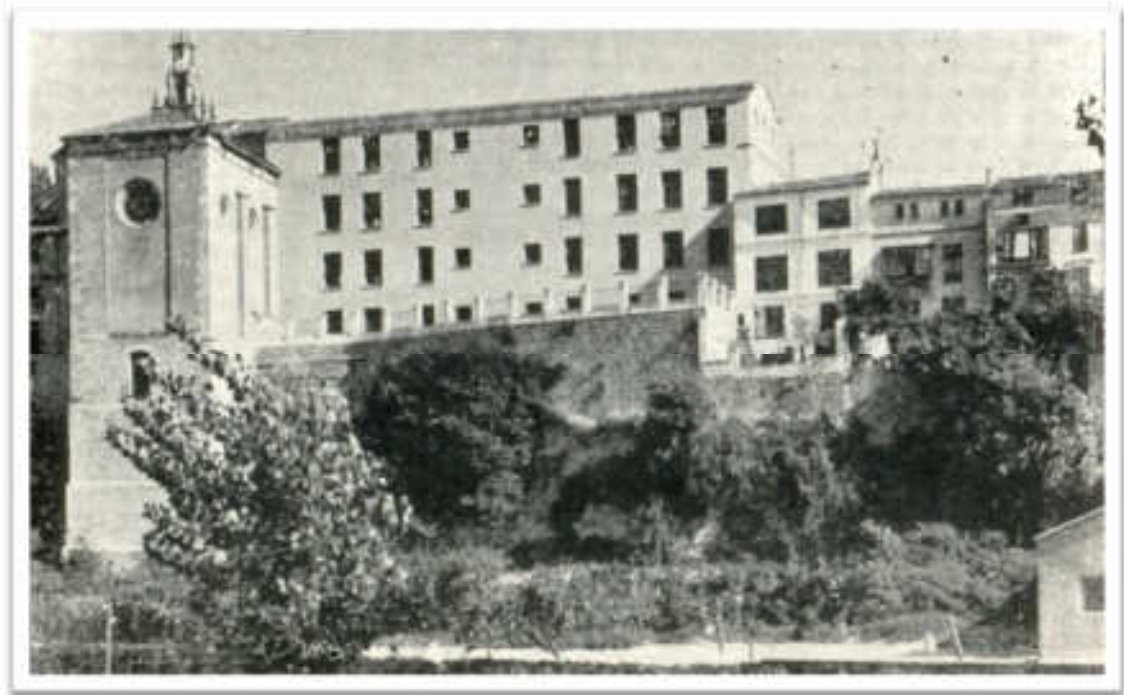
EDIFICI DE SANT CARLES, ANTIC CONVENT DELS JESUÏTES.1950
