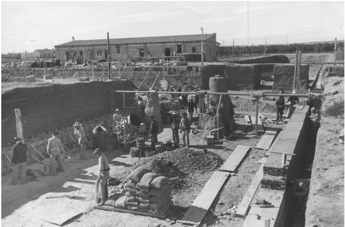
Proceso de construcción del Seminario Mayor de Moncada.
