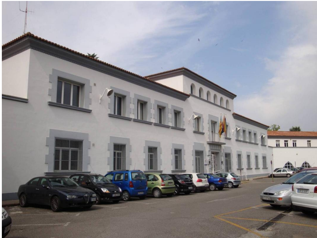
Fachada principal del antiguo Hospital Municipal de Infecciosos de Valencia, actualmente Escuela Valenciana de Estudios de la Salud (EVES) en Juan de Garay 21. El edificio original está además adaptado en los sectores siguientes a Centro de Salud Pública C.I.P.S., junto con el Hospital Pare Jofré, ambos en calle San Lázaro.
