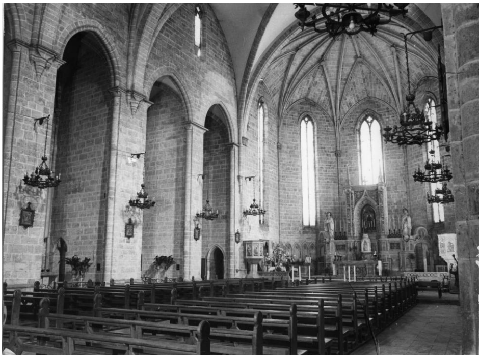
Interior de la Iglesia de San Agustín tras la intervención.
