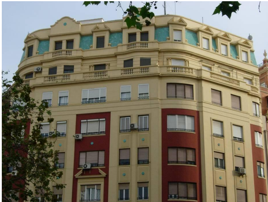
R. Roso Olivé, 1946. Edificio para José Tormo en Gran Vía Ramón y Cajal 47 esquina a Historiador Diago.
