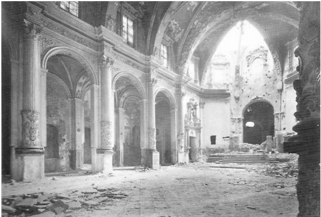
Iglesia de Santa Catalina en estado de ruina, 1939.
