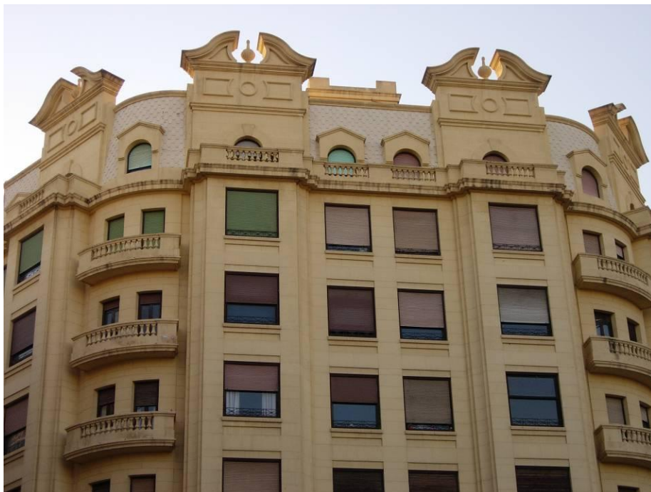
J.L. Testor Gómez, 1945-1947. Edificio para Arturo Martínez en calle Guillem de Castro 59 esquina a Ángel Guimerá.
