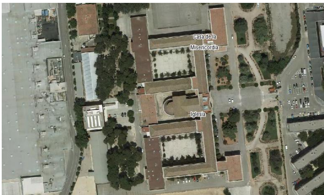
Antigua Casa de la Misericordia. Fotografía aérea del Ayuntamiento de Valencia, 2008.
