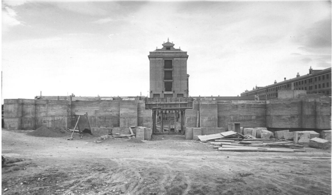
V. Traver. Construcción del Seminario Mayor de Moncada.
