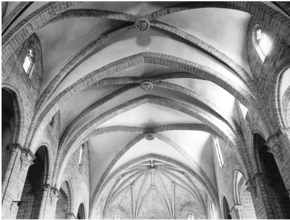
Nave central de la Iglesia de San Agustín tras la intervención.
