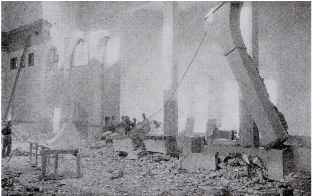
Iglesia Nuestra Señora del Socorro. Derribo del templo provisional.
