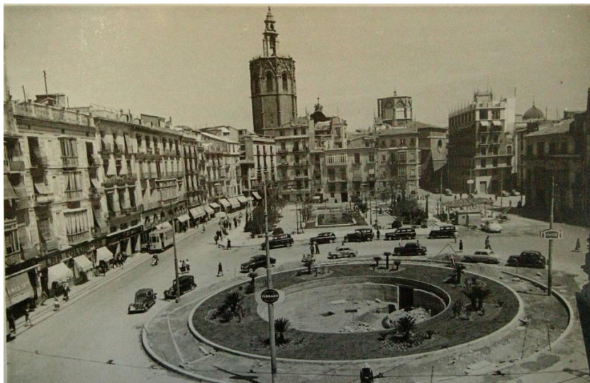
Fase de ejecución, según la propuesta municipal, de las obras de la Plaza de la Reina, mayo de 1957.
