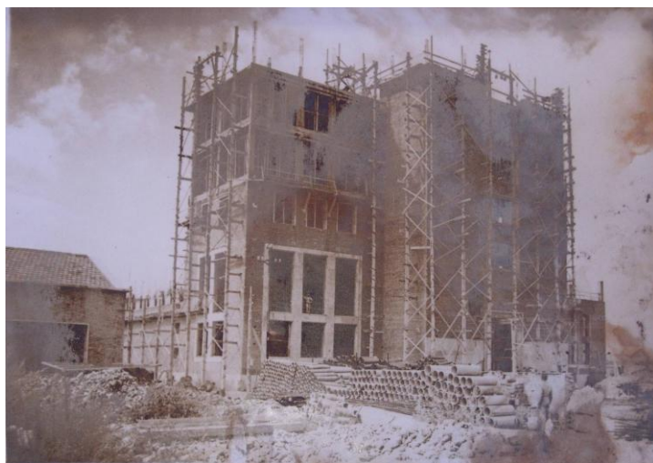
Edificio El Águila en construcción.
