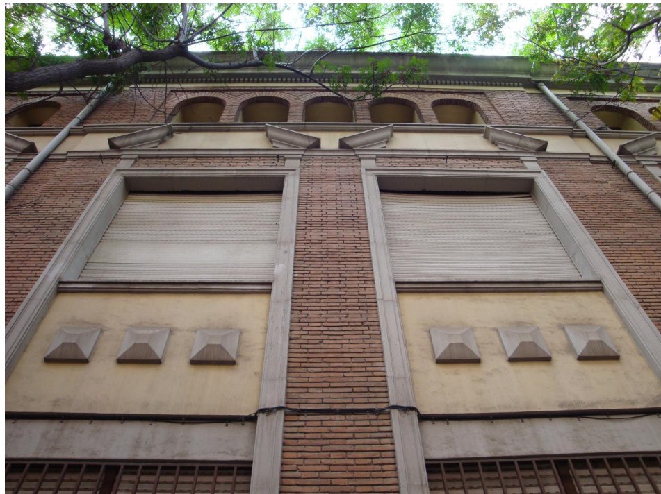
Grupo escolar Teodoro Llorente , fachada a calle Erudito Orellana, detalle. Fotografía tomada en 2009.
