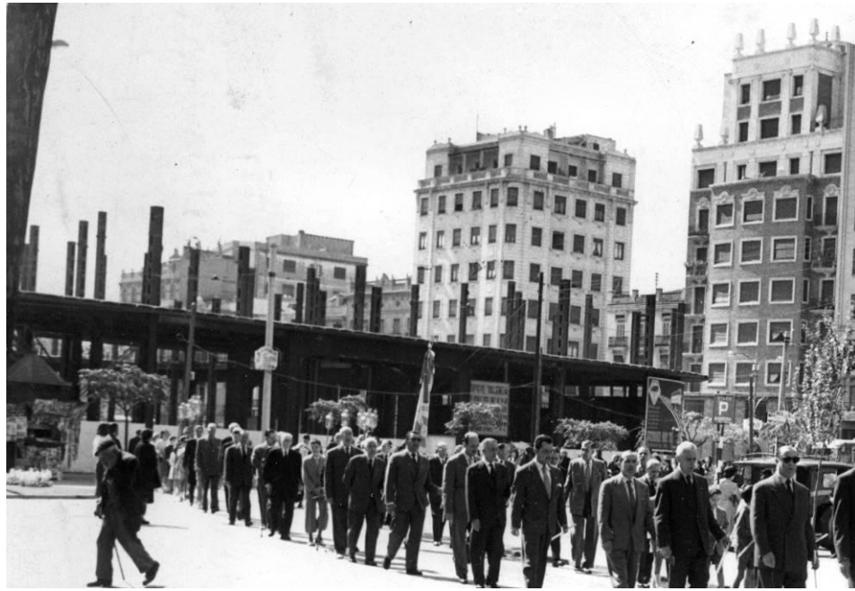
Finca de Hierro en construcción.
