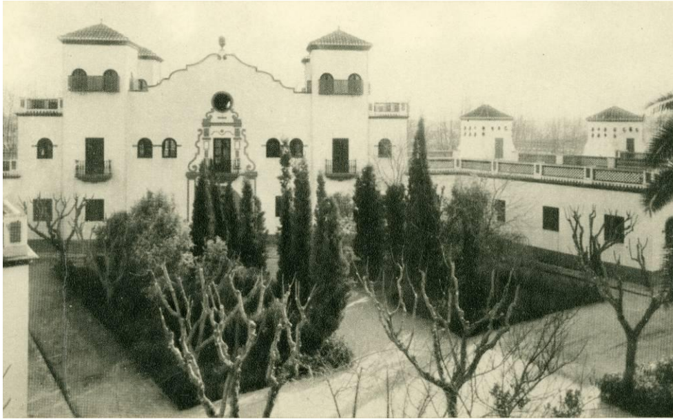
A. Gómez Davó, 1939-1941. Grupo San Francisco Javier de Campanar. Pabellón de entrada. Fotografía: Biblioteca Valenciana, Colección José Huguet.
