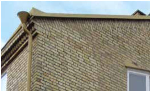
Flätning av tegel på gaveln.
