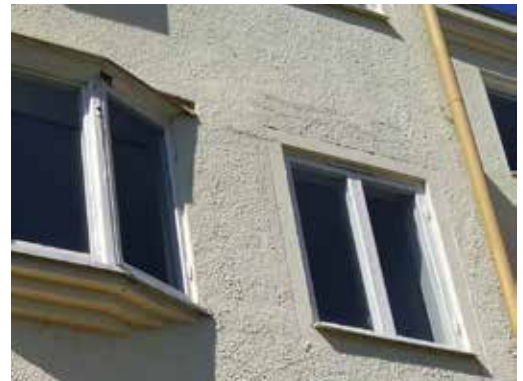
En lagning efter en trolig läcka på en vattenledning.
