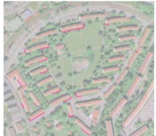
Fasader med stora fuktläckage under 2007-2010. Inventering av Bostadsbolaget (Boservice, 2012).
