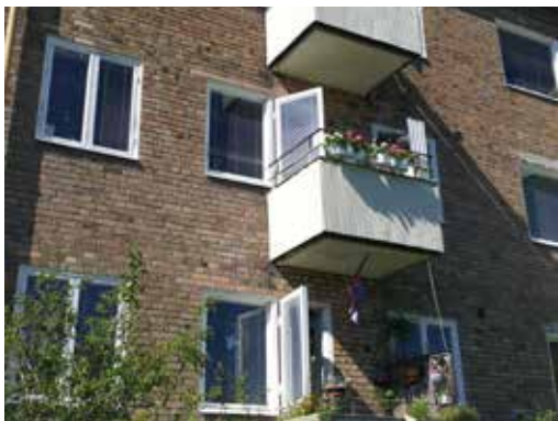
Ibland är det slitna teglet över fönstren utbytt.
