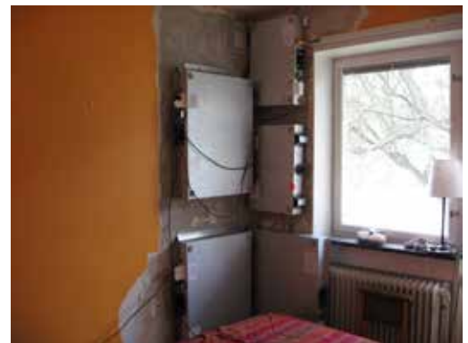
Infra-torkning av en lägenhetsvägg. Det är en typisk åtgärd för att torka ut väggen efter fuktgenomslag. Under tiden torkning pågår evakueras och stängs rummet. Foto: Johan Wilck på Bostadsbolaget.
