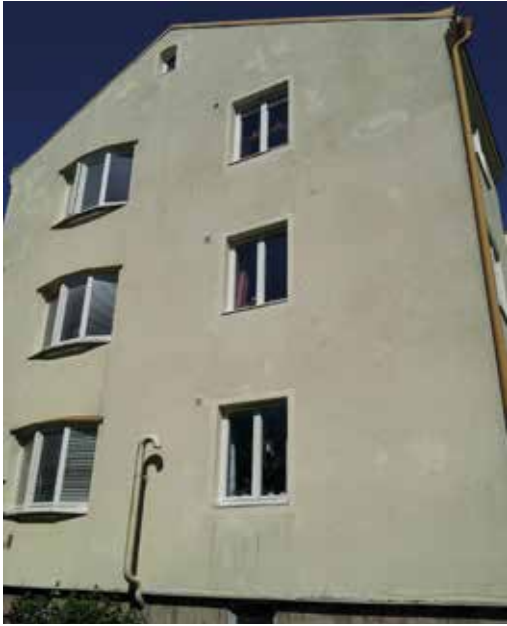
En tilläggsisolerad gavel.
