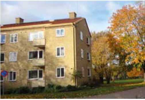
Sadeltak med röda tegelpannor.
