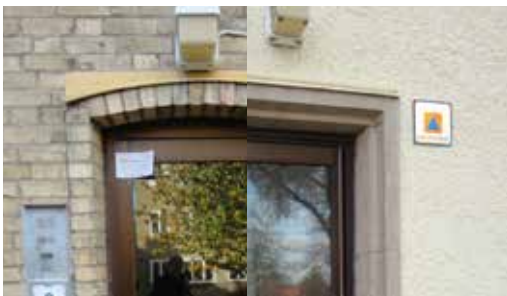
Omsorgsfullt gjorda dörrömfattningar.
