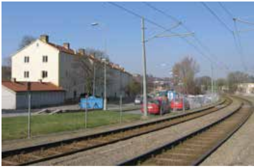
Spårvagnsspåren utgör en barriär från Torpa norrut. Foto: Annika Danielsson
