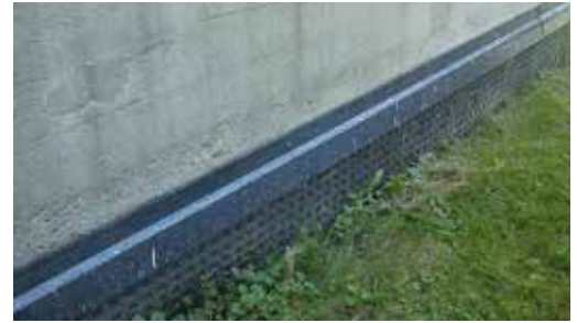
Dräneringsmatta längs källarväggen.
