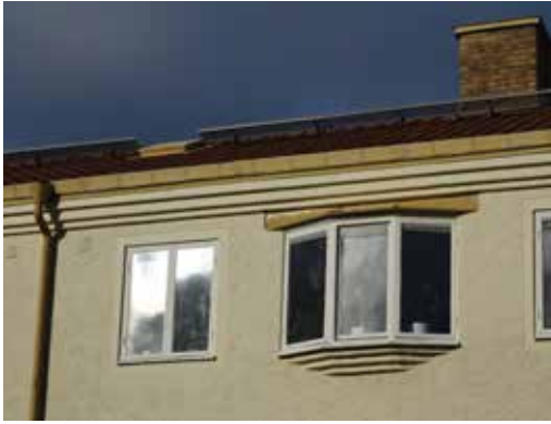
Takfot och burspråk på ett putshus.
