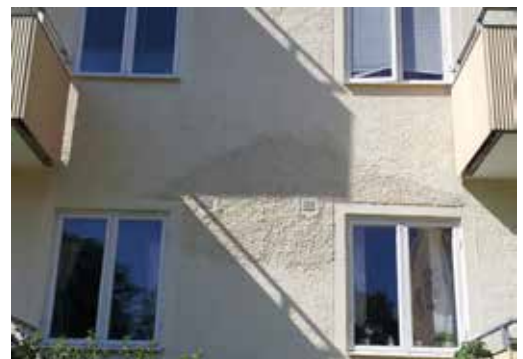
En lagning efter en vattenläcka inuti byggnaden.
