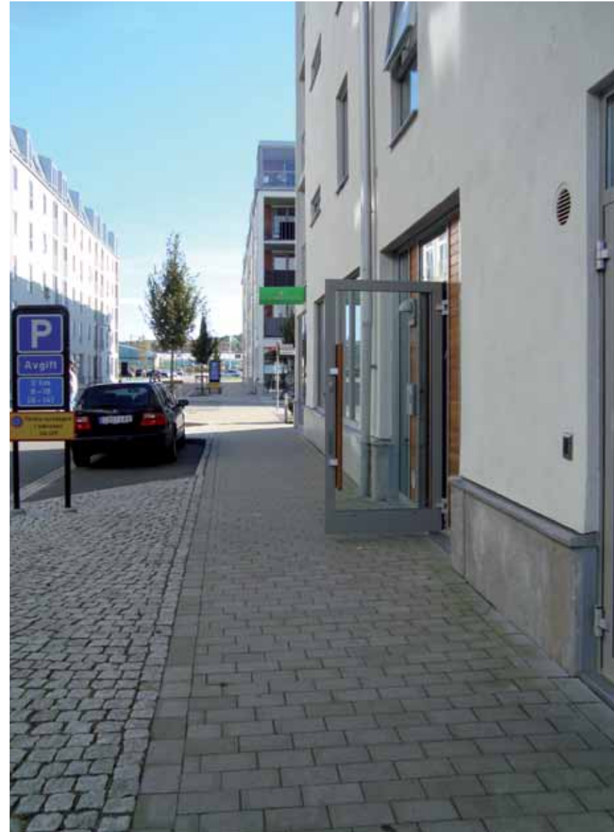
Entrédörrar som öppnas mot trottoaren ger en osäker trafikmiljö. Många klagar på att cyklister gör trottoaren osäker.
