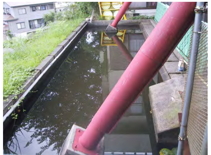
写真 2 落下堆積雪の融雪池と地震対策の丸太材
