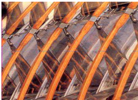
図 5-8 ピラミッド型樹枝製の屋根をチューブ状に並べて造った 空港の休憩スペースの屋根
