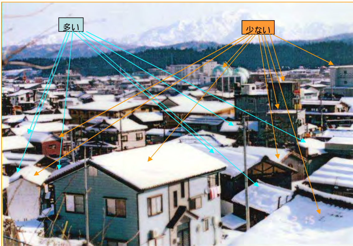
図 1-5 市街地における屋根上の積雪と融雪の様子
