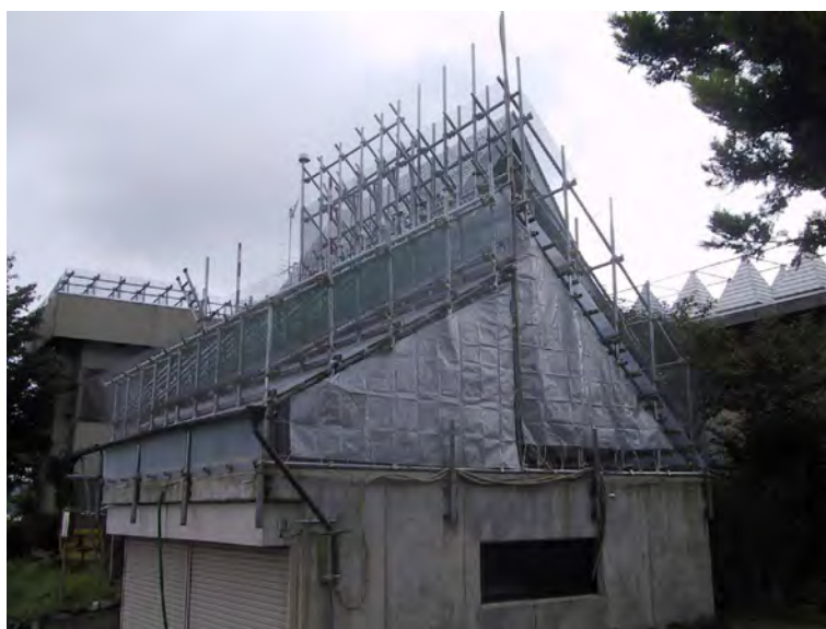
図 3-3 実験建物の外観
