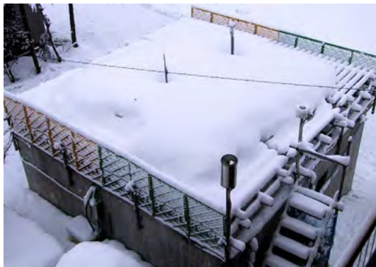
図 2-52 雪がかなり多く装置の上に残っている様子 屋根上 80cm/地上 120cm H13.3.11
