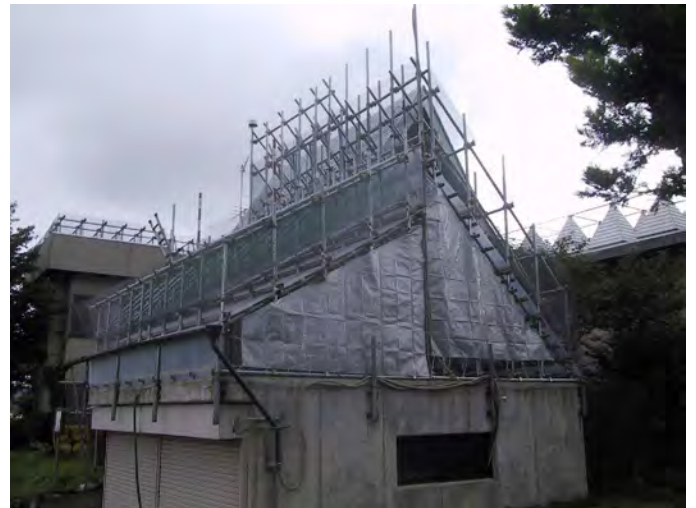
写真3 車庫の屋根に設置した30°と45°の実験屋根
