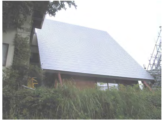
写真 1 フロック雪崩現象が発生しない 60°の急勾配屋根
