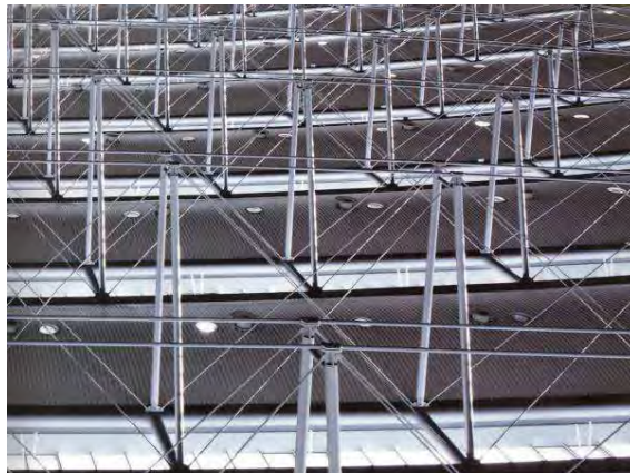
図 5-21 水平小屋組のトラスを屋根の上に出し吊っている空港の屋根 設計者 VON GERKAN, MARG ( 出展 : THE ARCHITECTURE OF VON GERKAN, MARG + P ARTNERS, TRADE FAIR, HANOVER, PRESTELL )
