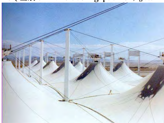
図 5-9 砂漠にキャンバスをピラミッド型に張って造った空港の屋根
