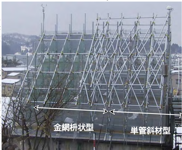
平成十五年（一）二月に行った実験建物（新潟県柏尾市原町）
