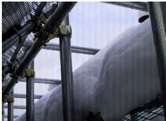
図 2-61 雪がI鉄パイプ メタルに積もり通気が確保されている様子(側面)
