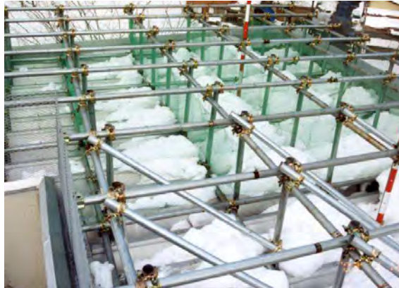
図 5-18 地上の積雪が 37cm の時の積雪の様子 H15.1.12 於栃尾市原町
