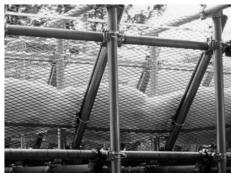
写真1 通気融雪工法屋根の外観
