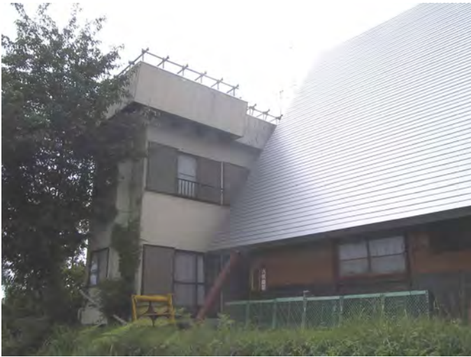
写真 3 南北の複式折板の空洞に通気を確保した屋根
