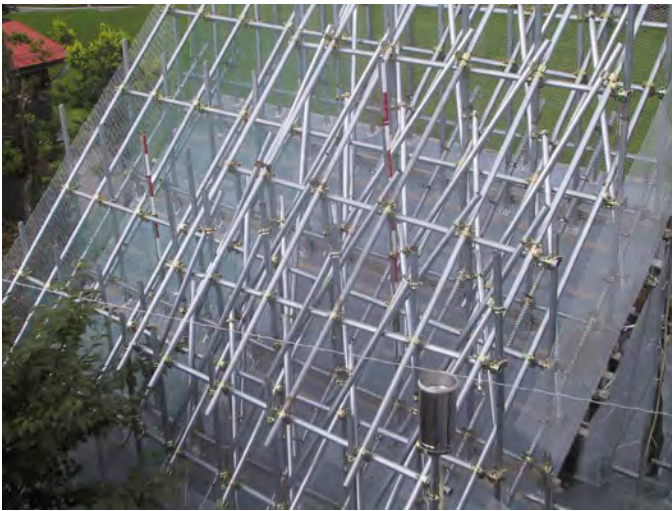
写真 9 桁状に金網で仕切った部分(左)と斜材を入れた部分(右)
