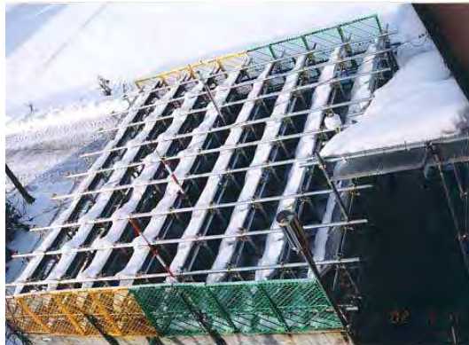
図 2-56 北側の鉄筋部分の融雪が顕著になり出した様子 地上 30cm H14.1.7
