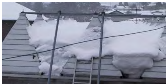
図 5-6 地上の積雪が 120cm の時の積雪の様子 H12.2.3 於栃尾市原町
