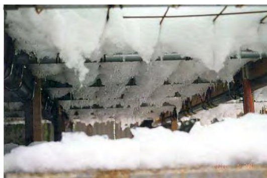
図 2-31 垂れ下がった雪に小さな氷柱が発生し融けている様子 H12.1.30
