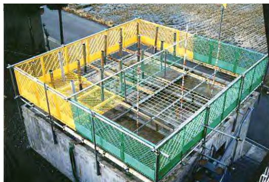
図 2-19 実験装置の様子（西：鉄筋、中央：FRP、東：プラスチック&エキスパンドメタル。南側：融雪促進用にステンレス製筒） 於栃尾市原町 H12.1.9
