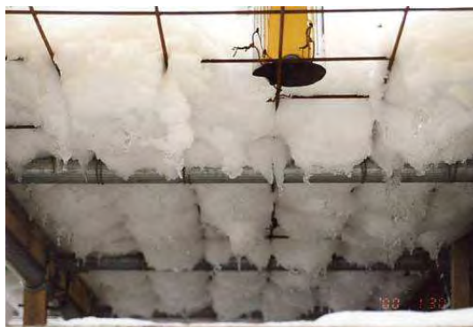
図 2-32 雪が垂れ下がり覆っている所に筒の周りには穴が開いている様子 H12.1.30
