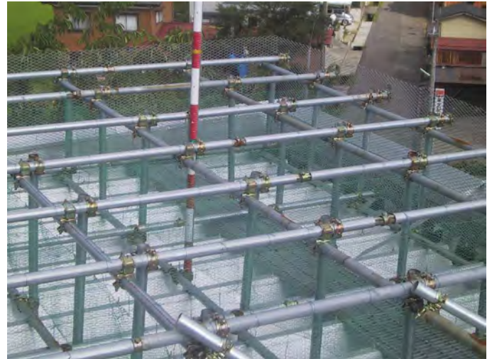
写真 1 複式折板屋根の上に単管で立体格子を組み柵席状に金網で囲った様子
