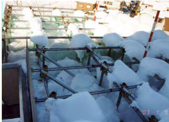
図 5-16 地上の積雪が 60cm の時の積雪の様子 H15.1.9 於栃尾市原町
