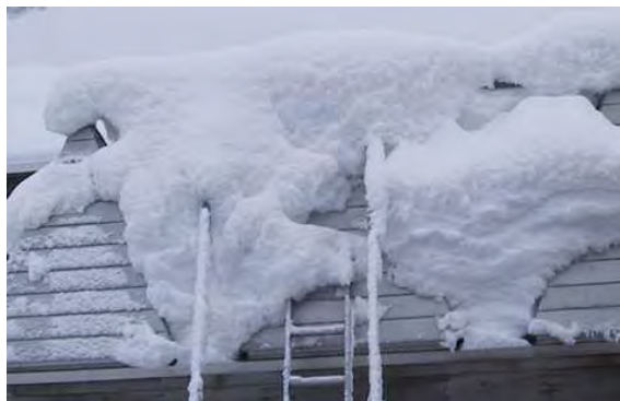
図 5-5 地上の積雪が 130cm の時の積雪の様子 H12.1.22 於栃尾市原町
