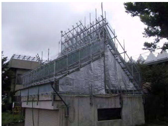
写真8 車庫の屋根に設置した30°と45°の実験屋根
