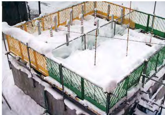
図 2-28 装置全体に新雪が被さった2回目の様子 H12.3.10
