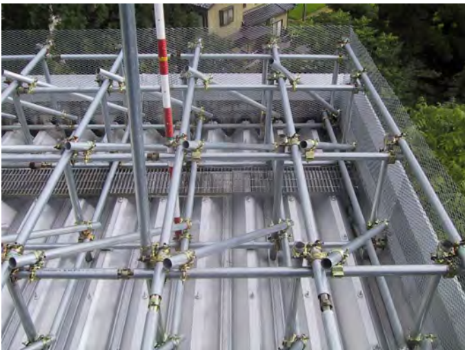
写真 5 複式折板屋根の上に単管で立体格子を組み斜材を入れて積雪層を不安定にした様子
