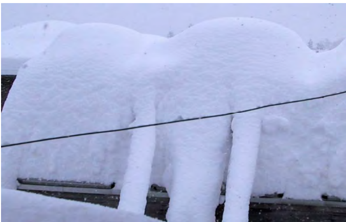
写真11 ピラミッド形屋根の頭繋ぎが埋まった様子H13.1.17
