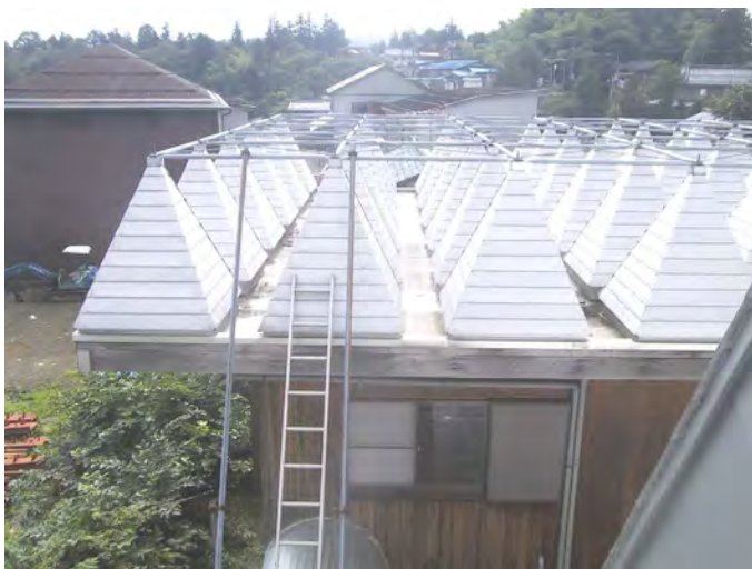
写真6 ピラミッド形屋根の上部からの全体的な景観
