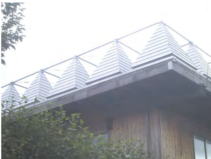
写真7 1.8mの軒の出は雪囲いを不要とする経済設計
