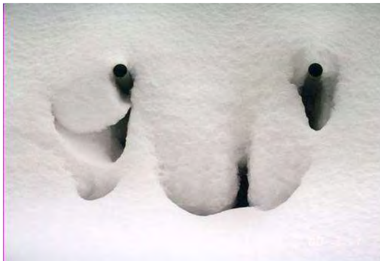
図 1-9 積雪層内の空洞 於栃尾市原町 H12.3.11
