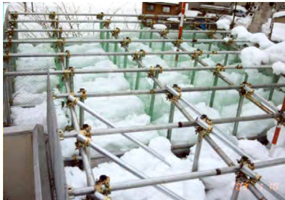
図 5-17 地上の積雪が 50cm の時の積雪の様子 H15.1.10 於栃尾市原町
