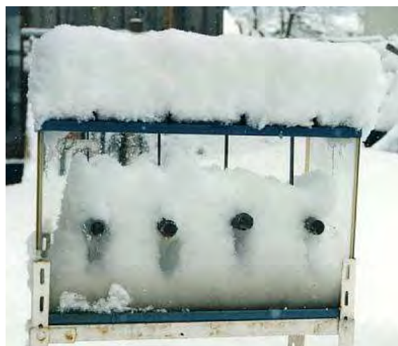
図2-2 雪が降り積もりパイプが埋もれ空洞が発生している様子 H9.2.21
