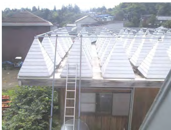
図 5-1 ピラミッド形屋根の上部からの全体的な景観
