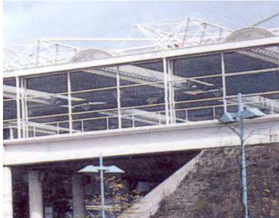
図 5-20 水平屋根に小屋組のトラスを載せて吊っている駅のプラットホーム 設計者 Peter Kilsdonk ( 出展 : The Modern Station, Brian Edwards, E&FN SPON )
