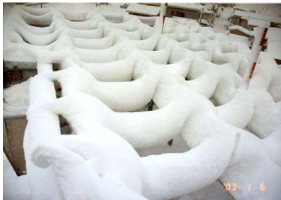
図 5-14 地上の積雪が 58cm の時の積雪の様子 H15.1.6 於 栃尾市原町
