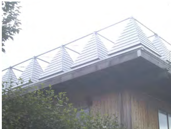
図 5-2 1.8m の軒の出は雪囲いを不要とする経済設計
