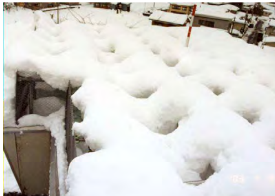
図 5-15 地上の積雪が 64cm の時の積雪の様子 H15.1.8 於 栃尾市原町
