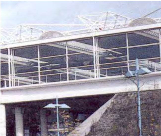
例 1: オランダ ドウイベンデウレヒト駅舎の屋根 ピーター キルズドンク設計 出展：現代の駅
