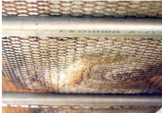
図 2-46 再凍結が繰り返され幾重にも氷が発達し重くなっている様子 H12.3.4
