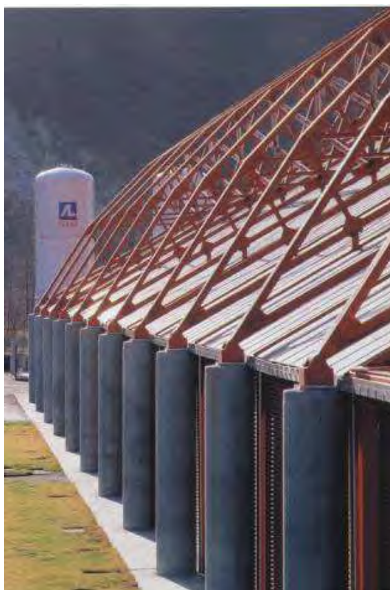
図 5-26 工場のトラスを外に出し大空間を確保している工場の屋根 設計者 Mario Botta ( 出展 : BOTTA THE COMPLETE WORKS 1990 1997, BIRKAUSER )
