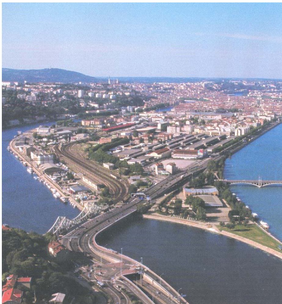
Source : Grand Lyon – plaquette d'information sur le Projet Lyon Confluence Figure 2 : Vue Sud/Nord du Sud Presqu'île – Pont de la Mulatière
