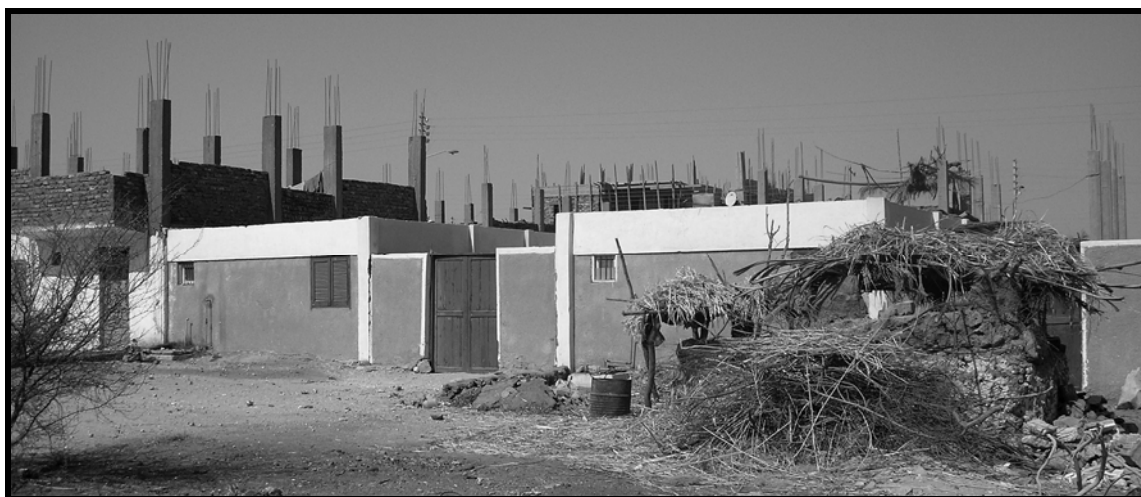
14- Village de al-Suyûl, mars 2006. Le premier niveau des habitations correspond aux constructions initiales de 1996, sur lesquelles s'ajoutent un à deux étages.
