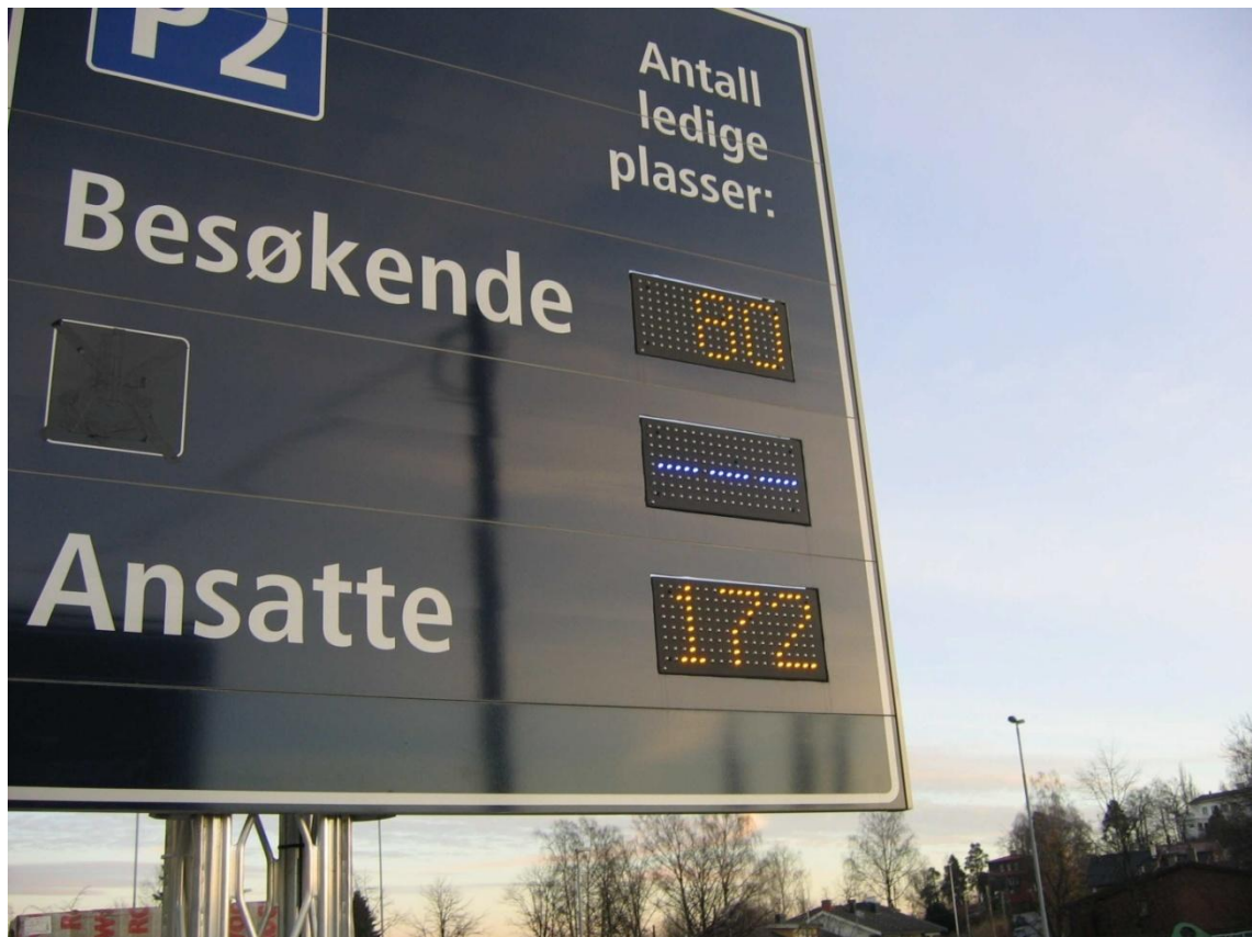
Slika 36: Primer prikazovalnik zasedenosti parkirišča, na primeru bolnišnice v Oslu
