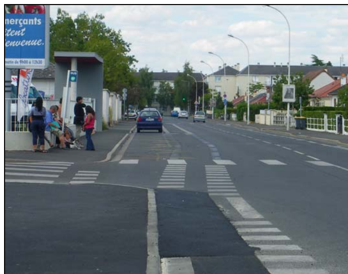
Image 8 : Après : Arrêt provisoire de déviation (Source : Keolis Tours, 2010)
