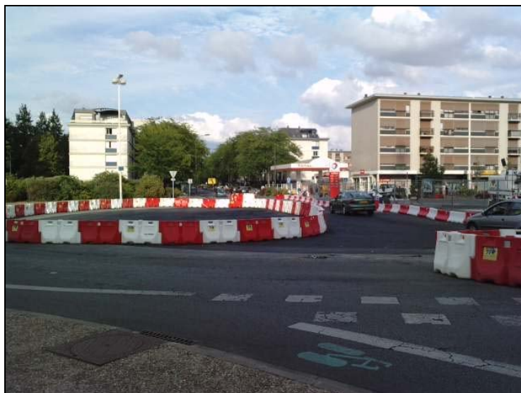
Image 10 : Goudronnage suite au dévoiement des réseaux de la Place St Paul (Source : Edith Grall, 2010)
