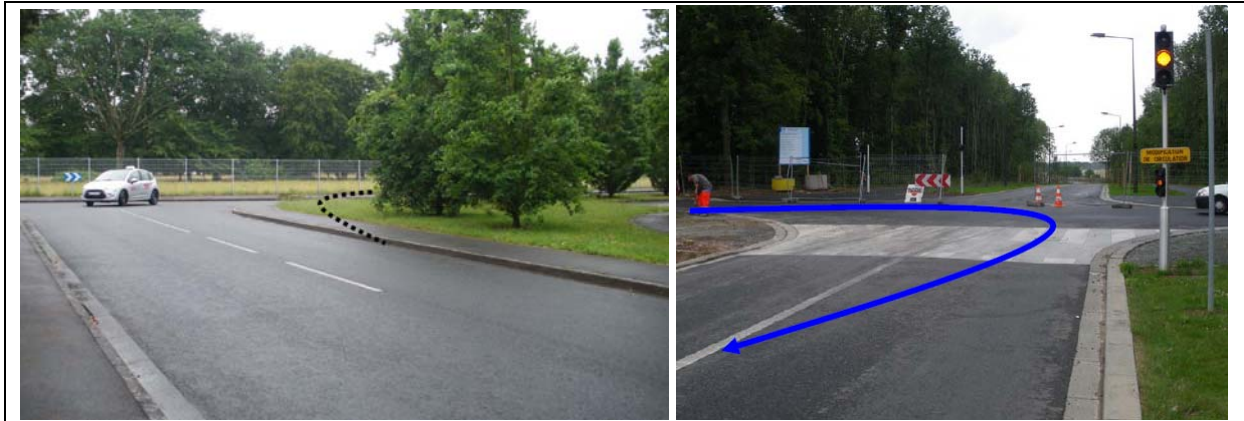
Image 6 : Nécessité de modifier les angles de carrefours et de faire reculer un feu tricolore pour permettre la rotation d'un bus (Source : Keolis Tours, 2010)
