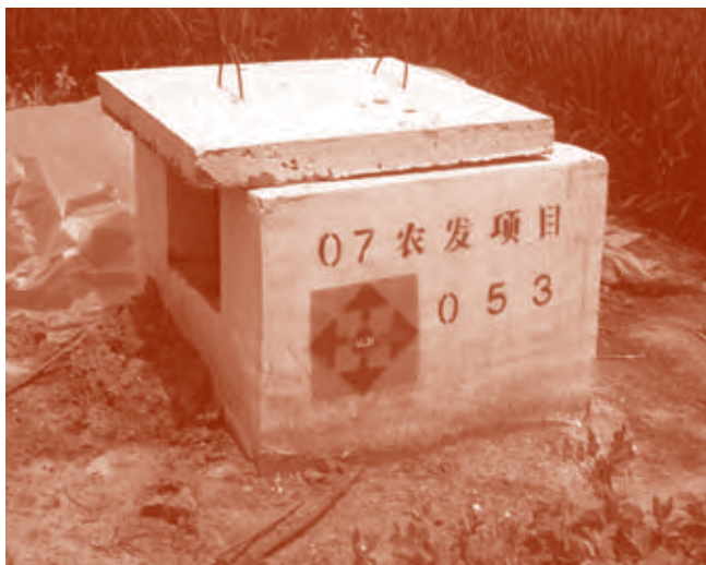
农业综合开发项目建设的井
