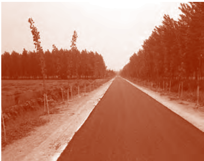
农业综合开发项目建设的机耕路
