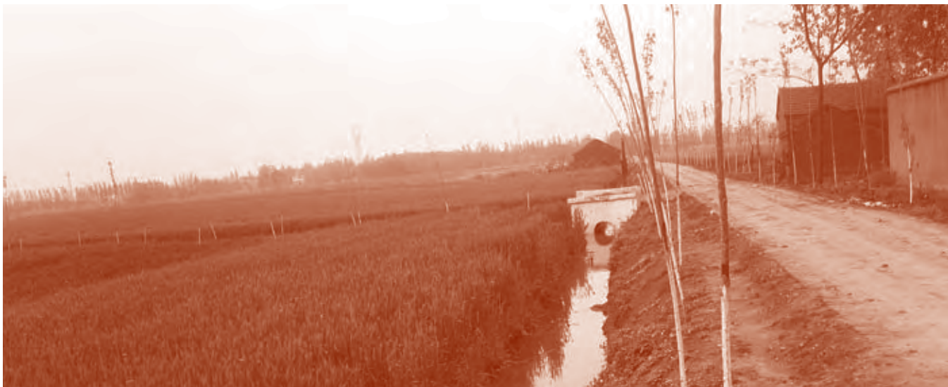
农业综合开发项目建设的渠和桥
