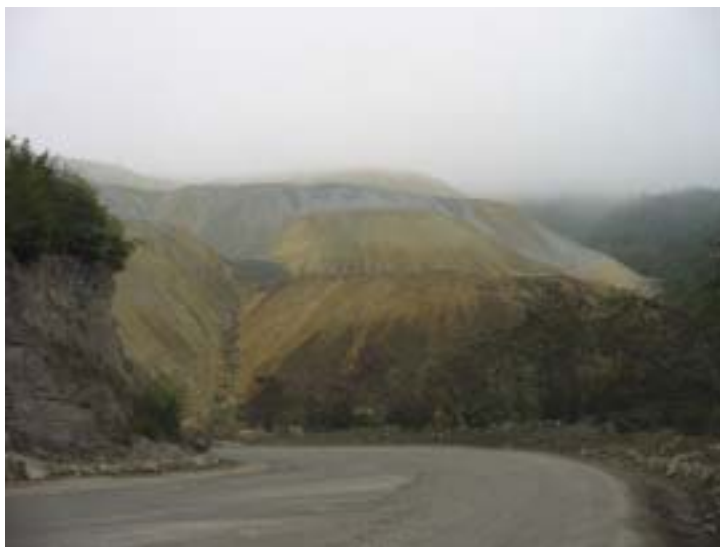
Abb. 8: Unsachgemäß angelegte Abraumhalden mit Erosionsrinnen.
