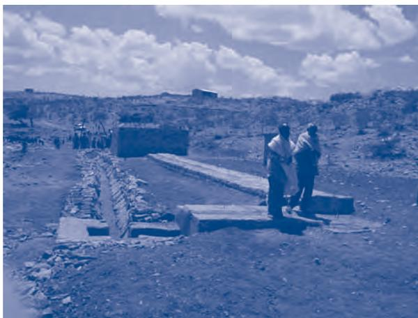
*Figura 3.16 Galería de infiltración de agua potable (derecha), en el sistema multipropósito de Adidaero, Etiopía: el canal subterráneo de la presa de derivación se divide en un canal de riego (izquierda) y en una galería de filtración (Foto: Eline Boelee)*
