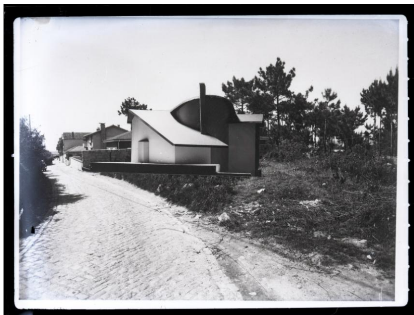
Figure 2. Detached house. Project by Architect Francisco Ferreira. Photograph of a photocollage. Archive Teófilo Rego, Casa da Imagem - Fundação Manuel Leão.
