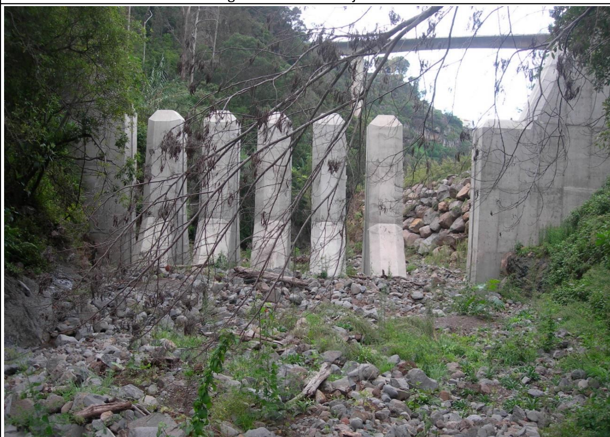
Figura A1.5: Vista de montante
