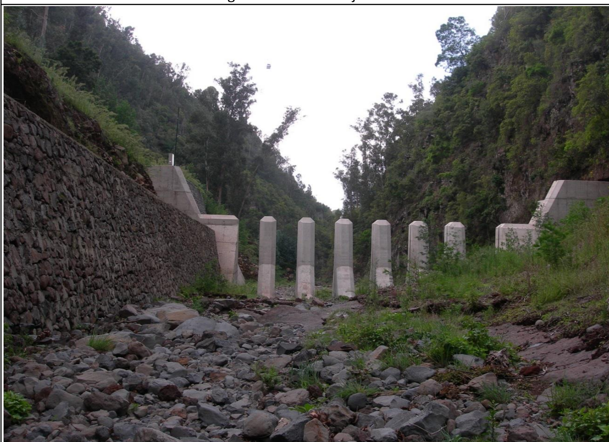
Figura A4.5: Vista de montante
