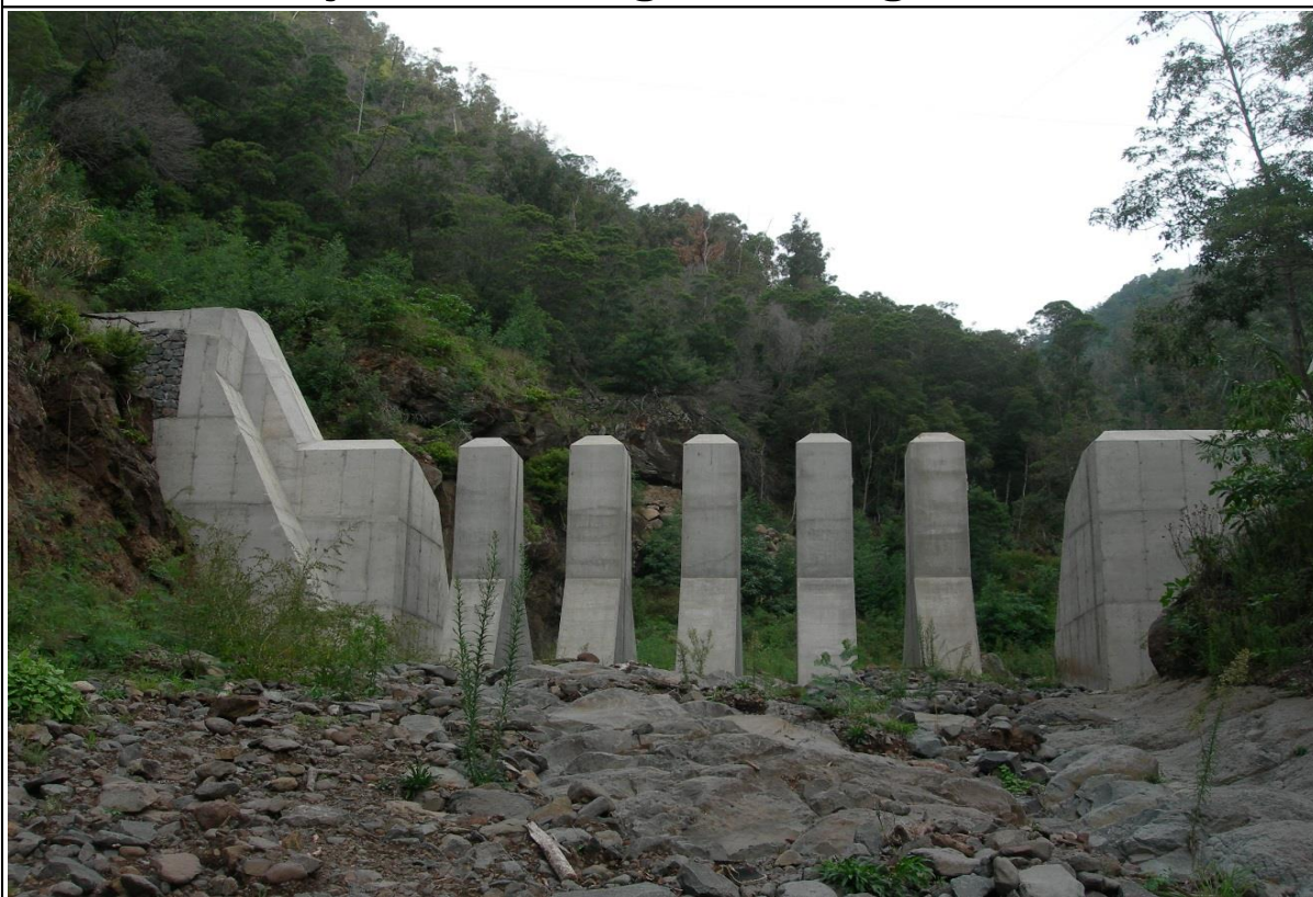
Figura A2.4: Vista de jusante
