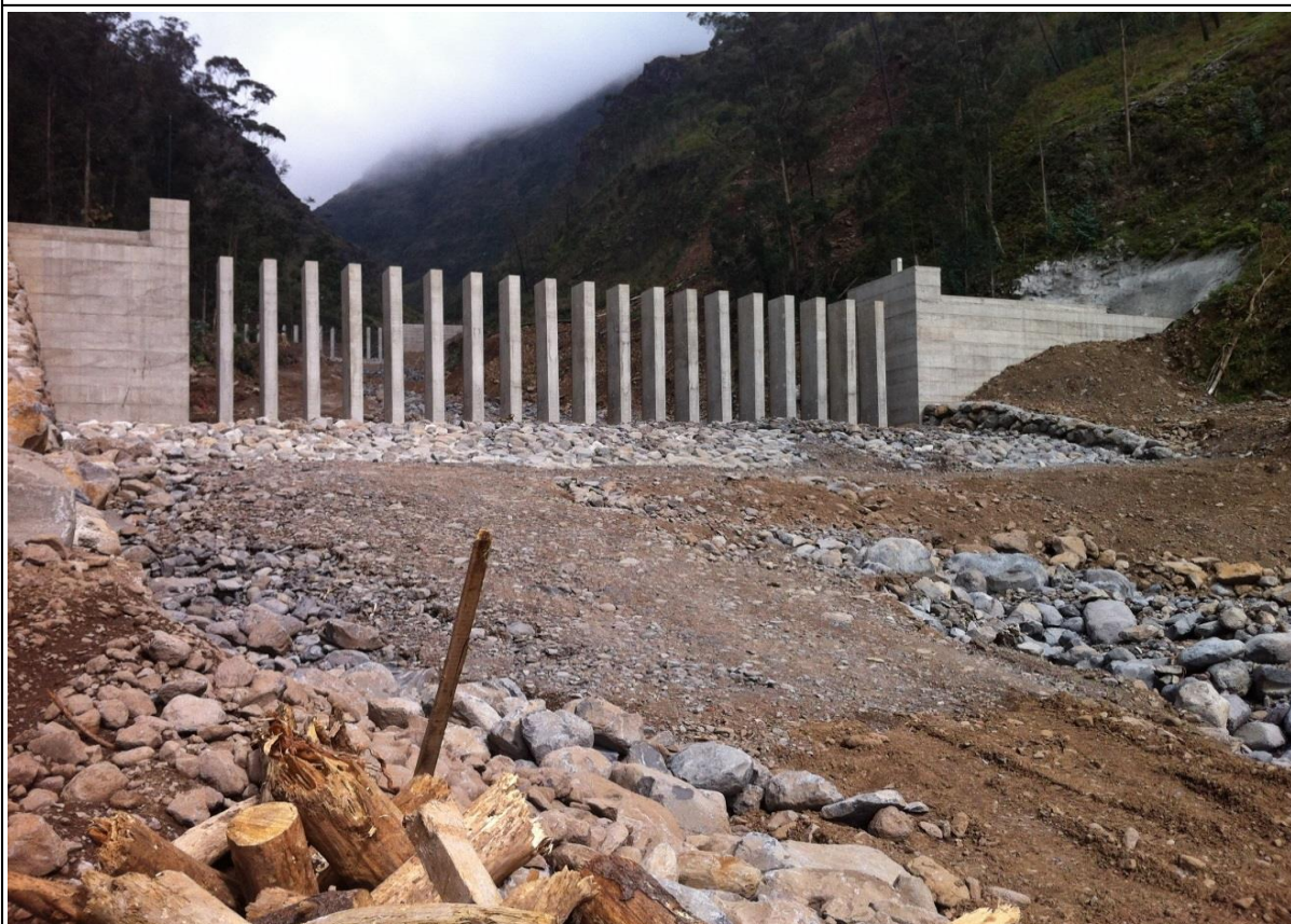
Figura A7.5: Vista de jusante
