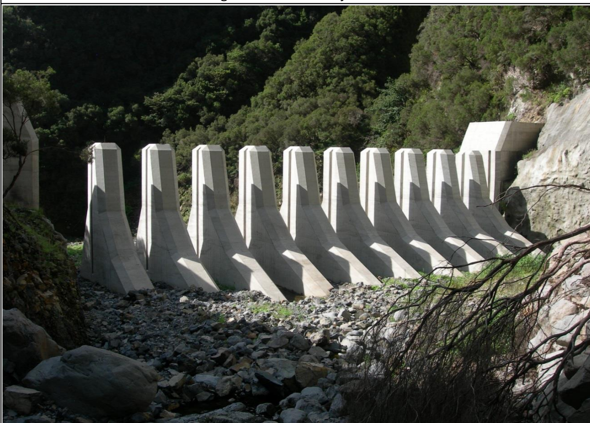
Figura A4.5: Vista de montante
