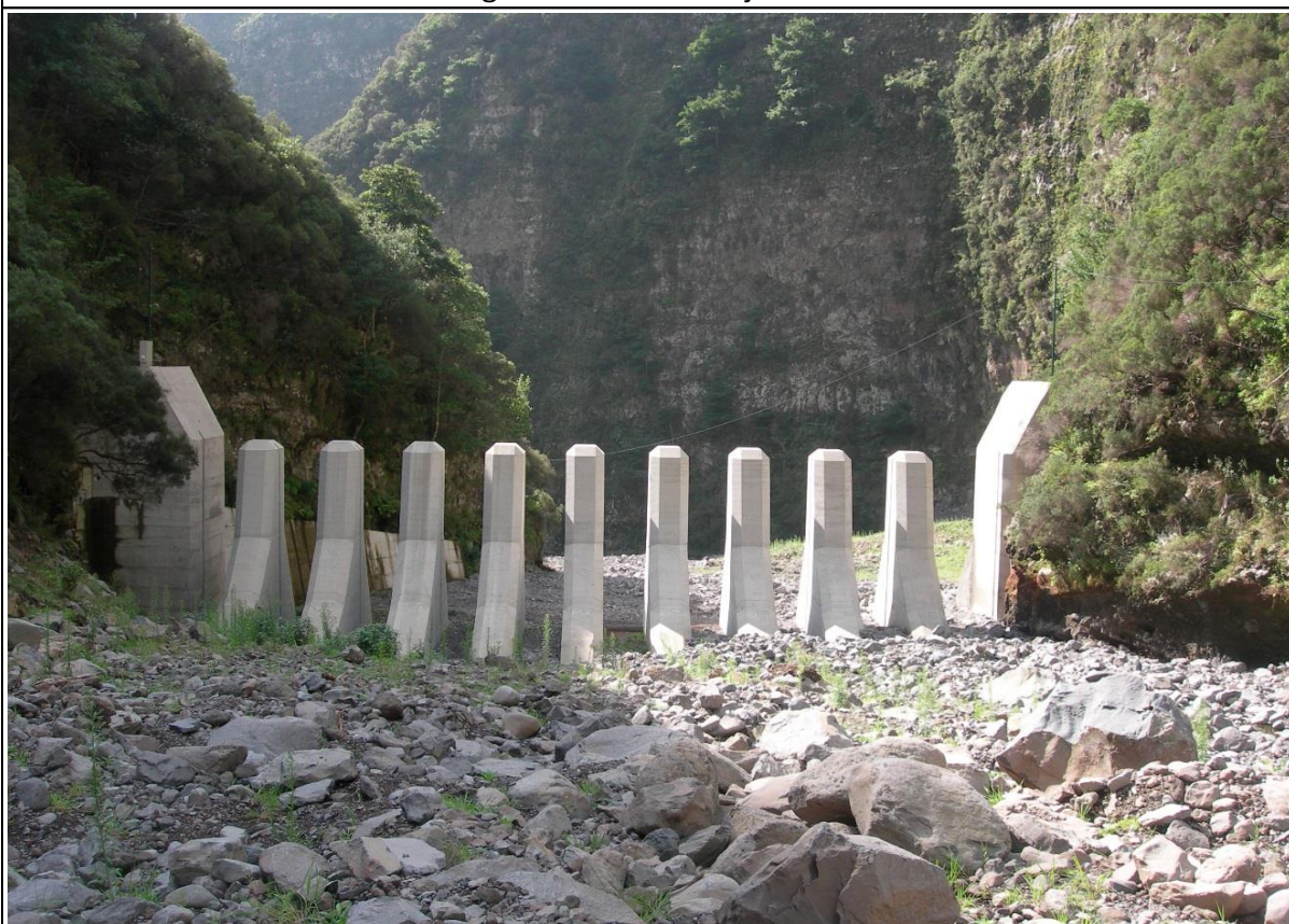
Figura A3.5: Vista de montante
