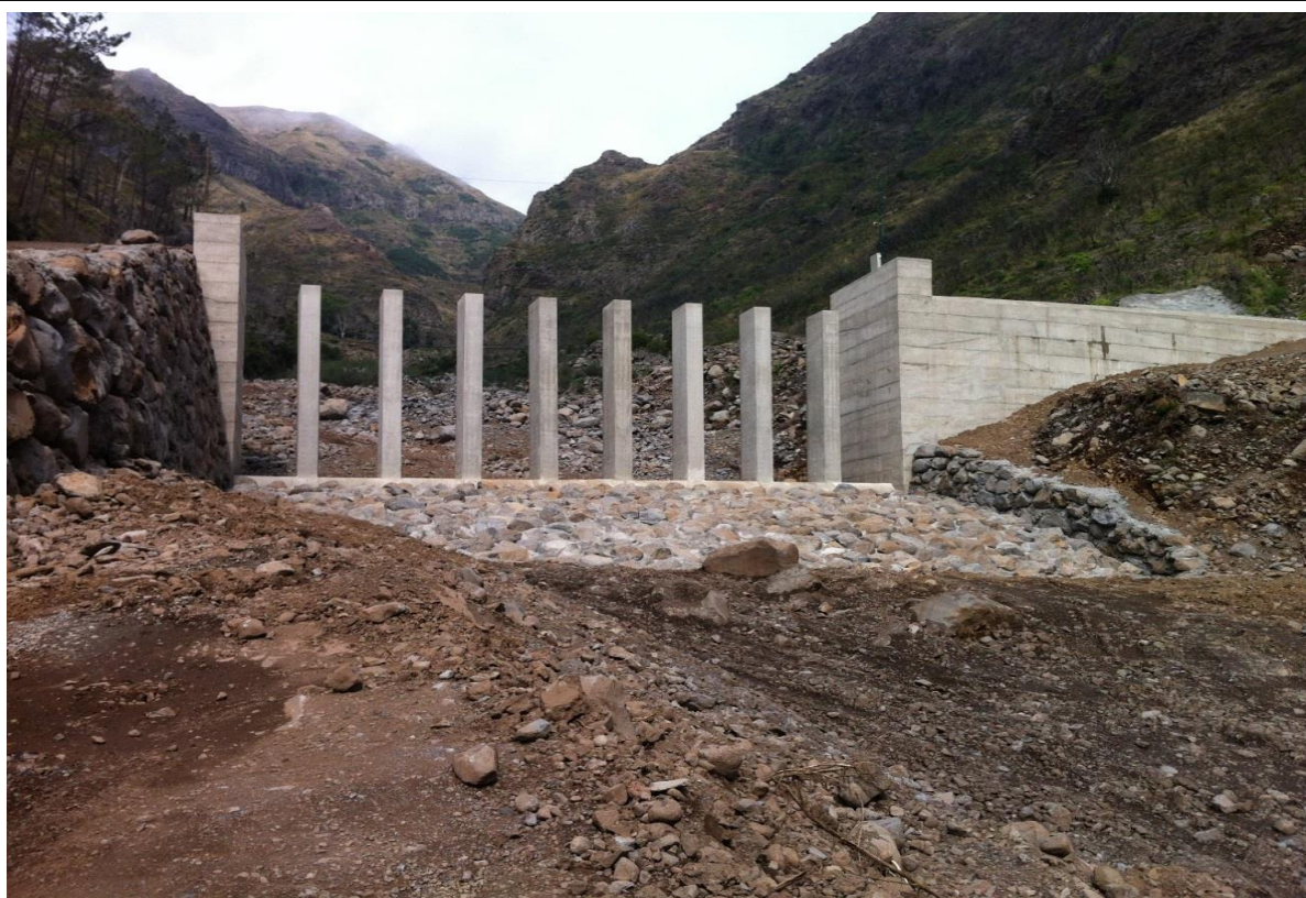
Figura A5.5: Vista de jusante
