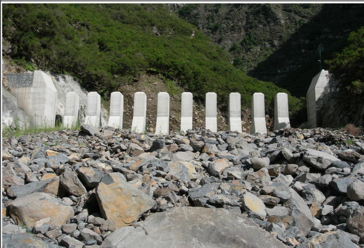
Figura A4.4: Vista de jusante
