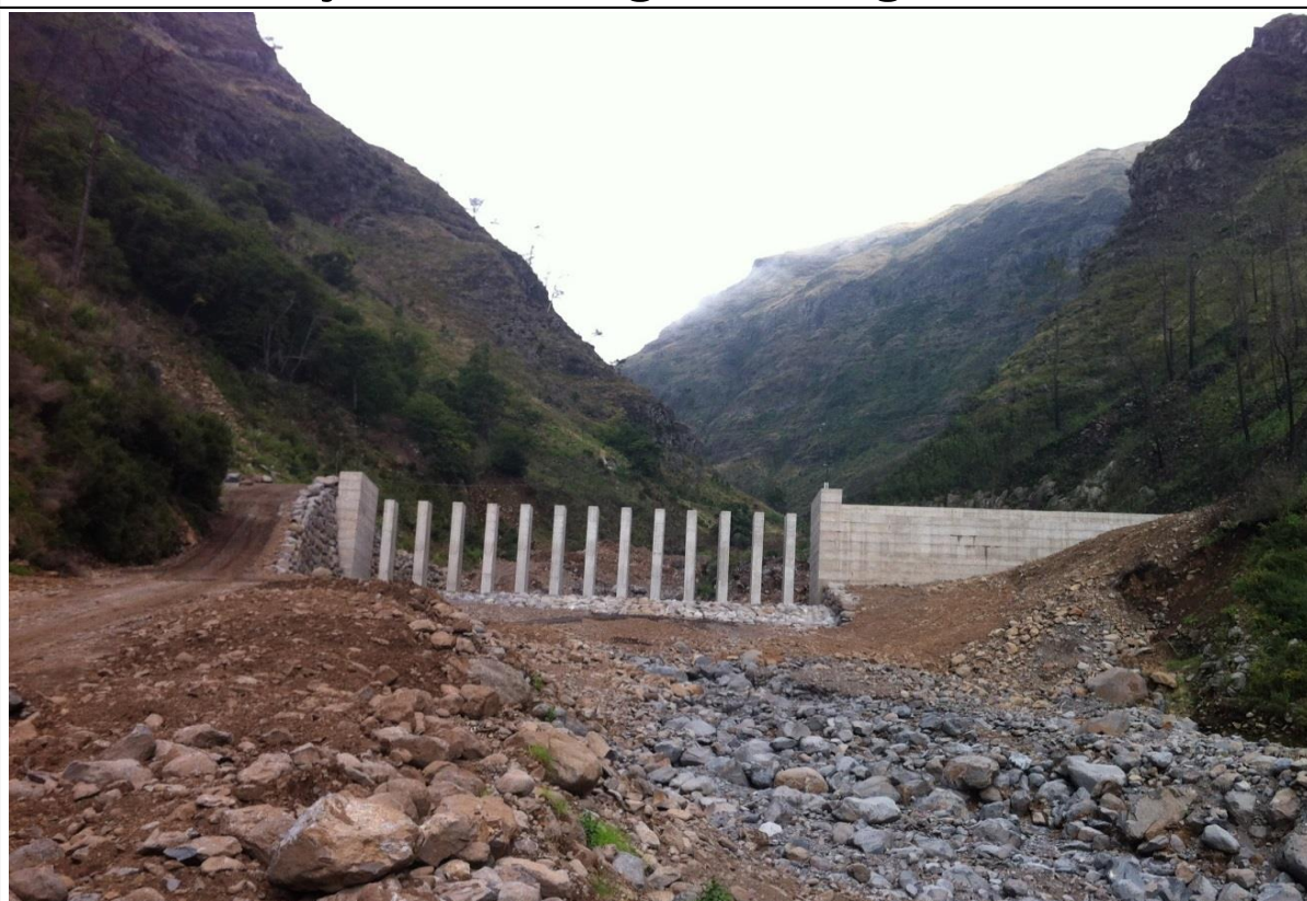
Figura A6.5: Vista de jusante
