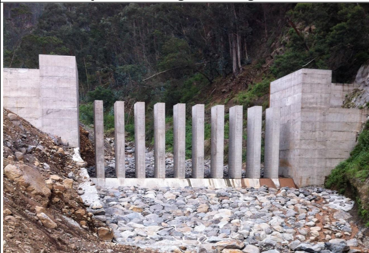
Figura A8.5: Vista de jusante
