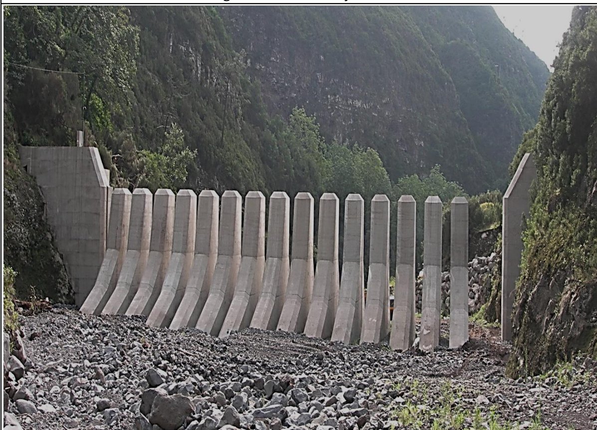
Figura A1.5: Vista de montante
