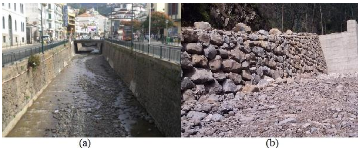
Figura 5.7: (a) - Muros em pedra cimentada. (b) - Muro em pedra
