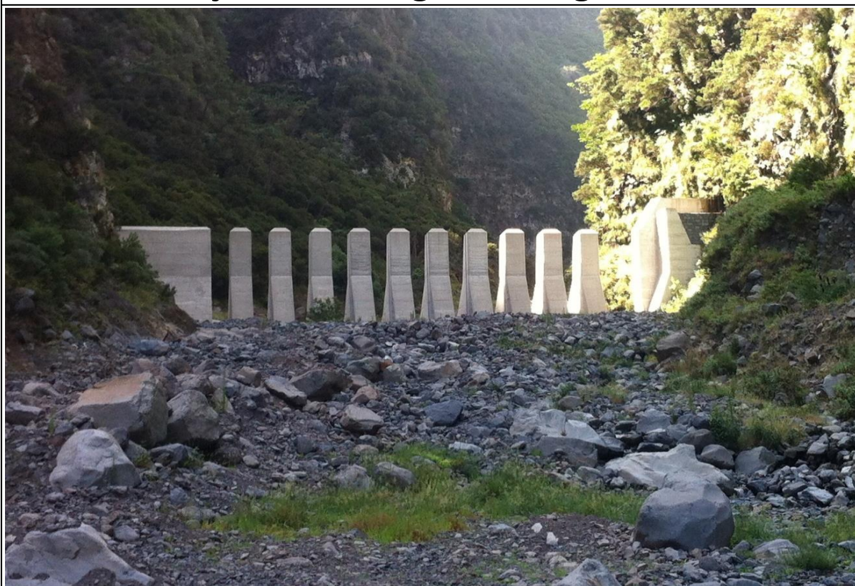
Figura A2.4: Vista de jusante
