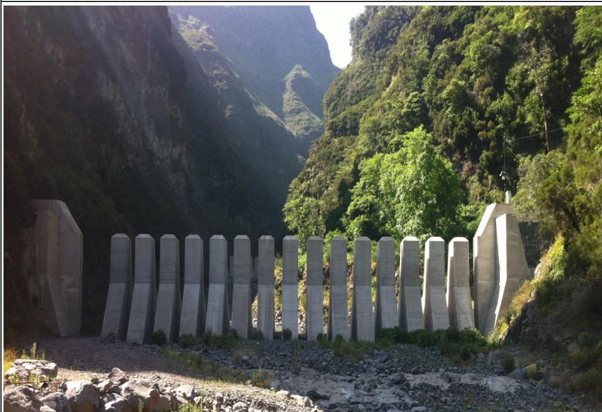
Figura A1.4: Vista de jusante
