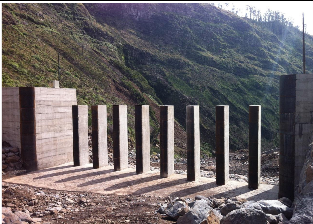
Figura A5.6: Vista de montante
