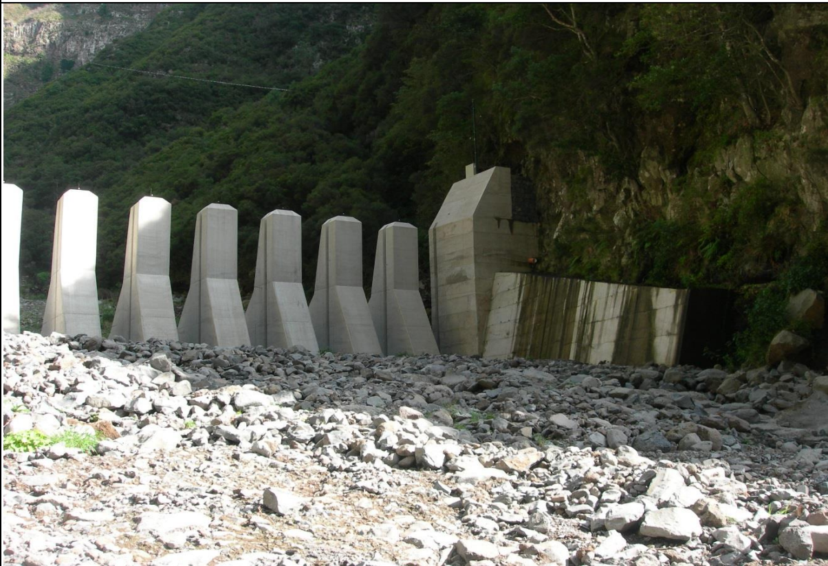
Figura A3.7: Tapete de enrocamento a jusante e encontro esquerdo
