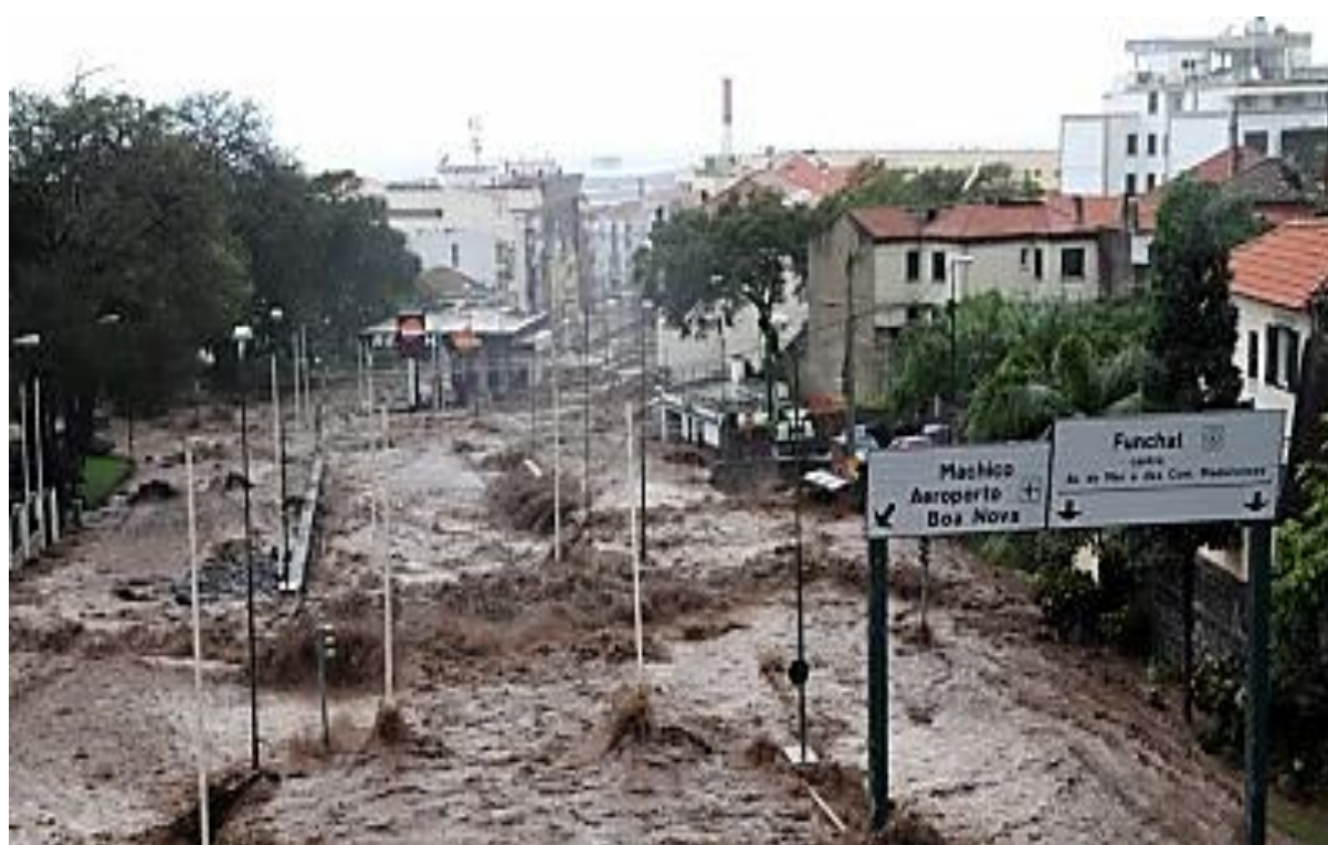
Figura 1.6: Equipamentos e infraestruturas destruídas ( http://www.meteopt.com )
