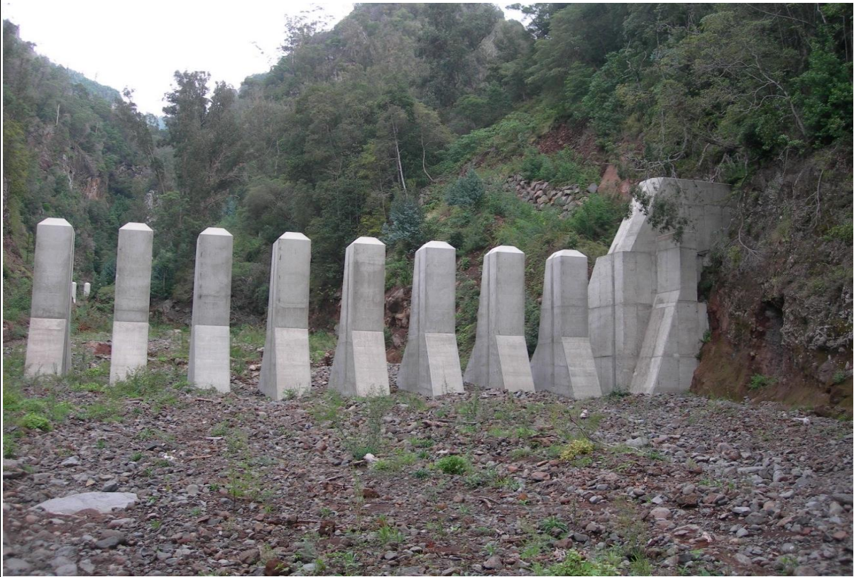
Figura A3.7: Açude parcialmente assoreado
