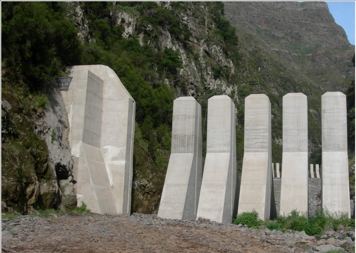
Figura A1.6: Encontro direito, com abertura de 3 metros
