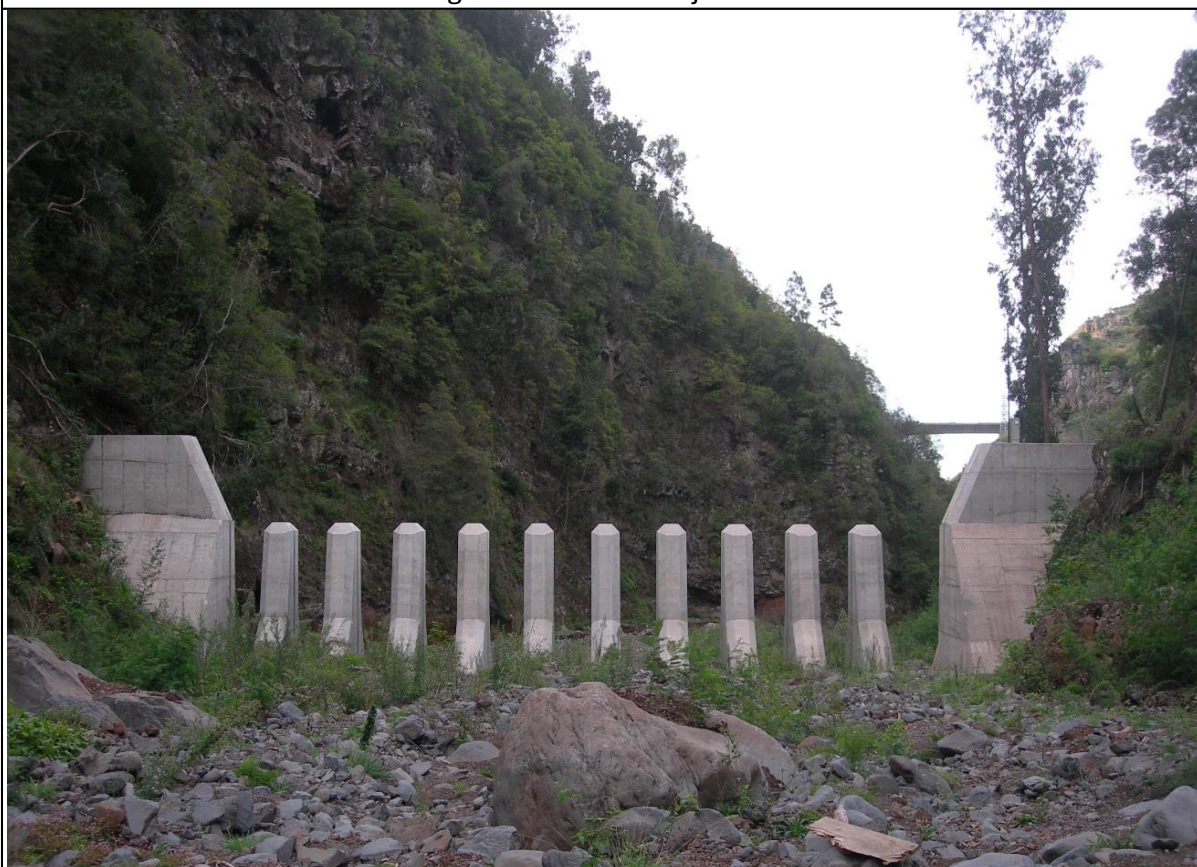
Figura A3.5: Vista de montante
