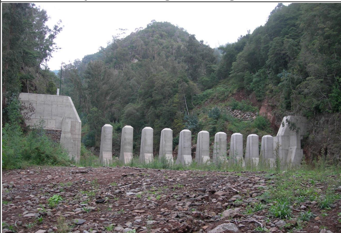
Figura A3.4: Vista de jusante
