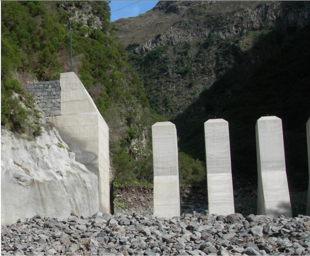
Figura A3.6: Encontro direito, com abertura de 3 metros
