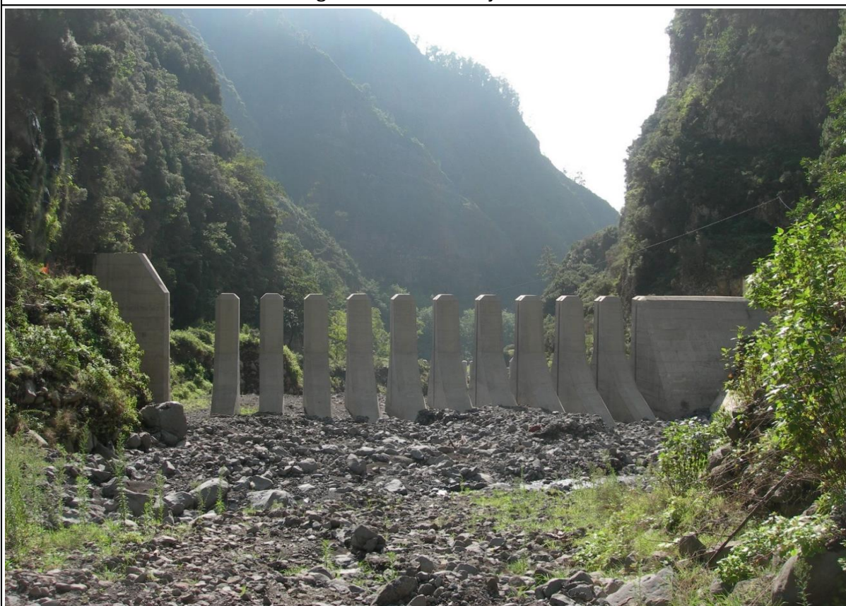
Figura A2.5: Vista de montante
