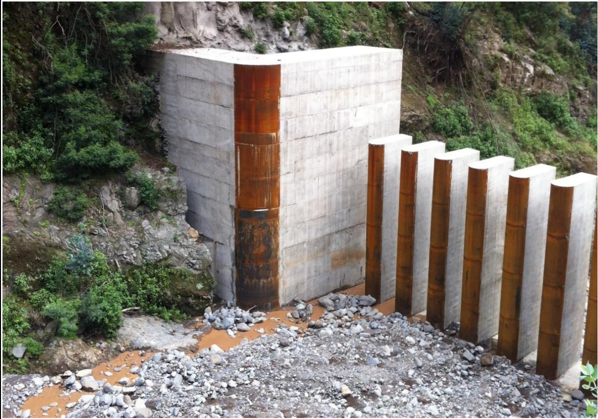
Figura A8.7: Encontros e pilares com chapas metálicas de proteção
