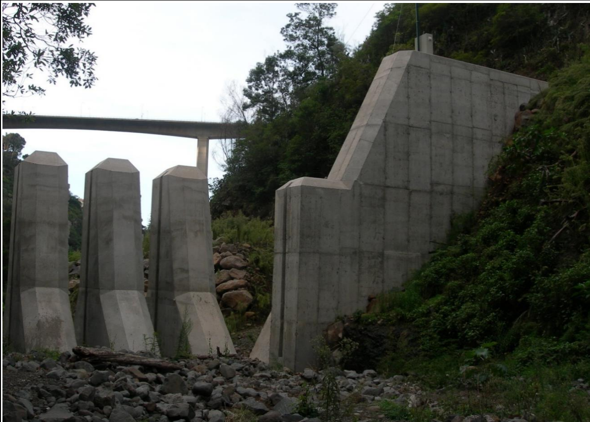
Figura A1.6: Encontro direito, com abertura de 3,5 metros
