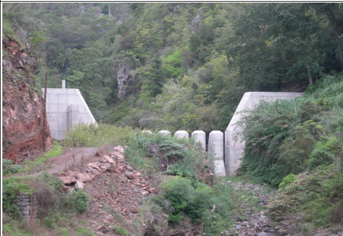
Figura A1.4: Vista de jusante
