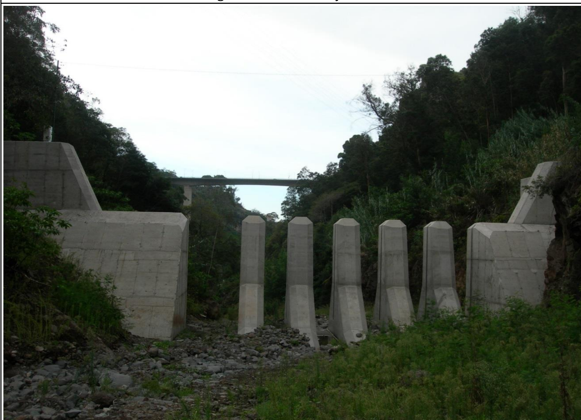
Figura A2.5: Vista de montante
