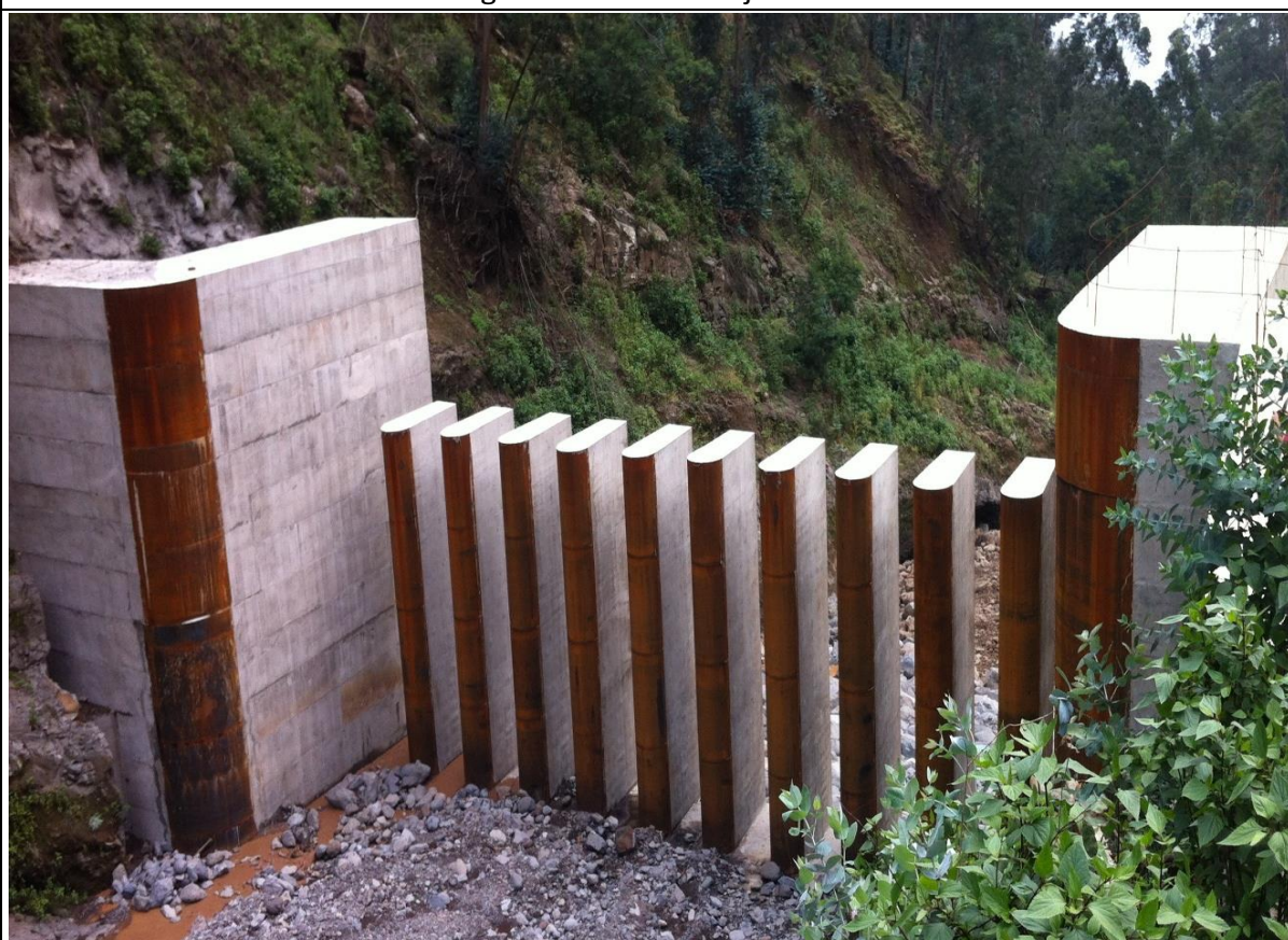
Figura A8.6: Vista de montante
