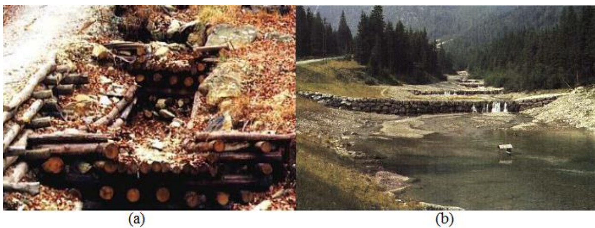
Figura 5.5: (a) - Barragem de pedra e madeira. (b) - Barragem parede
