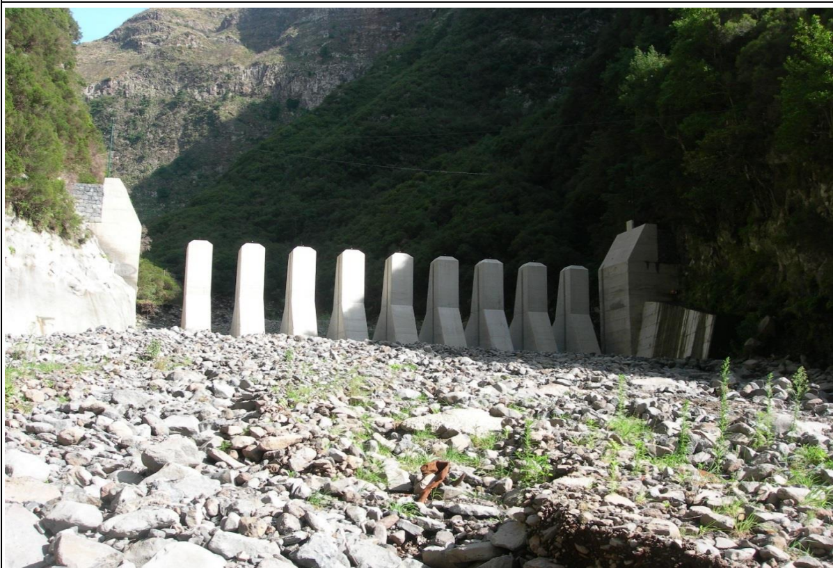
Figura A3.4: Vista de jusante
