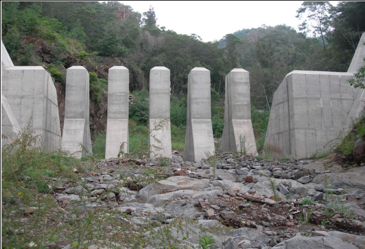
Figura A2.7: Enrocamento a jusante
