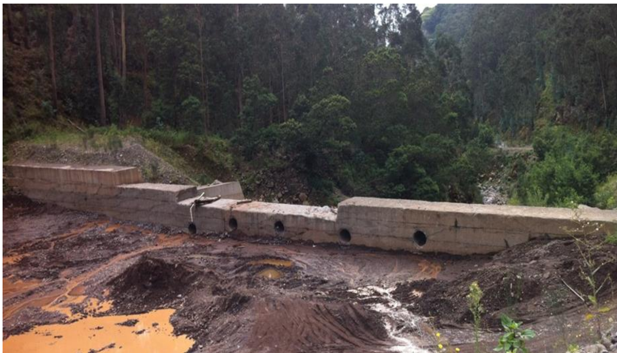
Figura 1.2: Açude fechado, vista de montante
