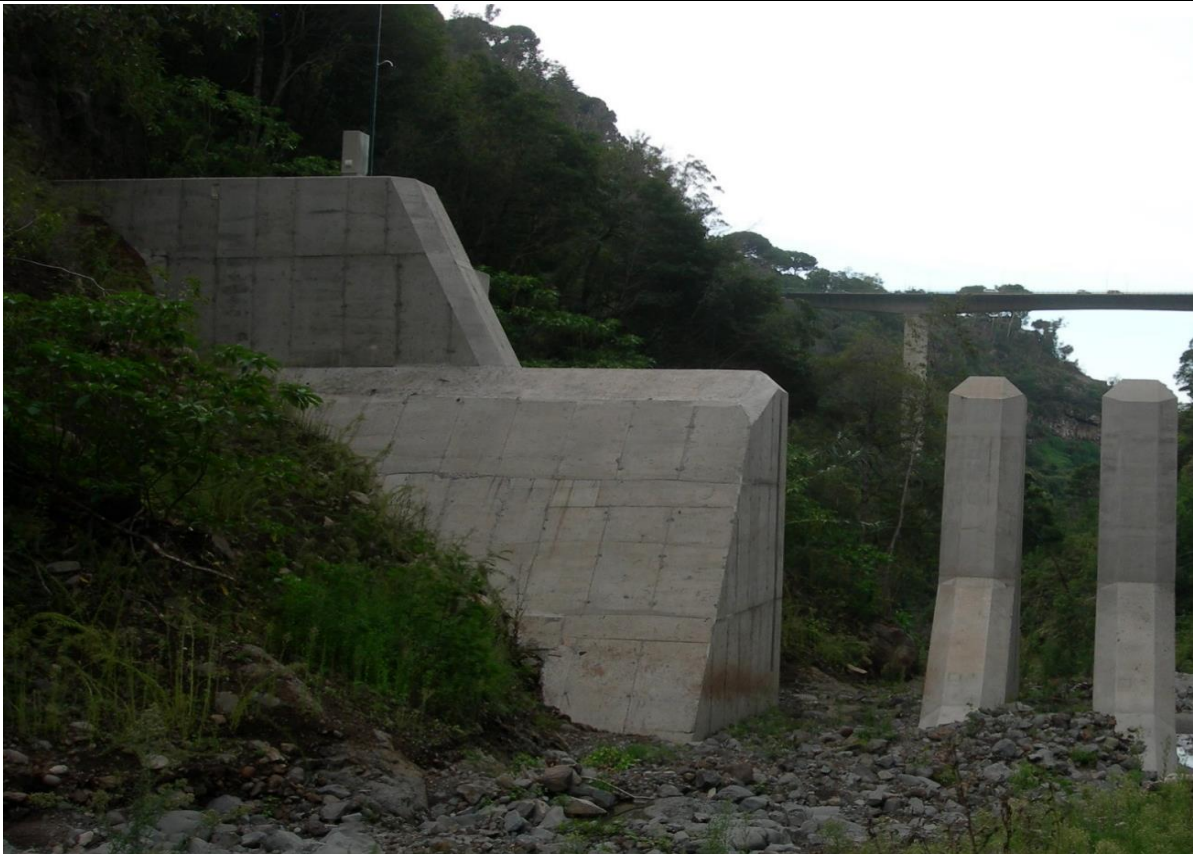
Figura A2.6: Encontro direito, com abertura de 3,5 metros
