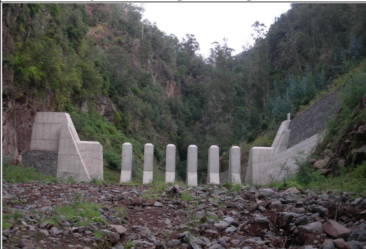
Figura A4.4: Vista de jusante
