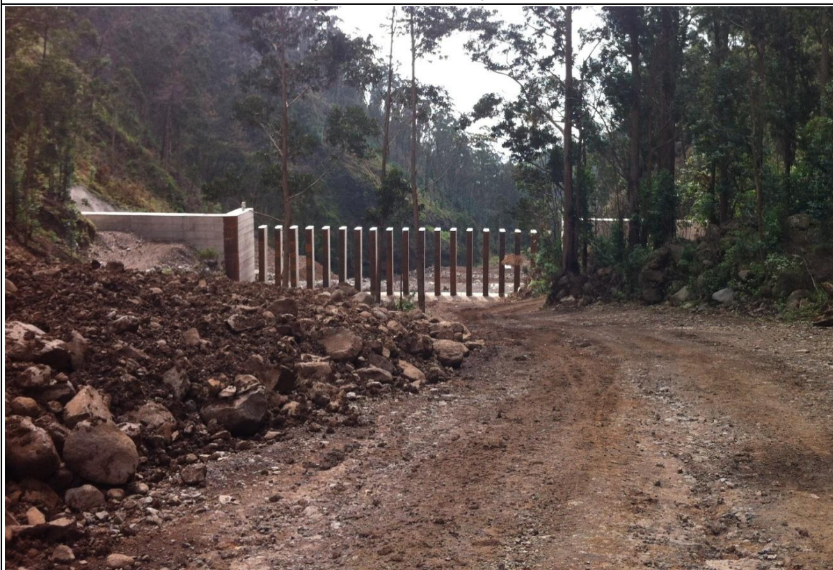
Figura A7.6: Vista de montante
