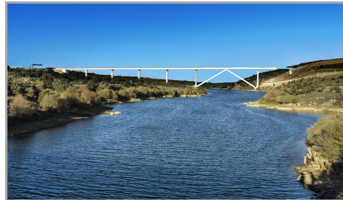
Viaducto de FFCC de alta velocidad sobre el río TERA. Zamora (150 m sobre embalse). Fuente: CFCSL
