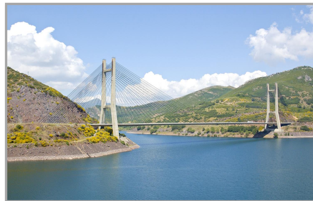
Puente Ingeniero Carlos Fernández Casado sobre el Embalse de Barrios de Luna (440 m). Fuente: CFCSL
