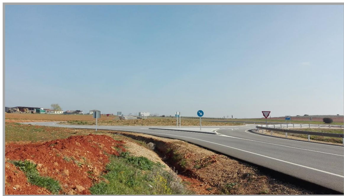
Fotografía 10: Glorieta situada en la N-630 que da acceso a la A-66 desde Fontanillas de Castro y sirve para dar comienzo al trazado de la Alternativa-3.
