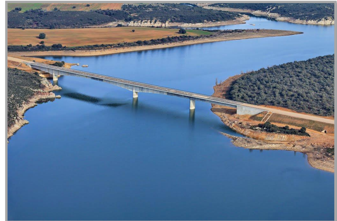
Puente LAV Madrid-Galicia sobre el Embalse de Ricobayo (368 m). Fuente: Panoramio
