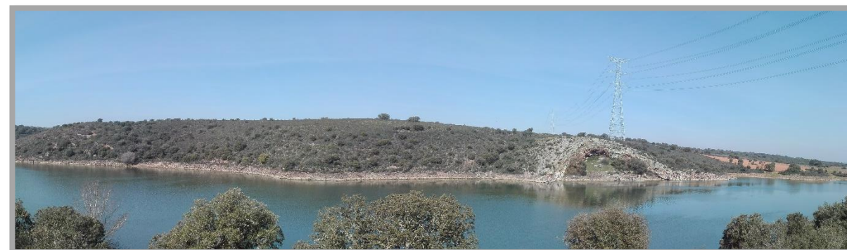
Fotografía 11: Zona donde se sitúa el comienzo del viaducto de la Alternativa-3.
