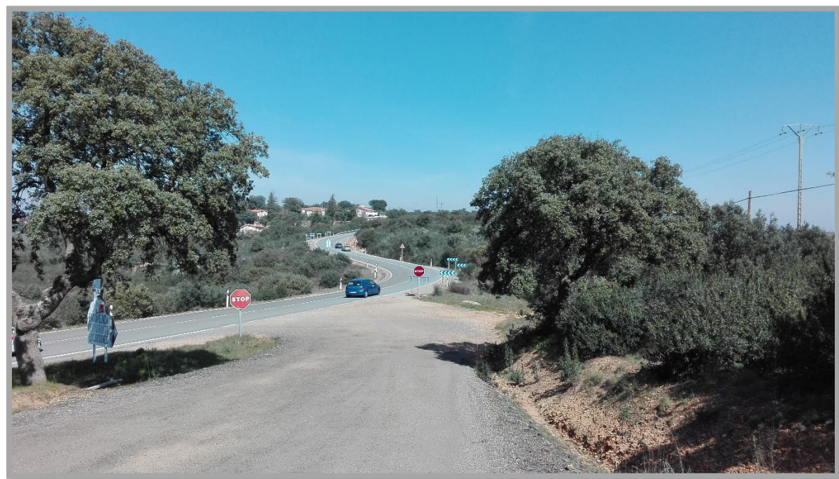
Fotografía 6: Zona por donde la Alternativa -2 se superpone al actual trazado de la N-631. Urbanización de la Encomienda.
