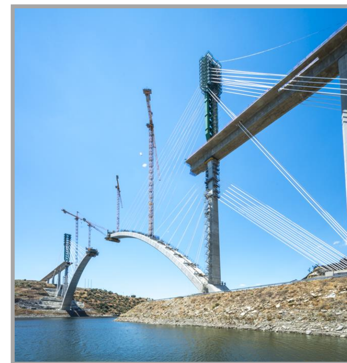
Puente sobre el río Tajo en el Embalse de Alcántara. Cáceres (324 m luz principal). Fuente: CFCSL
