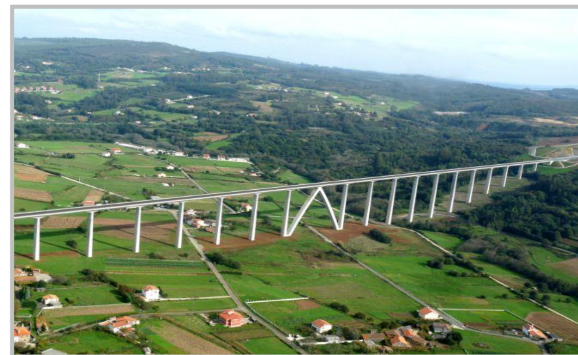
Viaducto de O Eixo (CORREDOR NORTE-NOROESTE DE ALTA VELOCIDAD) (88 m luz de arco). Fuente: Pondio Ingenieros
