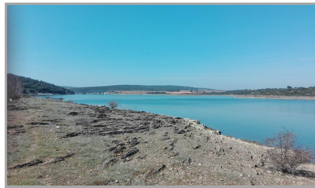
Fotografía 3: Situación general del viaducto de la Alternativa-1 con el viaducto de la LAV al fondo
