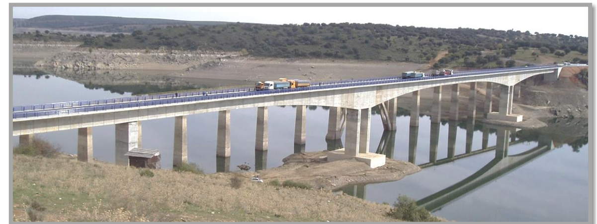
Puente Manzanal del Barco sobre el Embalse de Ricobayo (479.25 m). Fuente: FHECOR
