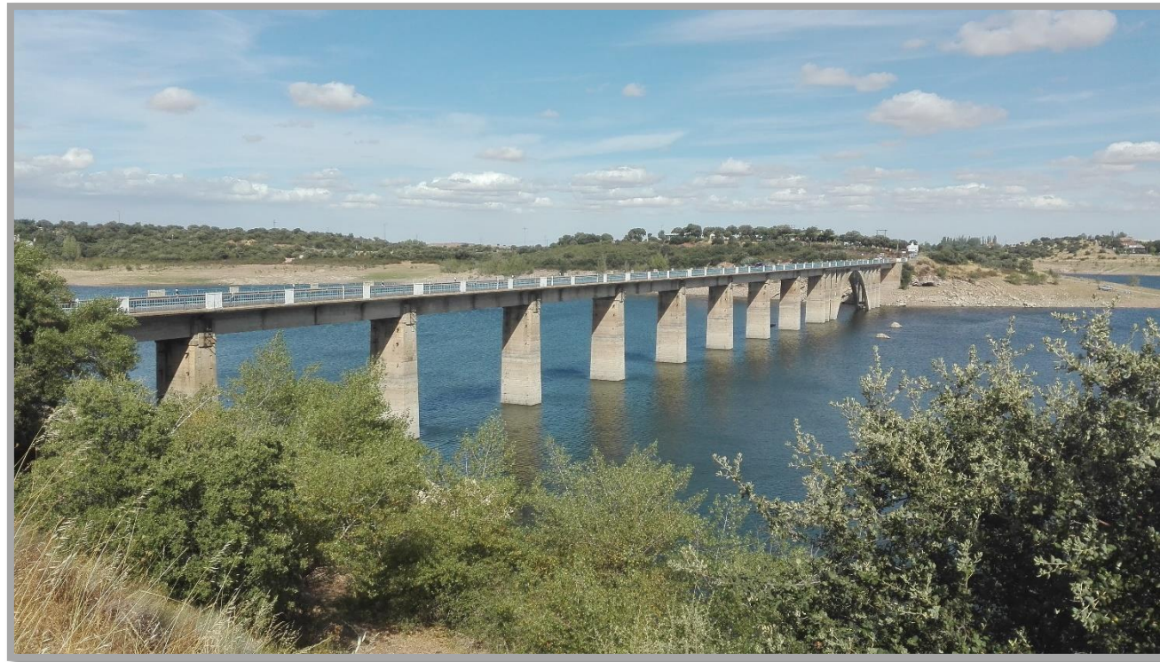
Fotografía 17: Actual Puente de La Estrella datado en los años 30, época de construcción de la Presa de Ricobayo.
