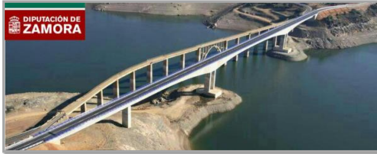
Figura 5. Puentes de Manzanal del Barco. Fuente: Diputación de Zamora
