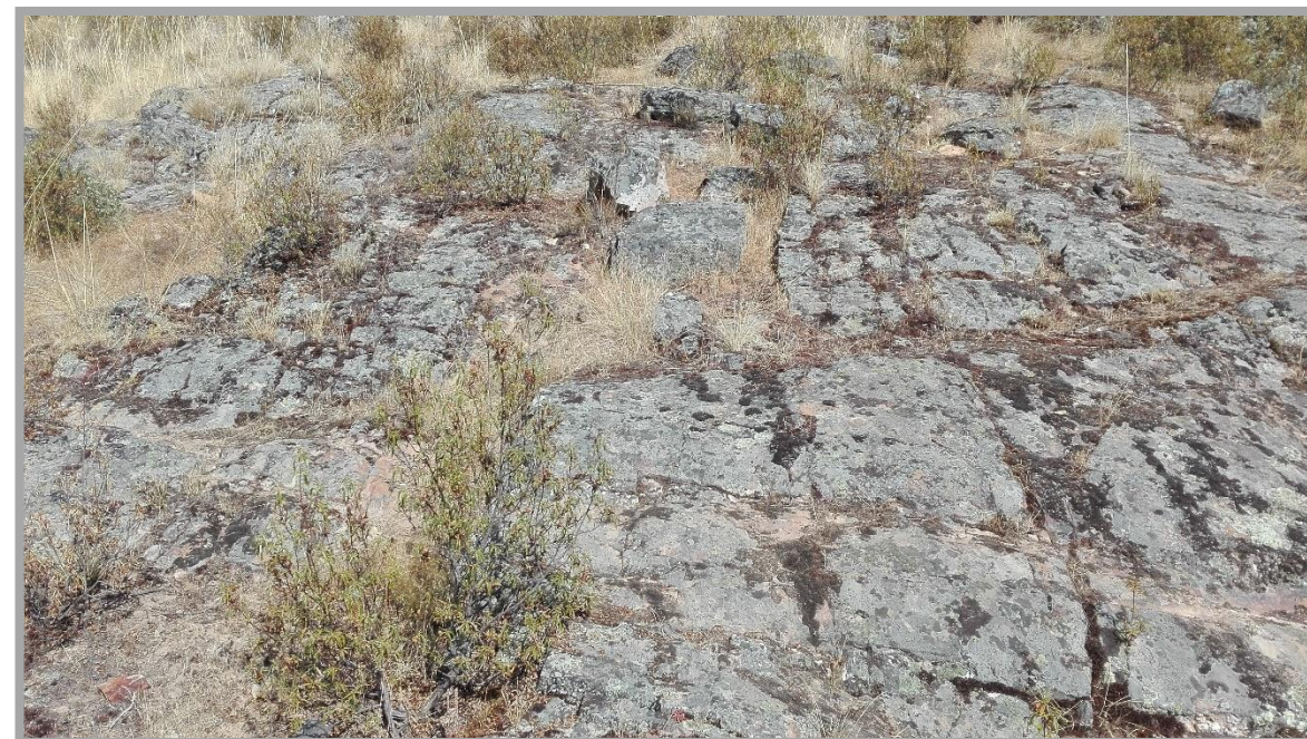
Ilustración 4: Sustrato rocoso en la zona donde se ubica el puente
