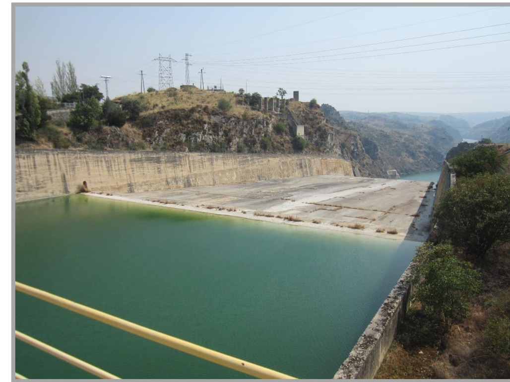
Ilustración 7: Detalle Aliviadero. Fuente: Autor Proyecto
