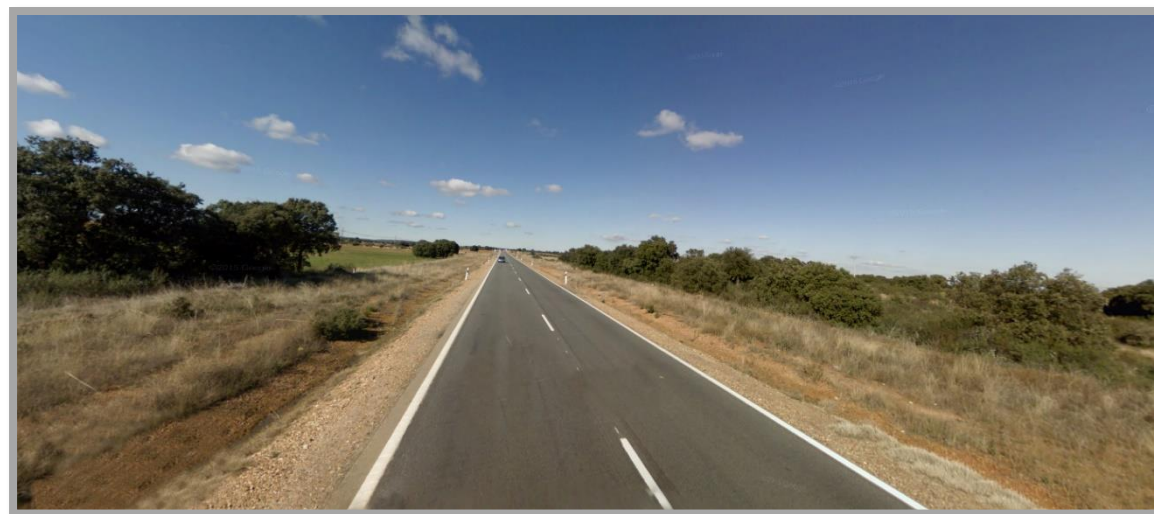
Fotografía 2: PK 5+800 de la N-631, lugar donde el trazado de la Alternativa-1 se uniría al actual
