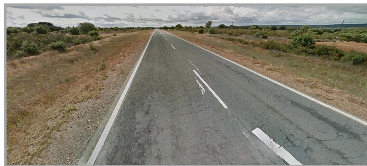
Fotografía 12: Zona donde finaliza el trazado de la Alternativa-3. PK 6+500 de la N-631
