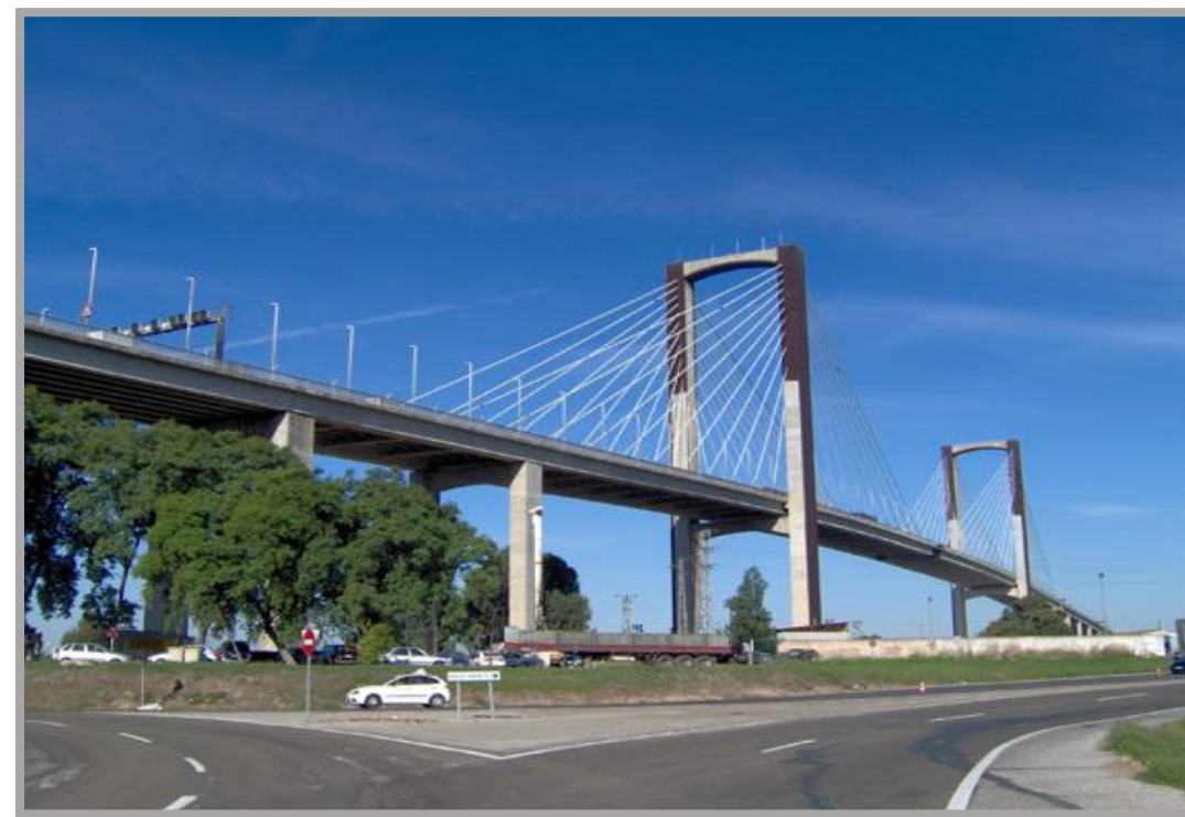
Puente del V Centenario en Sevilla (265 m vano principal). Fuente: www.sevillaguia.com
