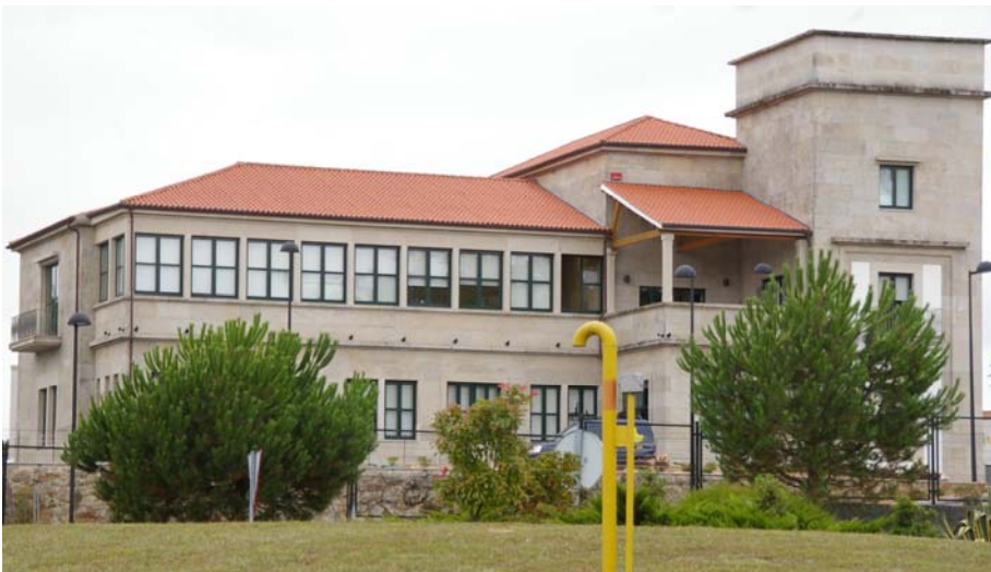
Img3.3/481 [4 PON Paloma 3] Subestación transformadora de energía eléctrica. Pontevedra 1948 12. QUIROGA LOSADA, Emilio. Vista general.
