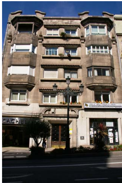
Img3.4/129 [4 VIG Pablo Morillo 7] Edificio Martínez Blasco. Vigo. 1946 09. SALGADO URTIAGA, Emilio. Vista general.
