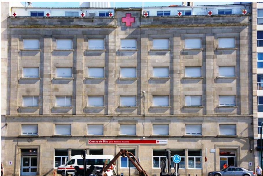
Img3.3/318 [4 VIG Cánovas del Castillo 14-16] Dispensario y puesto de socorro de Cruz Roja. Vigo. 1943 06. CÁRDENAS PASTOR, Manuel de. Vista general.
