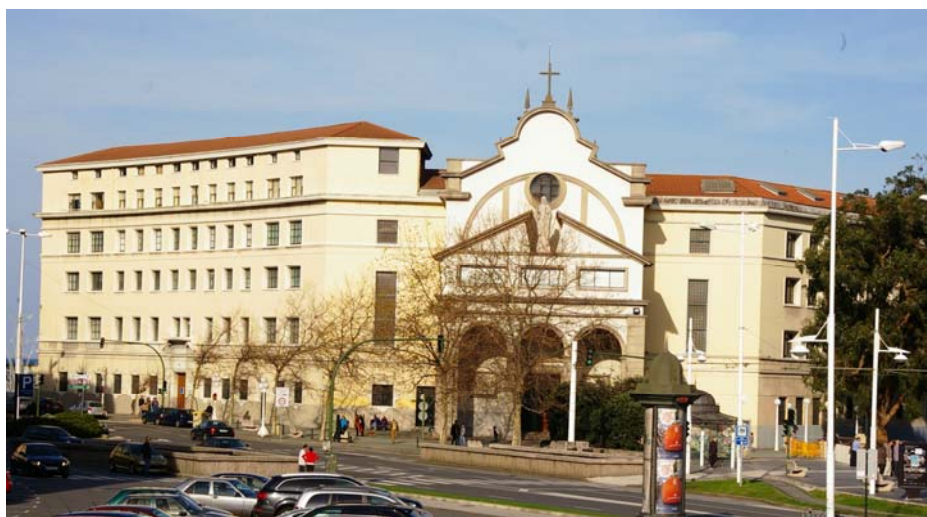
Img3.3/132 [1 COR Ronda 57] Iglesia, Convento, Casa de Ejercicios y Colegio de las Religiosas Esclavas. A Coruña. 1947 04. REY PEDREIRA, Santiago. Vista general.
