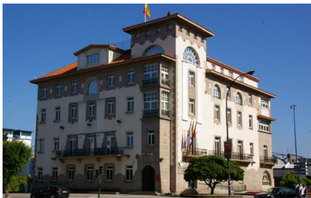
Img3.3/38 Jefatura de Obras Públicas. (Delegación del Gobierno en Galicia) A Coruña. Vista general.
