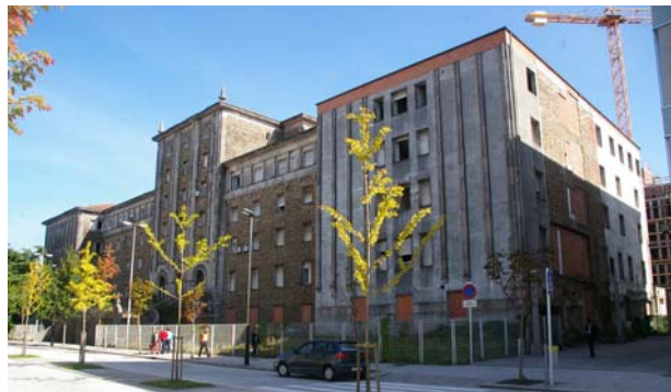
Img3.3/305 Residencia Sanitaria. Santiago. 1949 06. MARCIDE ODRIOZOLA, Martín José. Vista general.
