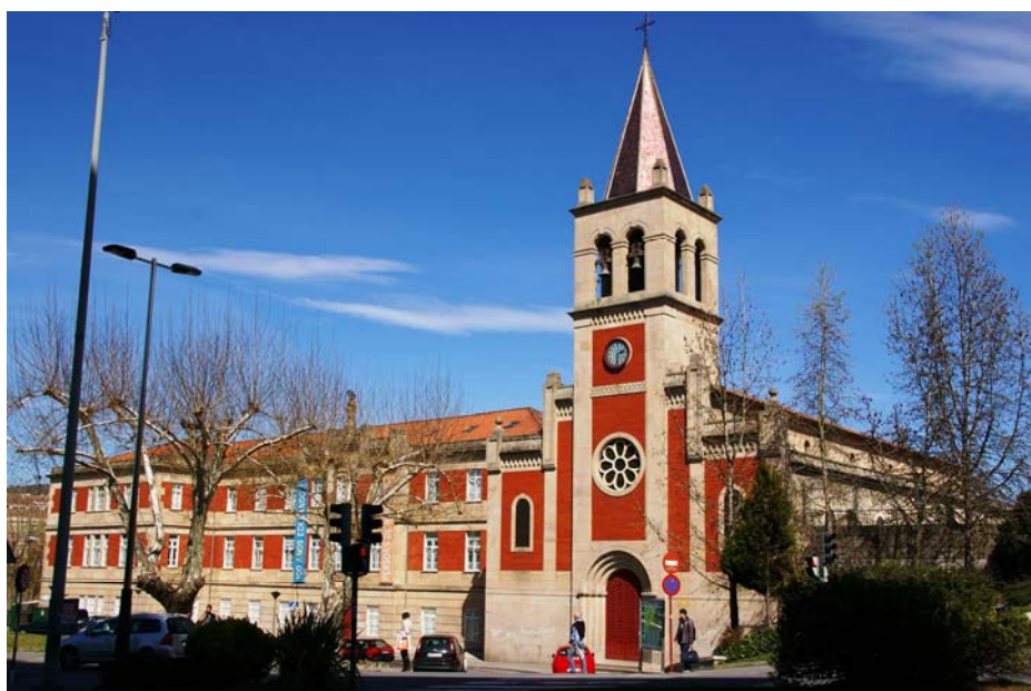
Img3.3/131 [3 ORE Don Bosco 1] Colegio de los PP. Salesianos. Orense. 1944 05. SÁNCHEZ NÚÑEZ, Ruperto. Vista general.
