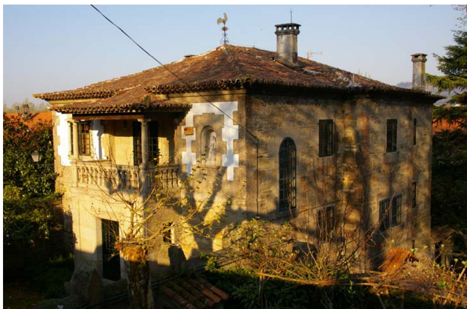
Img3.4/226 [1 SAN Juan XXIII 5] Casa Lois Asorey. Santiago. 1946 08. GÓMEZ ROMÁN, Manuel. Vista general.
