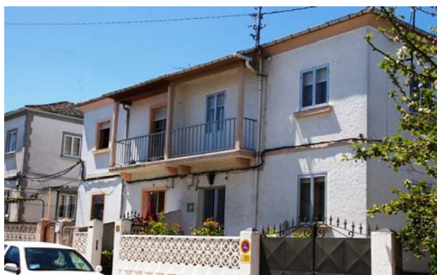
Img3.4/15 [2 LUG Islas] Grupo "Hermanos Pedrosa" de 88 viviendas protegidas para obreros. Lugo. 1946 04 – 1949 11. RODRÍGUEZ SANZ, Mariano SÁNCHEZ NÚÑEZ, Ruperto. Viviendas pareadas: vista parcial.
