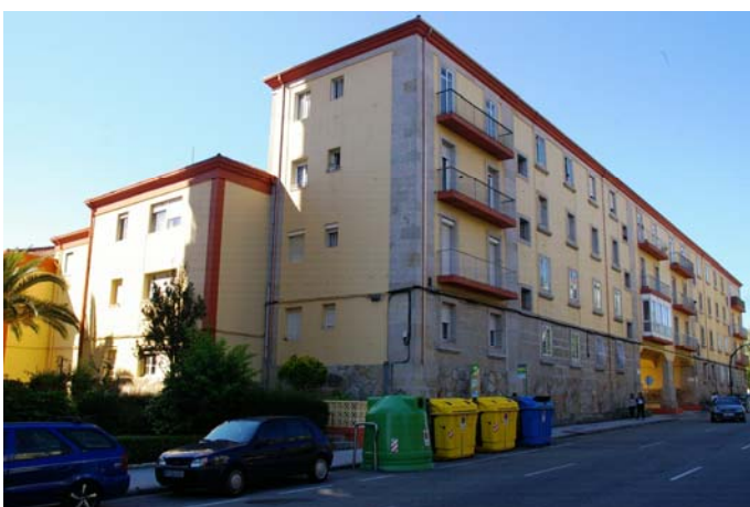
Img3.4/13 [4 VIG Castelaio 87] Grupo de 126 viviendas protegidas en Coia. Vigo. 1948 05. ÁLVAREZ-SALA Y MORIS, Enrique. Vista general.
