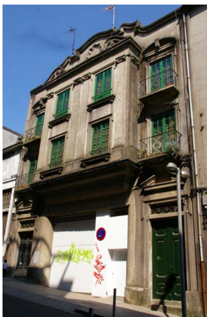
Img3.4/107 [2 LUG Pastor Díaz 16] Edificio Abuiñ Fernández. Lugo. 1946 06. VILA LÓPEZ, Alfredo. Vista general.
