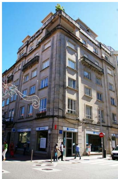
Img3.4/152 [1 SAN Coruña 1 cv Rosalía Castro] Edificio Gigirey Rodríguez. Santiago. 1943 06. BANET DÍAZ-VARELA, José María. Vista general.
