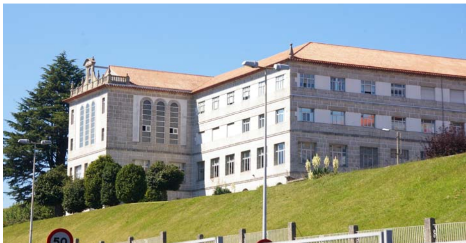
Img3.3/381 [4 VIG Filipinas 6] Colegio Asilo de niños. Vigo. 1943 12. COMINGES TAPIAS, Antonio de. Vista general de la fachada posterior.
