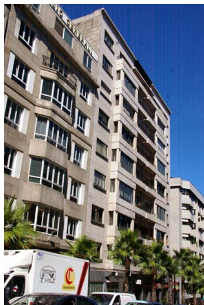
Img3.4/133 [4 VIG García Barbón 30] Edificio Curbera. Vigo. 1939 04 - 1941 01. CASTRO REPESAS, Francisco. Vista general.
