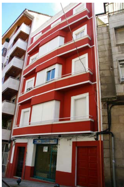
Img3.4/113 [3 ORE Progreso 103] Edificio Bouzo. Ourense. 1939 08. MAQUIEIRA FERNÁNDEZ, Eloy. Vista general.
