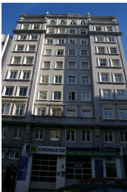
Img3.4/121 [1 COR Pardo Bazán 22-24] Edificios Suárez Díaz - Vega Carballido. A Coruña. 1949 03. TENREIRO RODRÍGUEZ, Antonio. Vista general.
