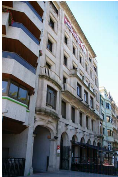
Img3.4/131 [4 VIG Compostela 21] Edificio Davila Ramón. Vigo. 1942 09. GÓMEZ ROMÁN, Manuel. Vista general.
