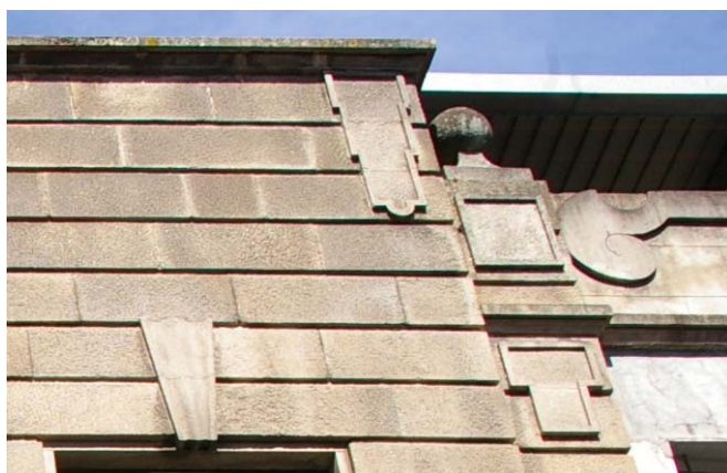
Img3.3/477 Estación de servicio. Vigo. 1951 10. MOLÍNS SOTO, Fernando. Fachada: detalle.
