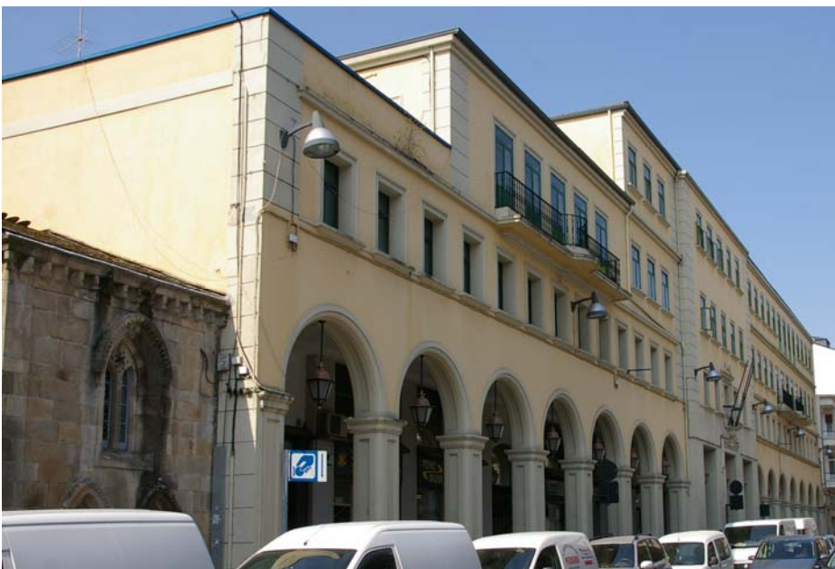
Img3.3/175 [2 LUG Quiroga Ballesteros] Edificio para Mercado y auxiliar de beneficencia. SÁNCHEZ NÚÑEZ, Ruperto. Lugo. 1948 05. Vista general.
