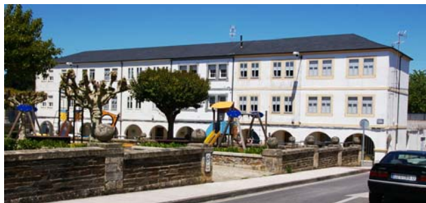
Img3.4/14 [2 LUG Islas] Grupo "Hermanos Pedrosa" de 88 viviendas protegidas para obreros. Lugo. 1946 04 – 1949 11. RODRÍGUEZ SANZ, Mariano SÁNCHEZ NÚÑEZ, Ruperto. Bloque: vista general
