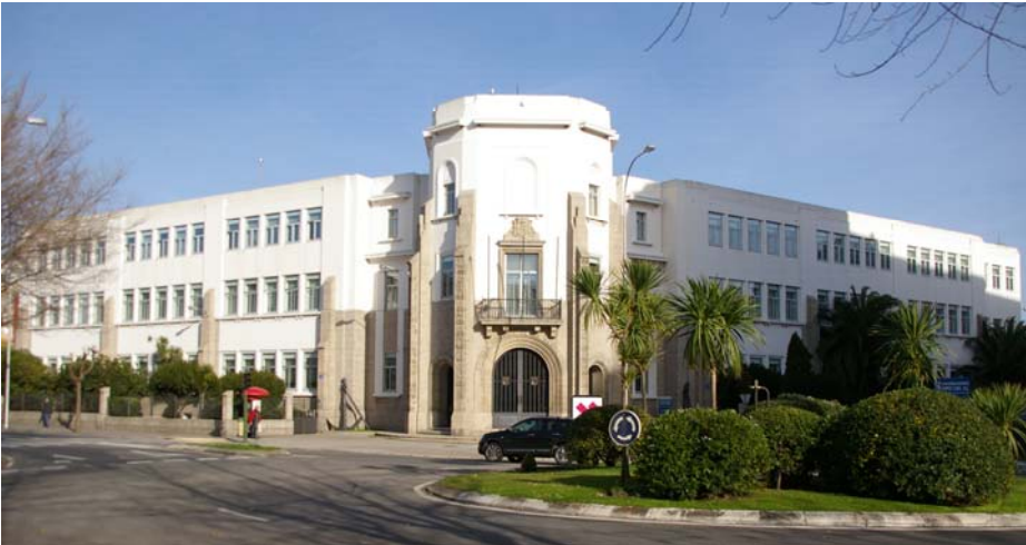
Img3.3/269 [1 COR Marina Mercante 1] Escuela de Náutica. A Coruña. 1948 11. TENREIRO RODRÍGUEZ, Antonio. Vista general.
