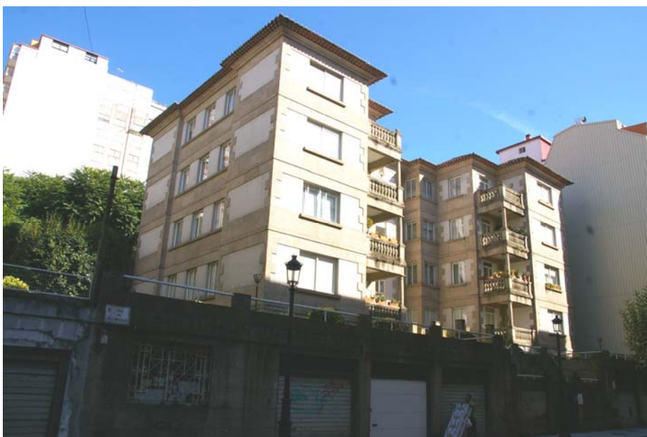
Img3.4/213 [4 VIG Pí y Margall 135] Edificio Iglesias Fernández. Vigo. 1941 02 – 1943 07. CASTRO REPRESAS, Francisco. Vista general.
