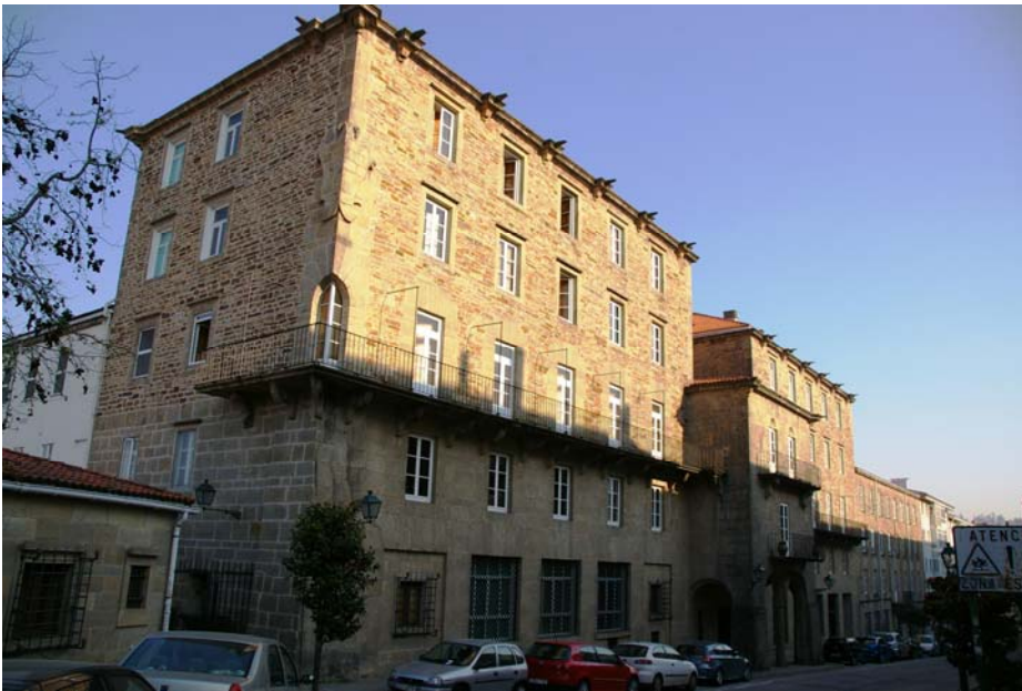
Img3.3/152 Colegio Mayor La Estila. Santiago. Ca. 1946. FISAC SERNA, Miguel. Vista general.
