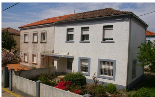
Img3.4/16 Grupo "José Antonio Primo de Rivera". Santiago. 1943 07. GONZÁLEZ CEBRIÁN, Juan. Viviendas pareadas: vista parcial.
