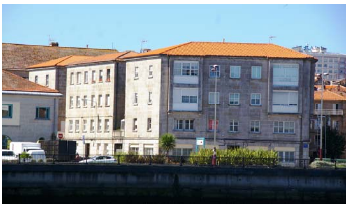
Img3.4/12 [4 PON Buenos Aires - Julio Camba - Sierra - Escudero] Grupo de 84 viviendas protegidas para funcionarios y obreros. Pontevedra. 1949 11. GARCÍA PABLOS, Rodolfo. QUIROGA LOSADA, Emilio. Vista general.
