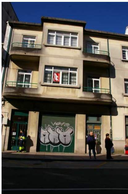
Img3.4/109 [4 VIG Marqués Valladares 25] Edificio López Souto. Valladares 25] Vigo. 1951 12. COMINGES TAPIAS, Antonio de. Vista general.
