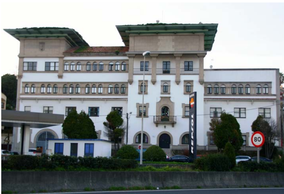
Img3.3/222 [1 COR Pasaje 30] Edificio para la Junta de Protección de Menores. (Internado San José de Calasanz). A Coruña. 1951 10. REBOREDO LOPEZ, Manuel Andrés. Vista general.
