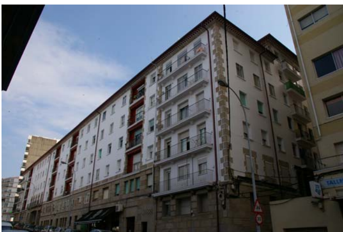
Img3.4/11 Bloque de viviendas para pescadores. Vigo. 1948 07. ECHENIQUE GÓMEZ, Francisco. Vista general desde el sur.
