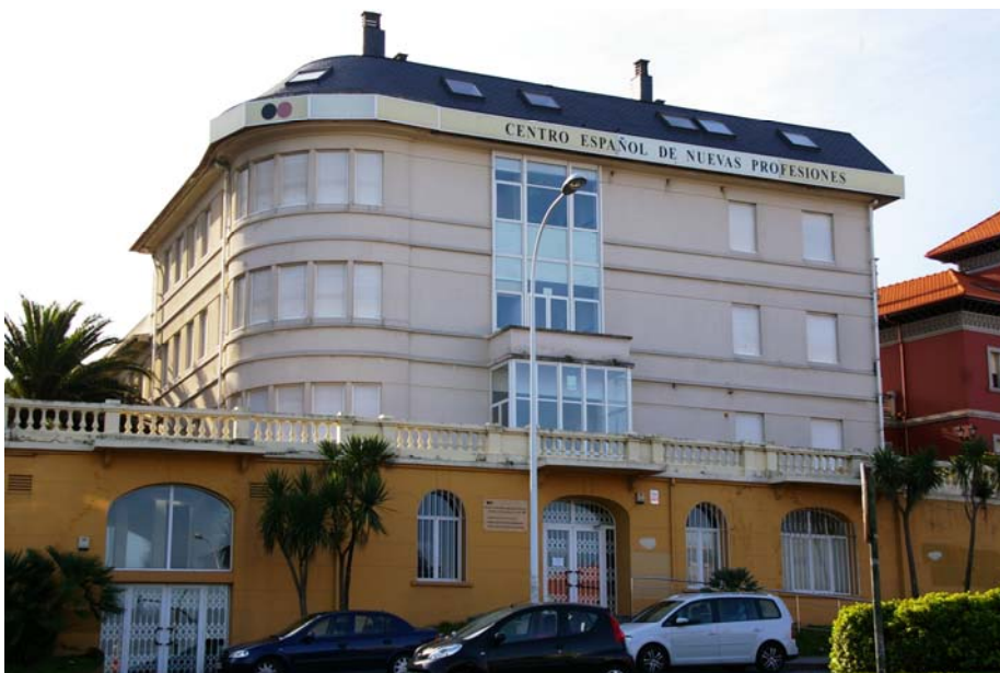
Img3.3/500 Sanatorio Larrea. A Coruña. 1945 03. VICÉNS MOLTÓ, Antonio. Vista general.
