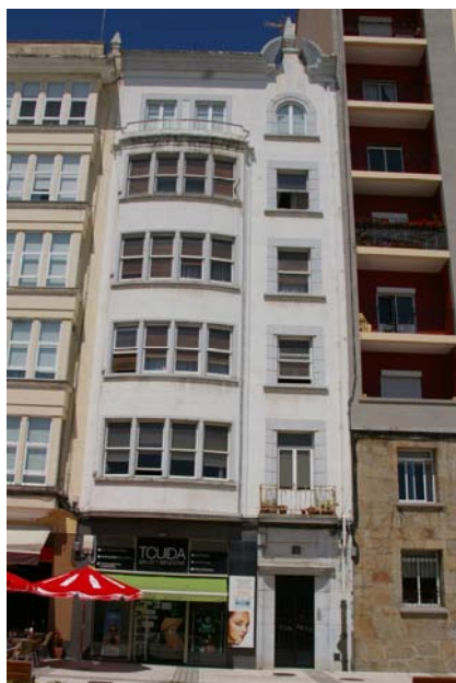
Img3.4/89 [3 ORE Curros Enríquez 24] Edificio López Fernández. Orense. 1950 02. BARREIRO VÁZQUEZ, José. Vista general.
