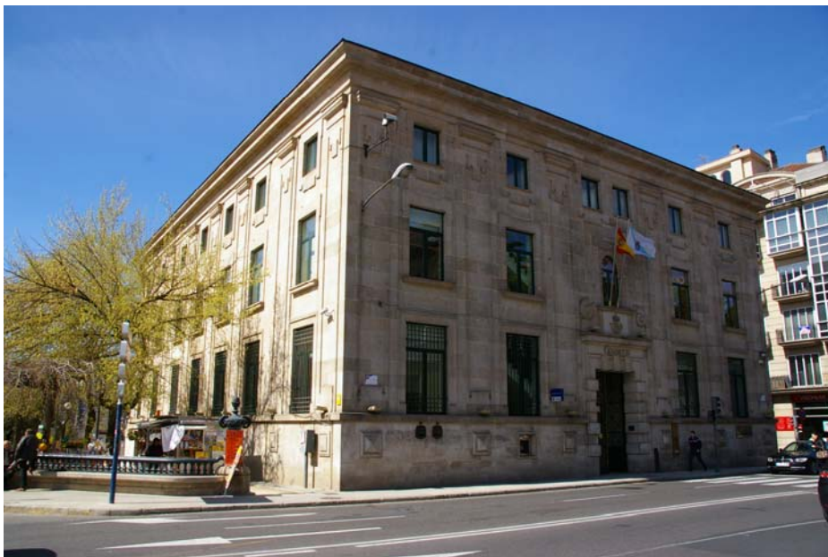
Img3.3/56 [3 ORE Progreso 53] Correos y Telégrafos. Orense. 1948. OTAMENDI MACHIMBARRENA, Joaquín. LOZANO LOSILLA, Luis. Vista general.
