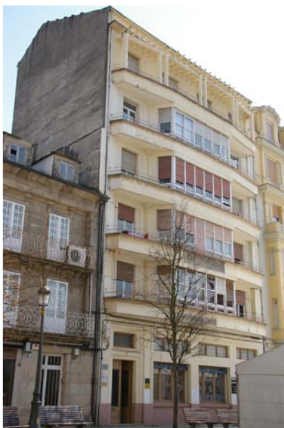
Img3.4/115 [2 LUG Santo Domingo 2] Edificio Macía. Lugo. 1945 09. SUREDA COSTAS, Manuel. Vista general.
