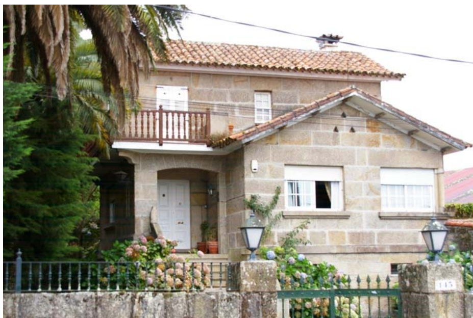
Img3.4/225 [4 PON Ruibal 145] Casa Santos García. Pontevedra. 1951 05. QUIROGA LOSADA, Emilio. Vista general.
