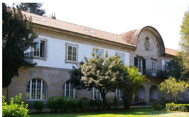
Img3.4/39 [1 SAN Ciencias 3] Viviendas para catedráticos. Santiago. 1943 05 – 1949 02. FUENTE ÁLVAREZ, Jenaro de la. Vista general.
