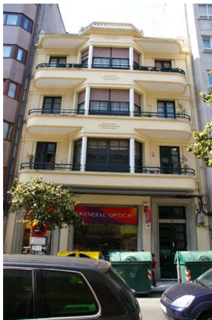
Img3.4/111 [3 ORE Celso Emilio Ferreiro 14] Edificio Orbán. Ourense. 1946 09. CONDE FIDALGO, Manuel. Vista general.
