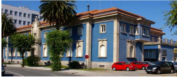
Img3.3/34 Aduana Nacional. A Coruña. Vista general.
