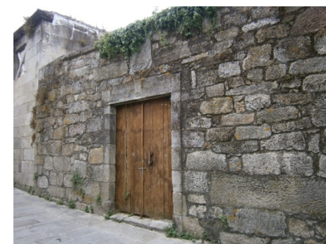
Imagen del interior de la parcela de la casa y muro exterior.
