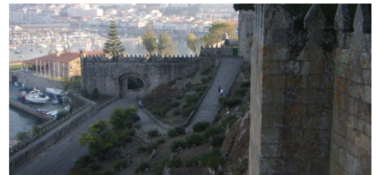
Imagen de 2011, donde se muestra una perspectiva similar a la mostrada de 1960, observándose la existencia en la actualidad de un acceso bajo un arco y de una altura mucho mayor a la original.
