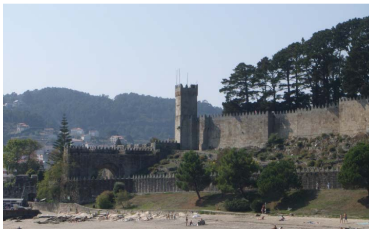
Imagen de la Torre del Reloj donde se observa su situación con respecto al resto de la fortificación.
