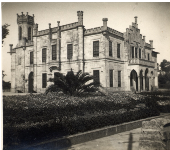
Imágenes de la fachada principal del palacete. Fuente: Archivo fotográfico de la familia Bedriñana.
