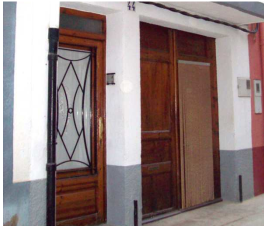
Imagen 2.24. Carpintería Fachada principal
