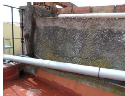
Enfoscado de mortero
