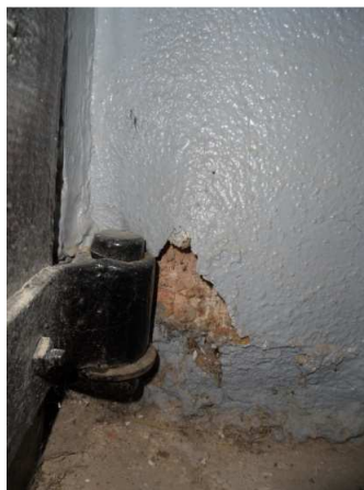
Imagen 3.5 Desprendimiento revestimiento
