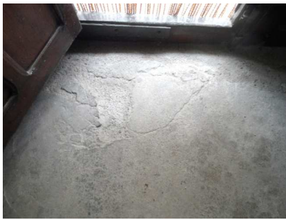
Capa de mortero de cemento sobre solera de hormigón
