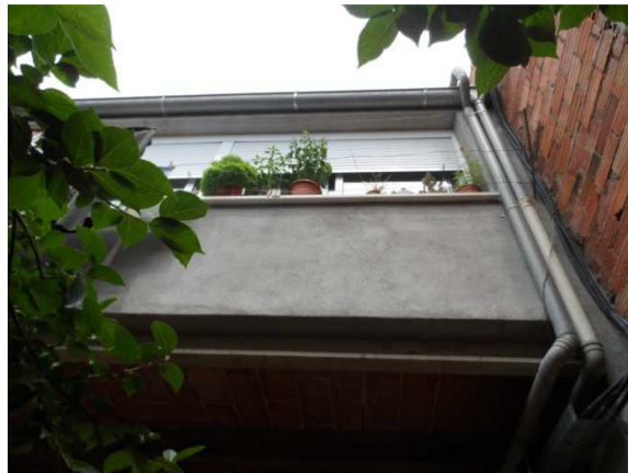
Imagen 2.15. Revestimiento Fachada posterior
