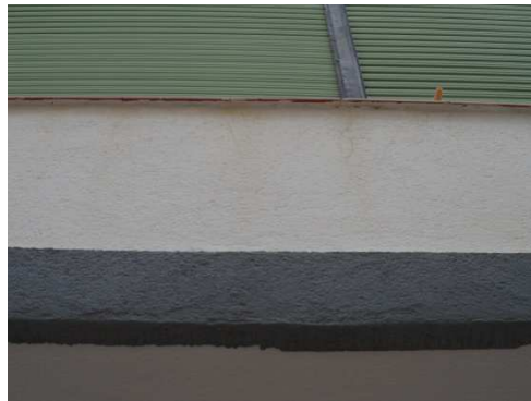
Imagen 3.20 Fisuración revestimiento
