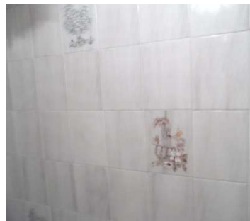
Alicatado de baldosa cerámica
