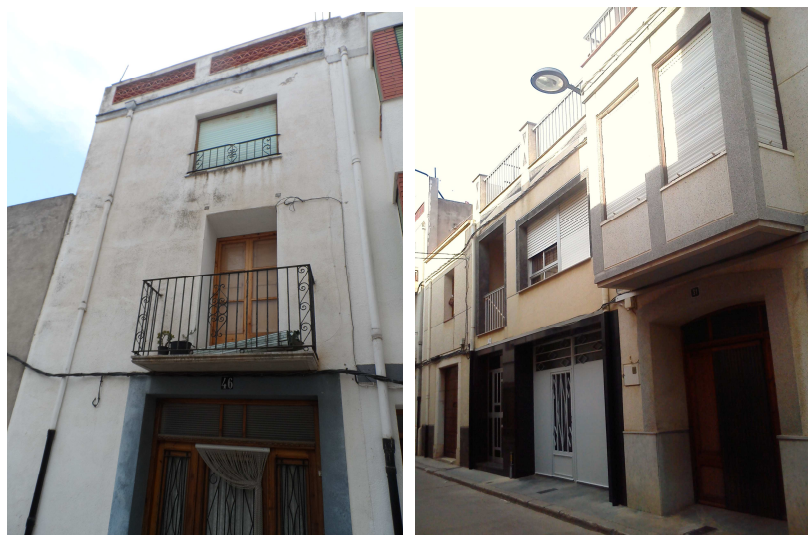
Imágenes 1.10. Viviendas rehabilitadas
