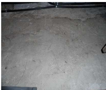
Enfoscado de mortero
