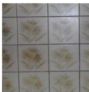
Alicatado de azulejos cerámicos
