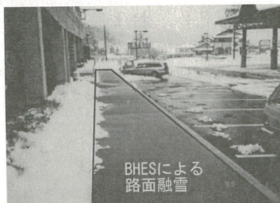
写真-3 冬期における BHES による歩道融雪 (道の駅「八千北」: 1999年1月8日)
