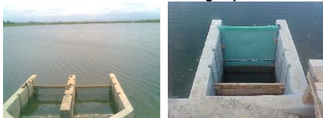
Figura 27. Canales de aducción de agua para los estanques
