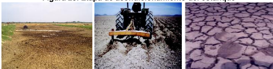
Figura 25. Etapa de acondicionamiento del estanque
