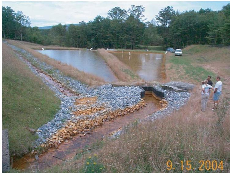
Fotografía 1.9. SAPS piloto en Bell Colliery, Pennsylvania (USGS)
