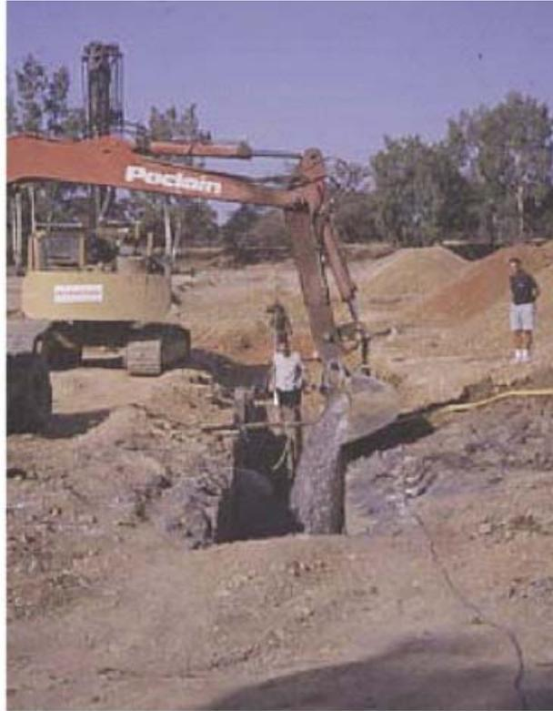
Fotografía 1.10. Relleno de zanja con material reactivo durante la construcción de la barrera en Aznalcóllar (Manzano *et al.*, 2006)
