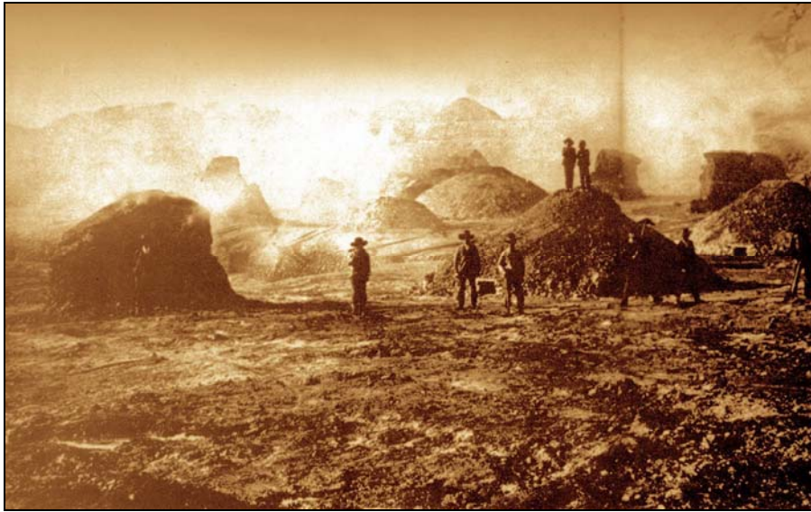
Figura 4.4: Teleras para la tostación de pirita a cielo abierto en la segunda mitad del siglo XIX (Salkield, 1987).
