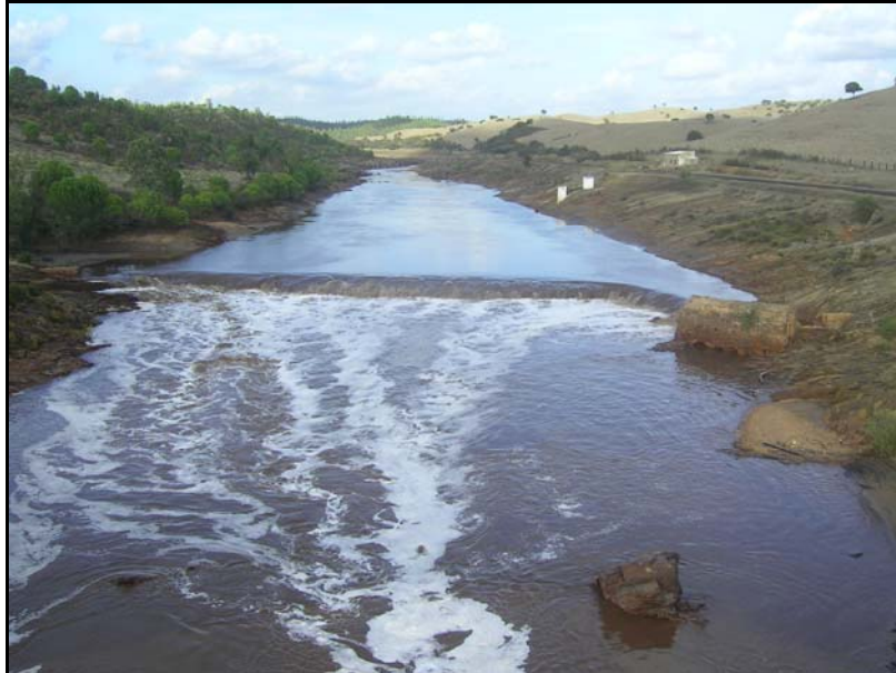
Figura 6.4: Estación de aforos de Gadea en el río Tinto. Se observa en el fondo a la derecha una construcción próxima al río que corresponde a la situación de la caseta del limnógrafo.
