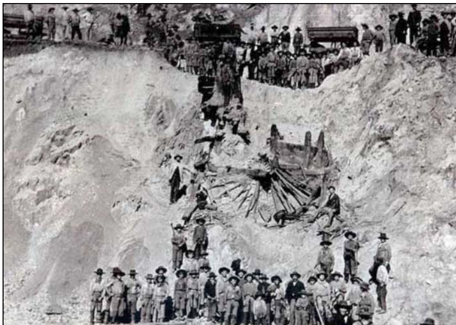
Figura 4.3: Noria de época romana para la extracción de agua en las labores mineras de interior hallada en las minas de Riotinto (Fundación Riotinto).
