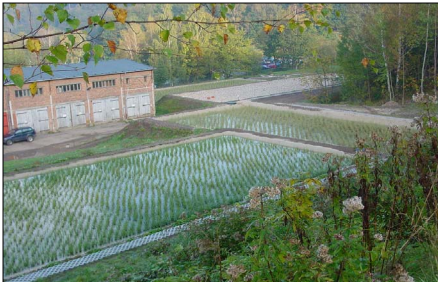
Figura 7.6: Humedal artificial diseñado para el tratamiento de drenaje ácido de mina.
