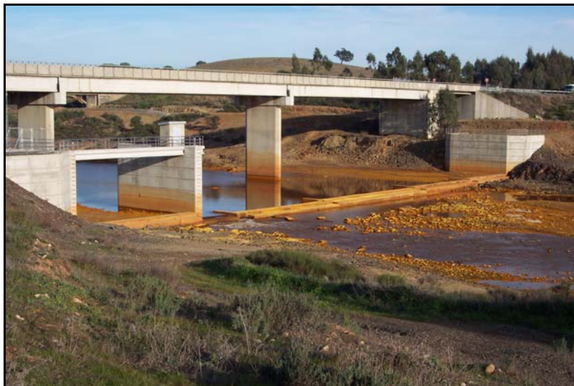
Figura 6.5: Nueva estación de aforos perteneciente a la red SAIH del río Tinto en Puente Gadea.
