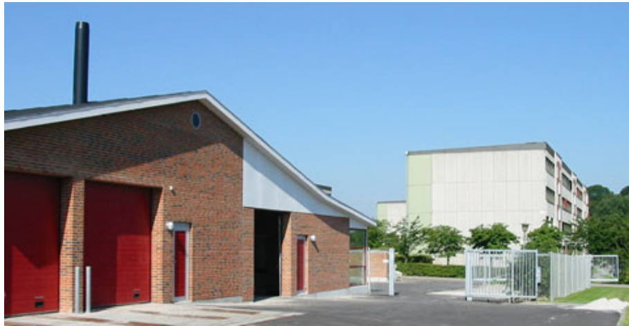
Foto 5. Murerarbejdet på Genbrugspladsen blev udført i samarbejde med Århus kommunes erhvervs- træningsskole, der etablerede et særligt arbejds hold med aktiveringspersoner som arbejdskraft. Foto: Århus Kommune.
