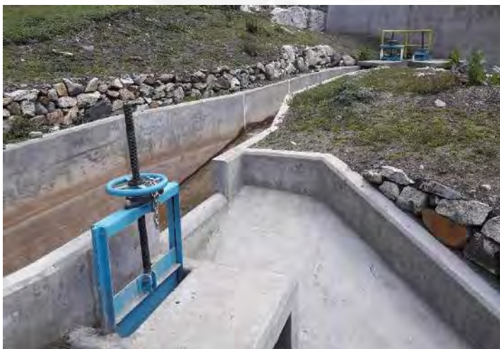
Foto 3: Dentro del sector 1 se construyó el aliviadero en conjunto con el desarenador que está ubicada en el centro poblado de Santa Rosa.
