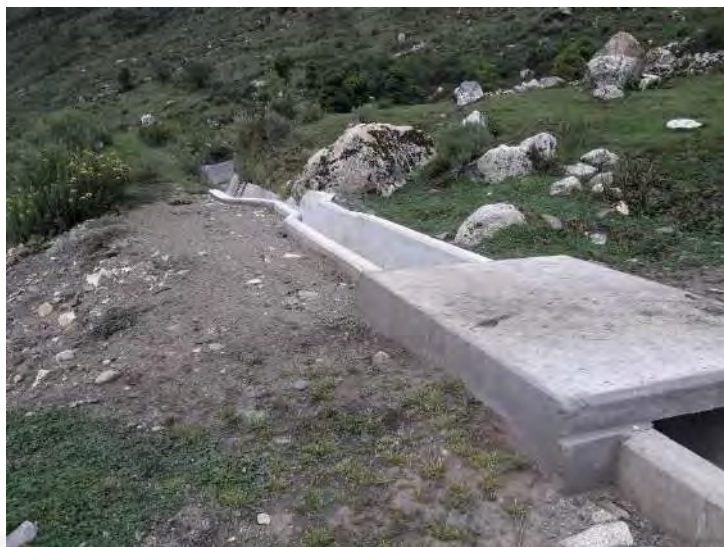
Foto 4: Construcción del canal rectangular de los primeros tramos que está ubicada en el centro poblado de Santa Rosa.
