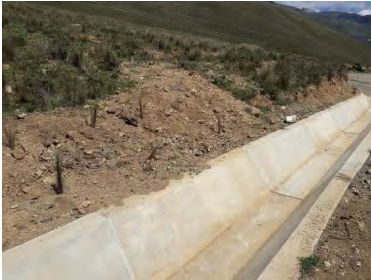
Foto 21: La construcción del canal trapezoidal que está ubicada en el centro poblado de San Miguel. Además, se observa el paisaje vegetativo en toda la zona.
