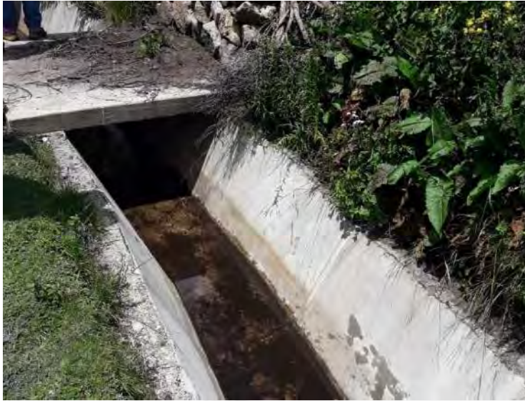
Foto 7: la reconstrucción del canal trapezoidal y pasarela que está ubicada en el centro poblado de Santa Rosa. Además, se sigue observando la parte vegetativa.
