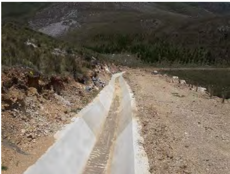
Foto 22: La construcción del canal trapezoidal que está ubicada en el centro poblado de San Miguel. Además, se observa el paisaje vegetativo en toda la zona.
