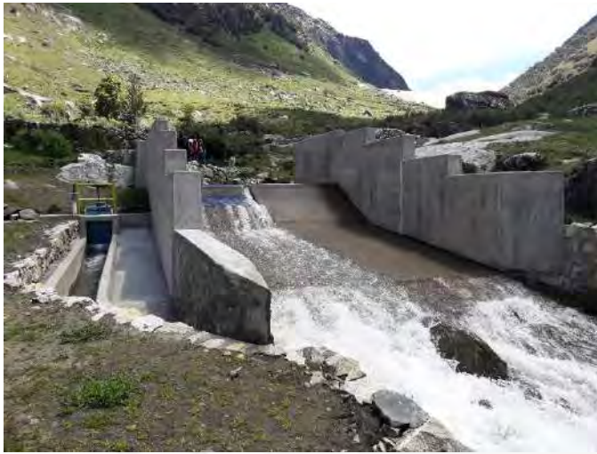
Foto 1: al inicio del sector 1 donde se construyó la bocatoma que está ubicada en el centro poblado de Santa Rosa.
