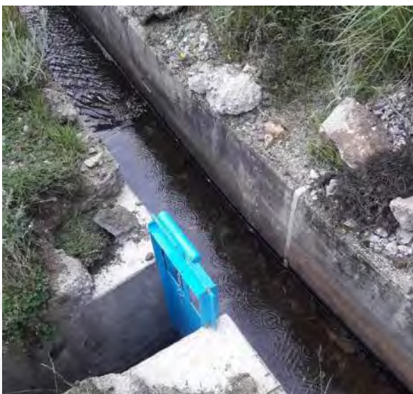
Foto 9: Reparación del canal rectangular y colocación de compuerta que está ubicada en el centro poblado de Santa Rosa
