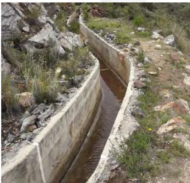
Foto 11: Reparación del canal rectangular que está ubicada en el centro poblado de Santa Rosa. Además, se observa vegetación con suelos rocosos.
