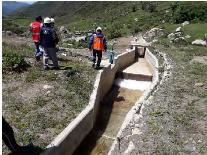
Foto 2: Dentro del sector 1 se construyó el desarenador que está ubicada en el centro poblado de Santa Rosa.
