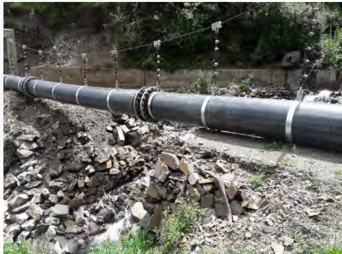
Foto 14: Pase aéreo de 20 metros y colocación de tubería que está ubicada en el centro poblado de Suyan.
