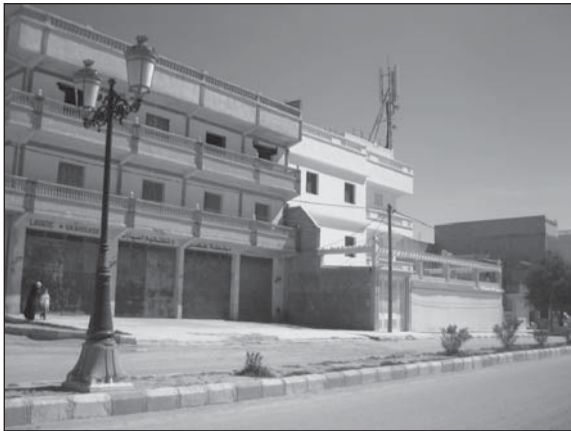
Figure 8a Annexion d'un morceau de trottoir pour l'extension d'une villa à Aïn-Beïda (route de Sédrata)
