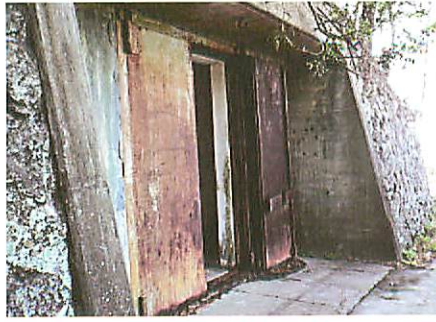
写真17：探照灯倉庫入口の頑丈な扉
