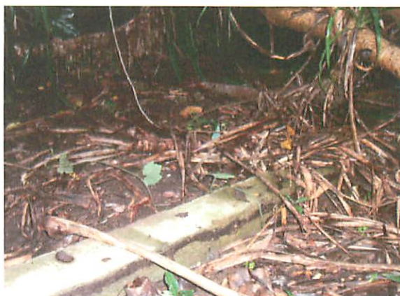
（写真4：一段下のコンクリート基礎）
