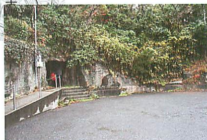
写真11：豊砲台跡の入口付近
