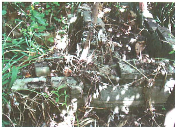
（写真3：山頂付近の基礎部分）
