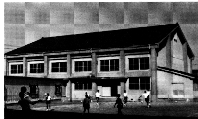
写真4 N中学校体育館 南・東面
