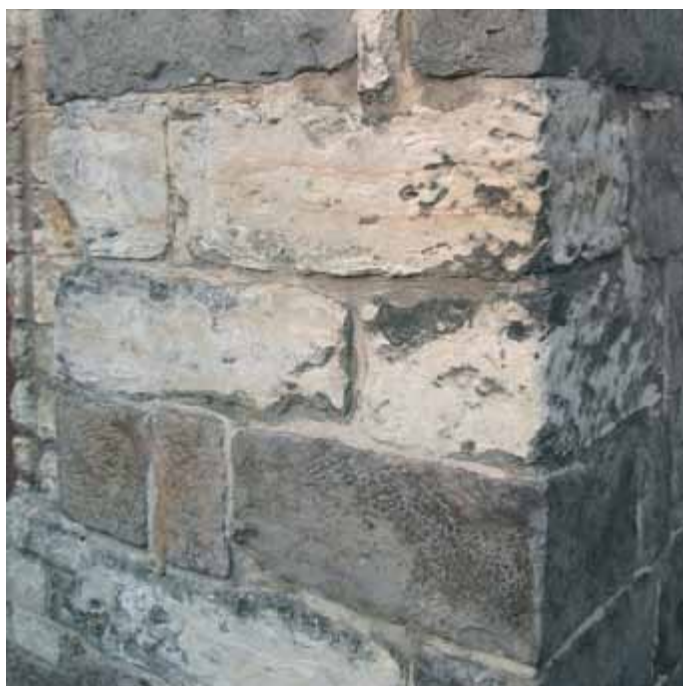
[5.5] Hoekstenen samengesteld uit alternerende blokken gekloven en afgevlakt grijs Tiens kwartsiet en bleke Gobertangesteent. Schip van de begijnhofkerk (Roland Dreesen, 2006).
