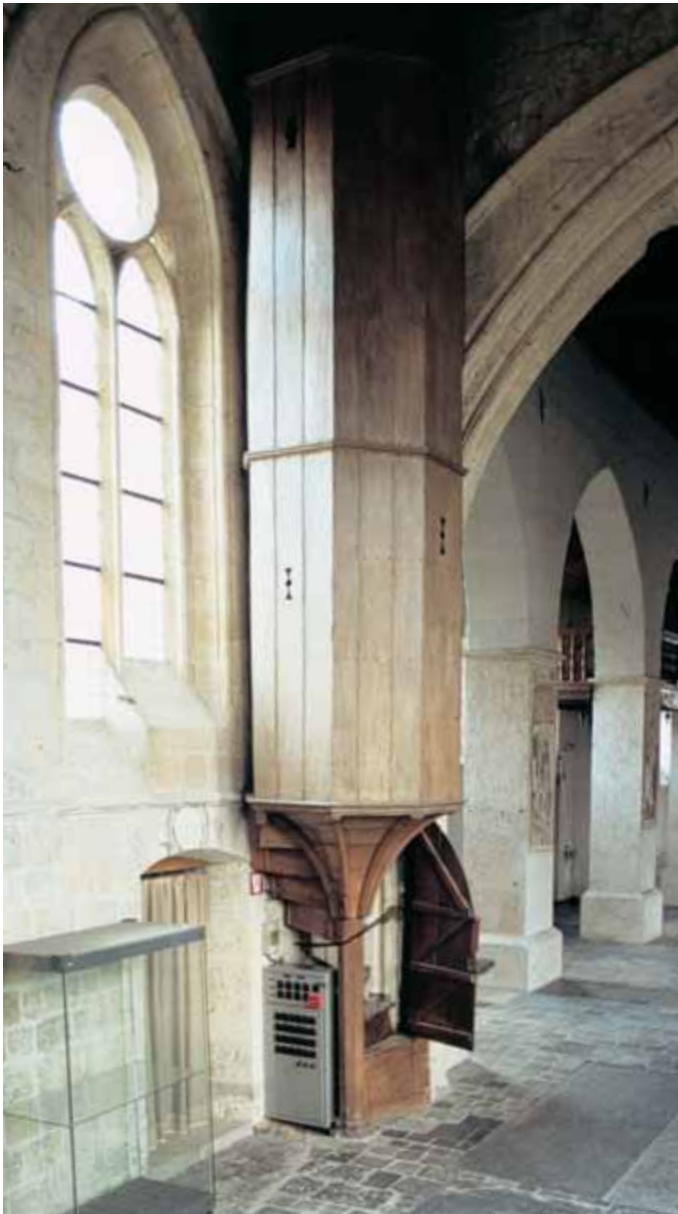
[6.59] Winteltrap met houten omkasting in het koor, begin 16de eeuw (THOC, 2004).
