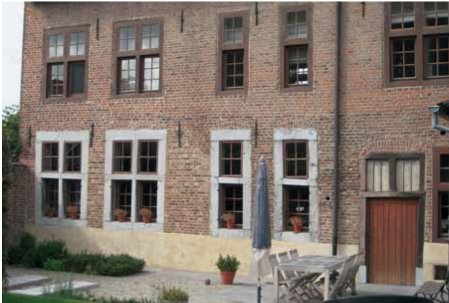
[4.54] Dubbelhuis nr. 61, achtergevel na de restauratie (PCCE, 2007).
