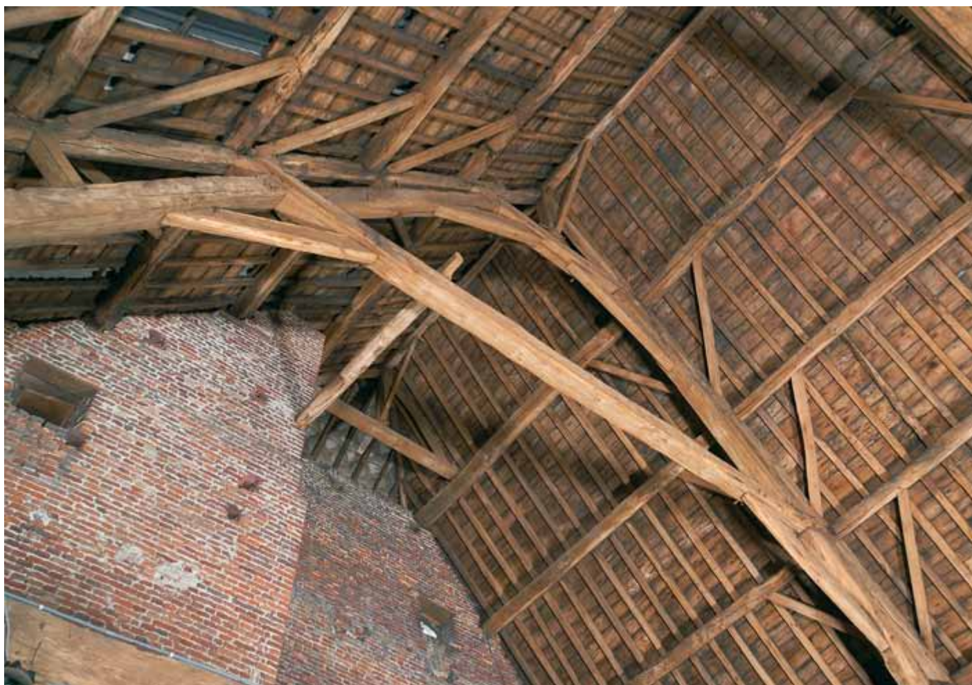
[4.107] Infirmierie, dakconstructie van de schuur (PCCE, Eddy Daniëls, 2006).
