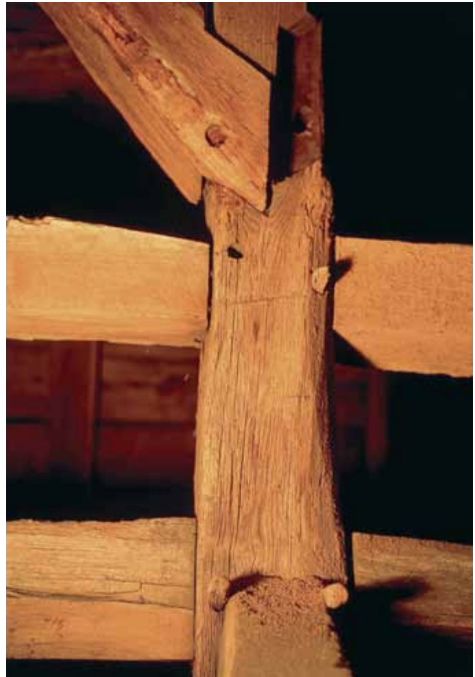
[6.34] Verbindingen van de langsribben met de makelaar van de kap op het westschip (THOC, 2004).
