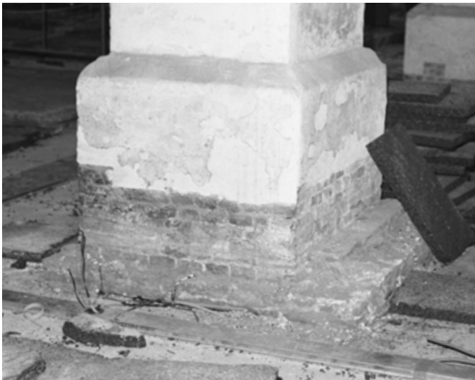
[6.11] Blootgelegde fundering van een pijler aan de noordkant van het oostschip ca. 1980 (PCCE, archiefphoto).
