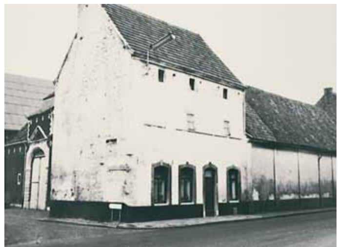
[4.93] Portierswoning, voorgevel vóór de restauratie, ca 1940 (Stad Sint-Truiden).
