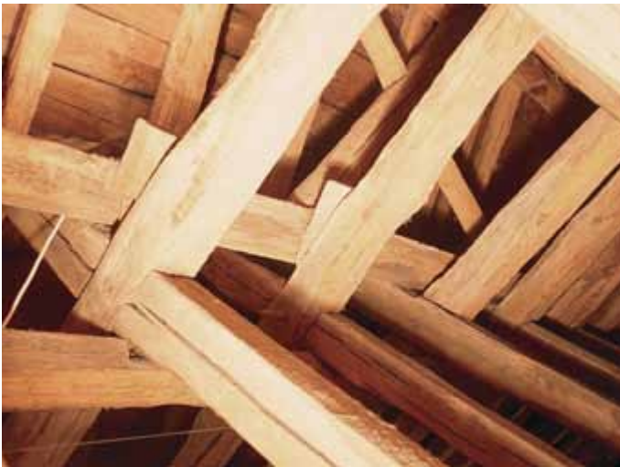
[6.31] De kap op het westship wordt gekenmerkt door een zeldzame constructie met kruisende houten en langscribben (THOC, 2004).
