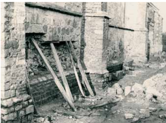
[3.7] Urgentiewerken aan het parement van de zuidelijke zijbeuk, 1934 (PCCE, archiefphoto).
