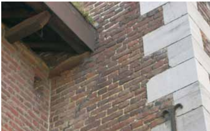
[4.101] Aansluiting van de dwarse scheidsmuur van de schuur bij de consoles van de dakvoet van de infirmérie (PCCE, 2007).
