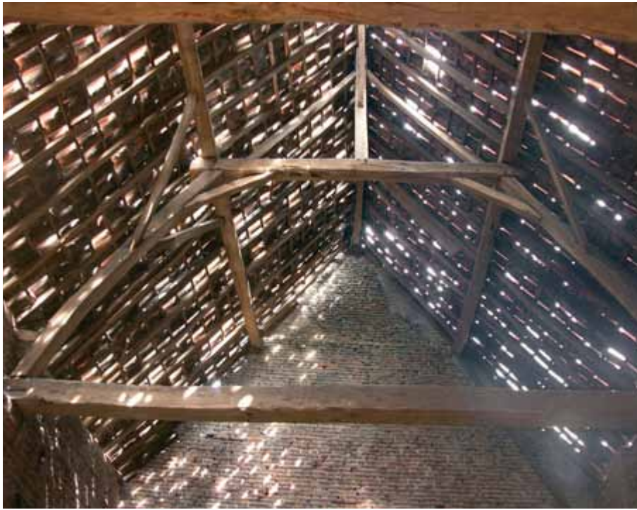
[4.98] Infirmerie, dakspant van de koeienstal (PCCE, 2007).
