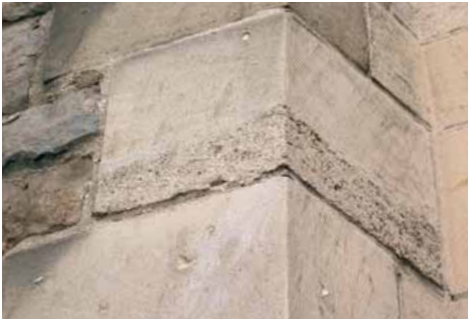
[5.13] Gezaagde blokken van bleekgele Maastrichtersteen als raamomlijsting in de westgevel van de kerk (restauratie). De aanwezigheid van een laagje of band met concentraties van holle buisjes van kalkkokerwormen is karakteristiek voor de Sibbesteen (Roland Dreesen, 2006).
