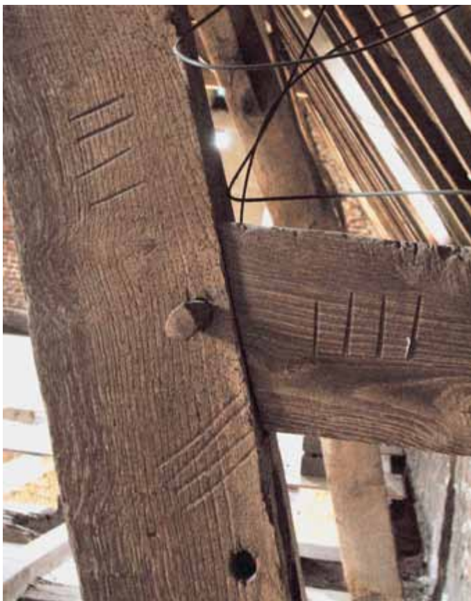
[4.91] Infirmierie, dubbele telmerken van de dakstoel in de noord-zuidvleugel (PCCE, 2007).
