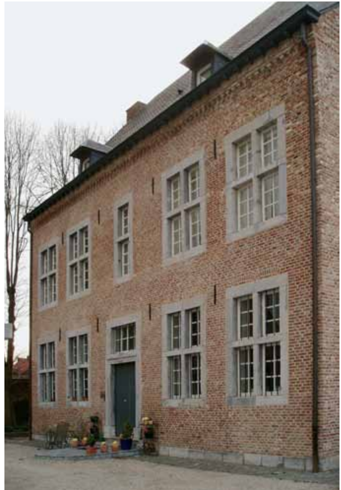
[4.62] Pastorie, Poelstraat, achtergevel na de restauratie (PCCE, 2007).
