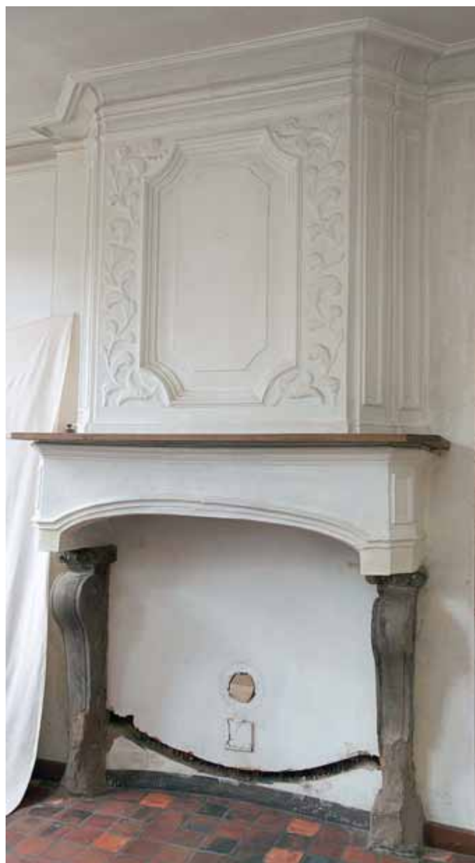
[4.53] Dubbelhuis nr. 61, schoorsteen in de zuidwestelijke kamer op de begane grond, (PCCE, Eddy Daniëls, 2006).
