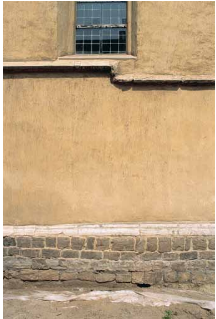
[6.20] Waterlijst en plintband in Gobertangesteent, zuidelijke zijbeuk van het westschip (THOC, 2004).
