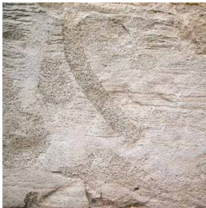
[5.8] Detailopname van een parementsteent in Gobertangesteent: karakteristieke bioturbaties (schuine en ronde doorsneden van graafgangen, opgevuld met wat grijzer zandiger materiaal). Noordelijke buitenmuur van het schip van de begijnhofkerk (Roland Dreesen, 2006).
