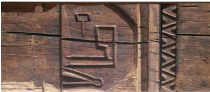
[4.97] Portierswoning, balksleutel van de moerbalk op de begane grond (PCCE, Eddy Daniëls, 2006).
