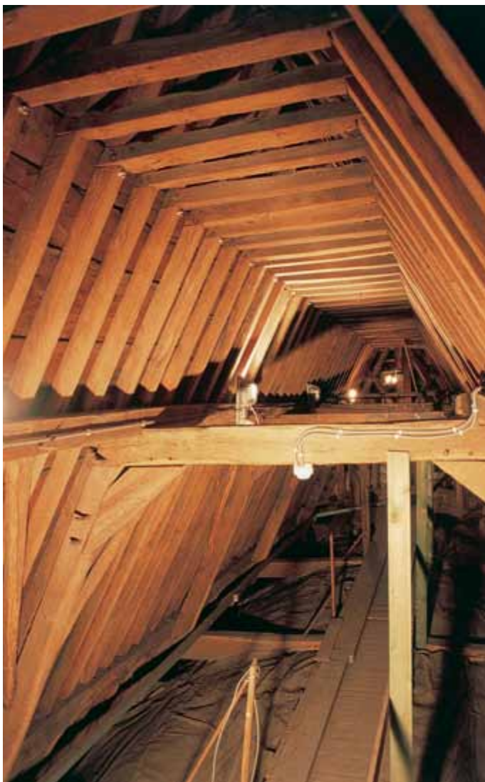
[6.38] Het spel van spanten en sporen van de kap op het oostschip boven het houten tongewelf (THOC, 2004).
