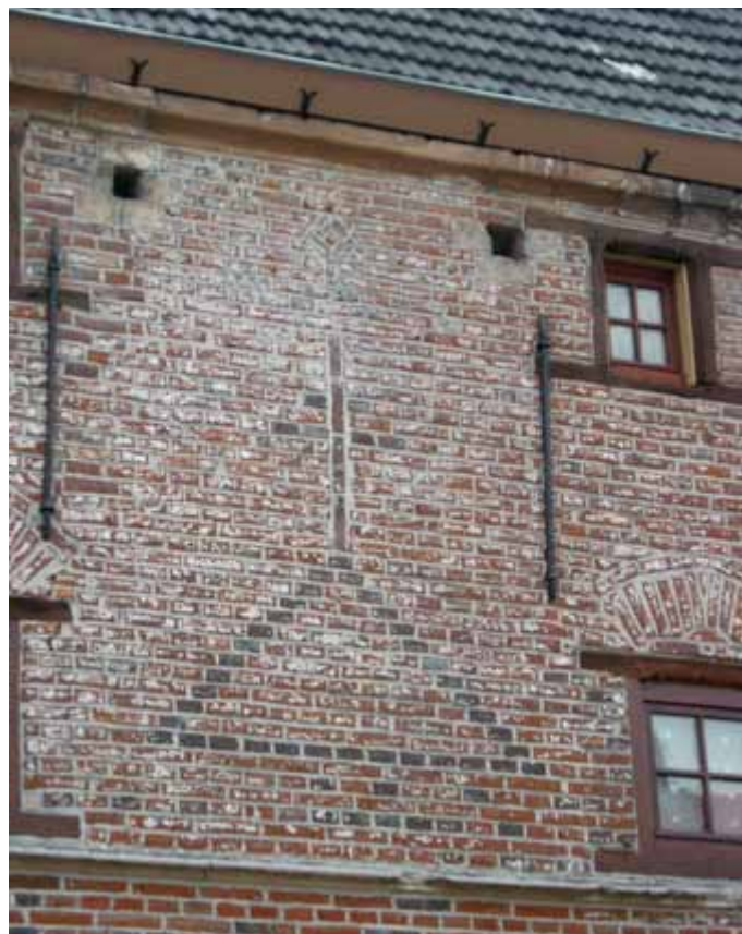
[4.95] Portierswoning, metselaarsteken met calvarie in de voorgevel (PCCE, 2007).
