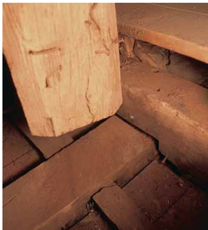
[6.36] Afgezaagde makelaar en later aangebracht tongewelf (THOC, 2004).
