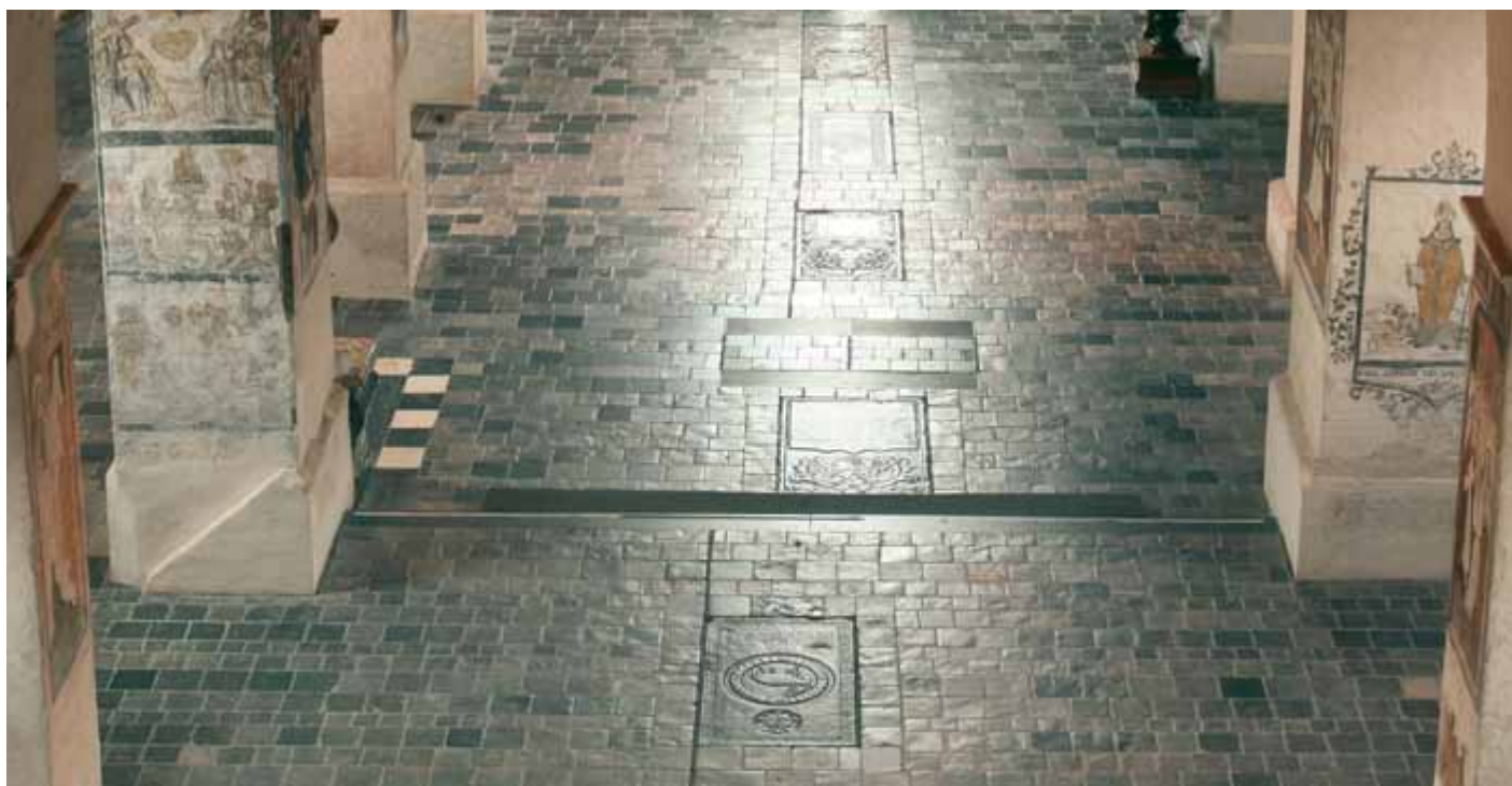
[5.18] Kerkvloer van het schip bestaande uit een mozaïek van gepolijste fijnkorrelige variëteiten van Maaskalksteen in diverse grijsinten (VIOE, Kris Vandevorst, 2007).
