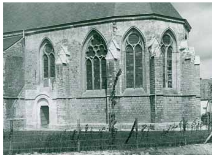
[3.8] Zuidelijke kant van het koor na de vrijlegging van de paradijspoort en de restauratie van de steunberen in 1934 (PCCE, archiefphoto).
