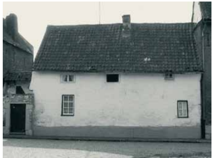
[4.46] Dubbelhuis nr. 9, voorgevel, ca. 1975 (PCCE, archiefphoto).
