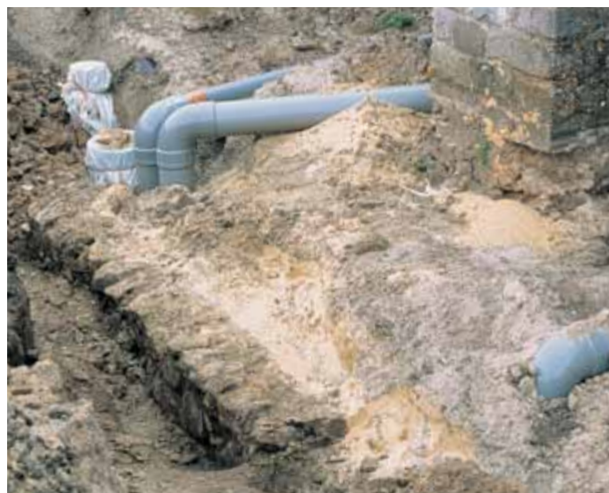
[6.14] Deels bewaarde fundering van het oorspronkelijke schip aan de noordkant, blootgelegd door het Archeologisch Projectbureau ARON (THOC, 2004).
