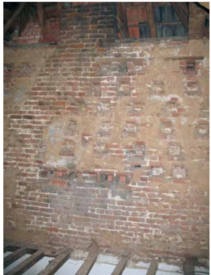
[4.92] Infirmierie, duiventil in de noord-zuidvleugel (PCCE, 2007).
