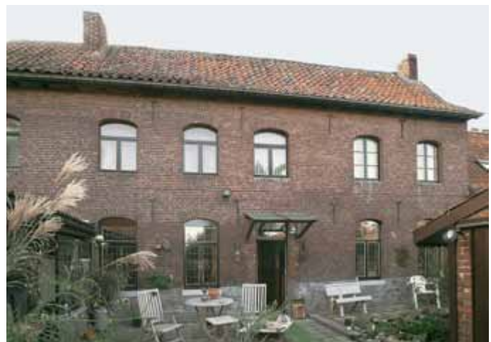
[4.40] Dubbelhuis Infirmieresteeg nr. 56, achtergevel (PCCE, Eddy Daniëls, 2006).
