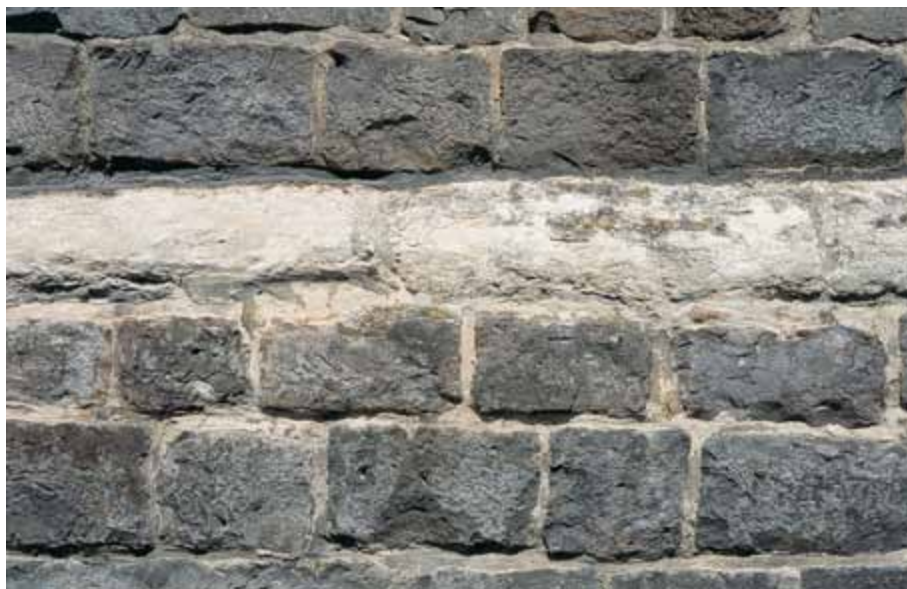
[5.7] Waterlijst in verweerde Gobertangesteent boven en onder Tiense kwartsietblokken. Zuidelijke zijschip van de begijnhofkerk (THOC, 2004).
