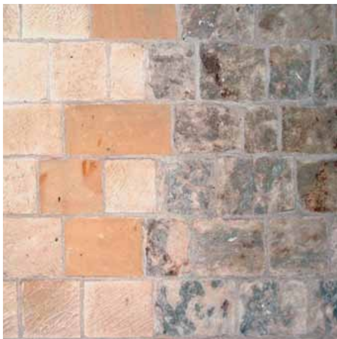
[5.11] Blekere Maastrichtersteen (Sibbesteen), links, ter vervanging van Lincentufsteen in het koor van de kerk (Roland Dreesen, 2006).
