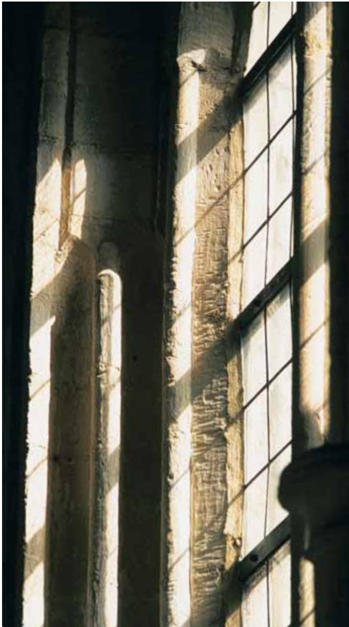
[6.50] Onderbroken profiel van het koorvenster K7 (THOC, 2004).
