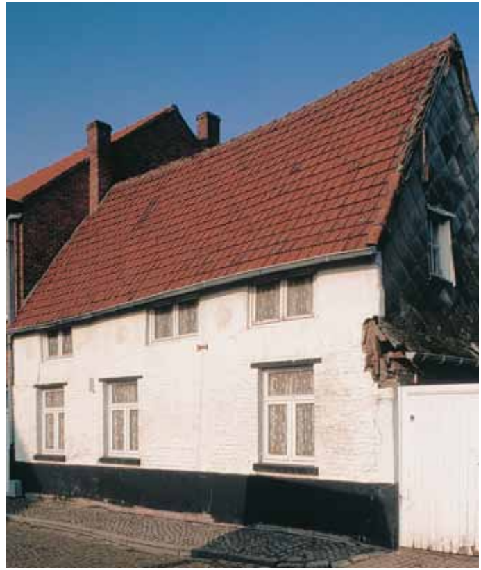
[4.17] Huis nr. 29, voor de restauratie (THOC 2004).
