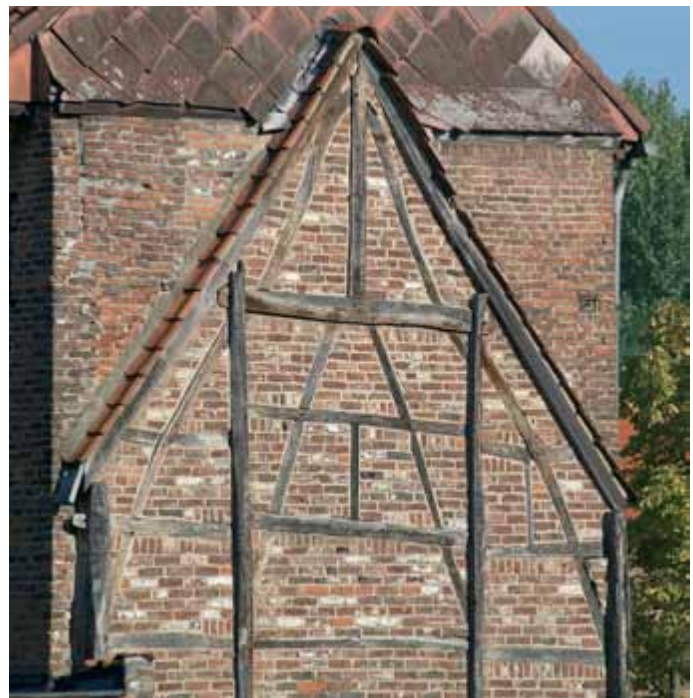
[4.49] Dubbelhuis nr. 9, noordelijke sluitgevel in vakwerktechniek (PCCE, Eddy Daniëls, 2006).
