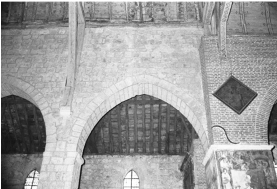
[6.9] Scheiboog van de vierde travee aan de noordzijde en overgang tussen west- en oostschip (PCCE, Foto Graux, 1971).
