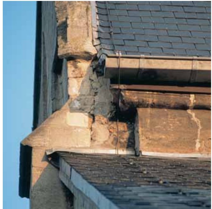
[6.57] 15de-eeuwse kroonlijst van de zuidelijke muur van het westschip: brede rollaag en ineengeknutselde verbinding met de 14de-eeuwse westgevel (THOC, 2004).
