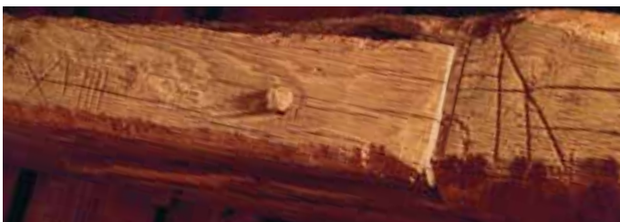
[6.33] Rechts een vlot- of eigendomsmerk, links telmerk 19 op spoor en kruisend hout aan de zuidkant van het westschip (THOC, 2004).
