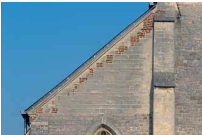
[6.69] Westgevel van de noordelijke zijbeuk: baksteen werd gebruikt om de helling aan te passen (THOC, 2004).
