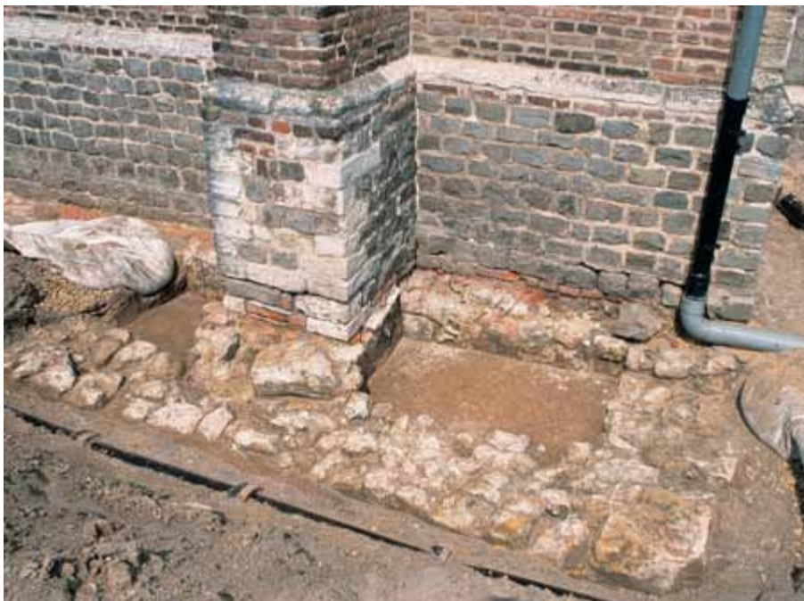
[6.15] Fundering van de noordelijke zijbeuk, proefput onder de bouwnaad in de tweede travee door het Archeologisch Projectbureau ARON (THOC, 2004).
