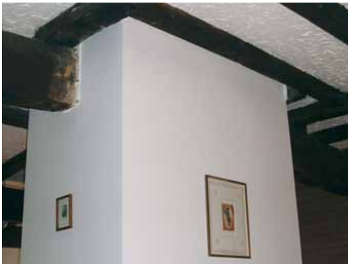
[4.45] Dubbelhuis Infirmieriesteeg nr. 55, dubbele schoorsteen tussen twee zuidelijke kamers (PCCE, 2007).
