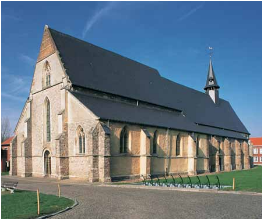
[3.22] De begijnhofkerk voor de renovatie van het plein (THOC 2004).
