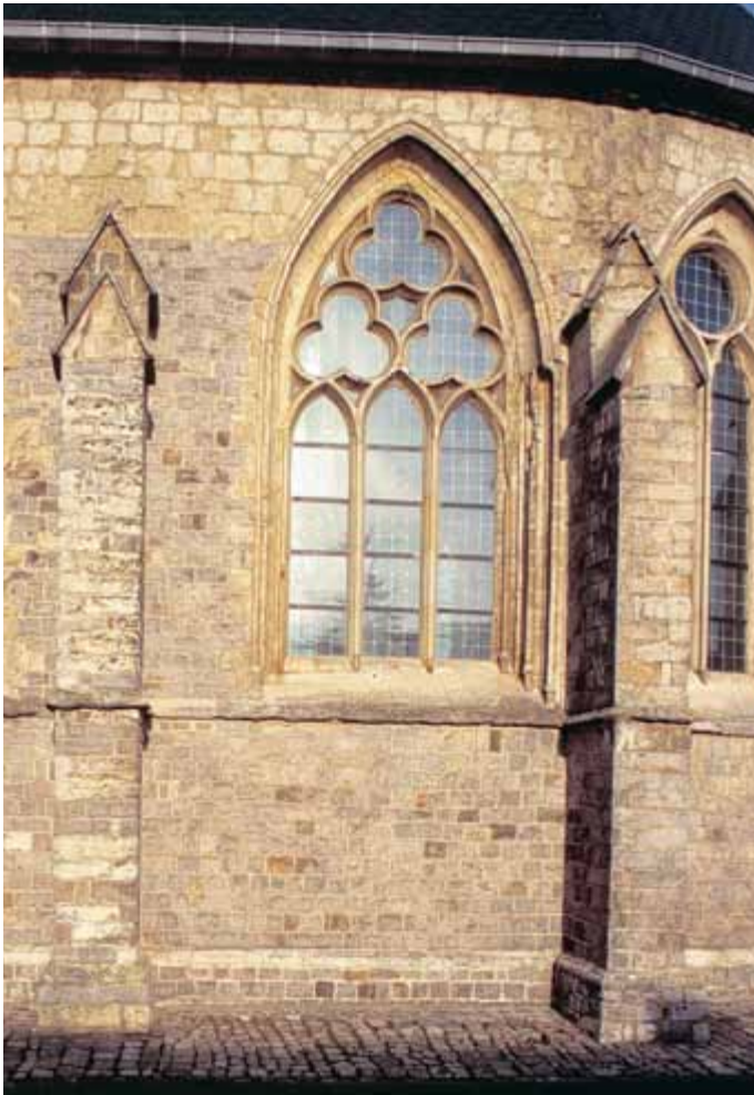
[6.65] Zuidzijde van de koorapsis. Tijdens de tweede bouwfase werd het muurwerk hoger opgetrokken en werden grote gotische ramen met maaswerk aangebracht (THOC, 2004).
