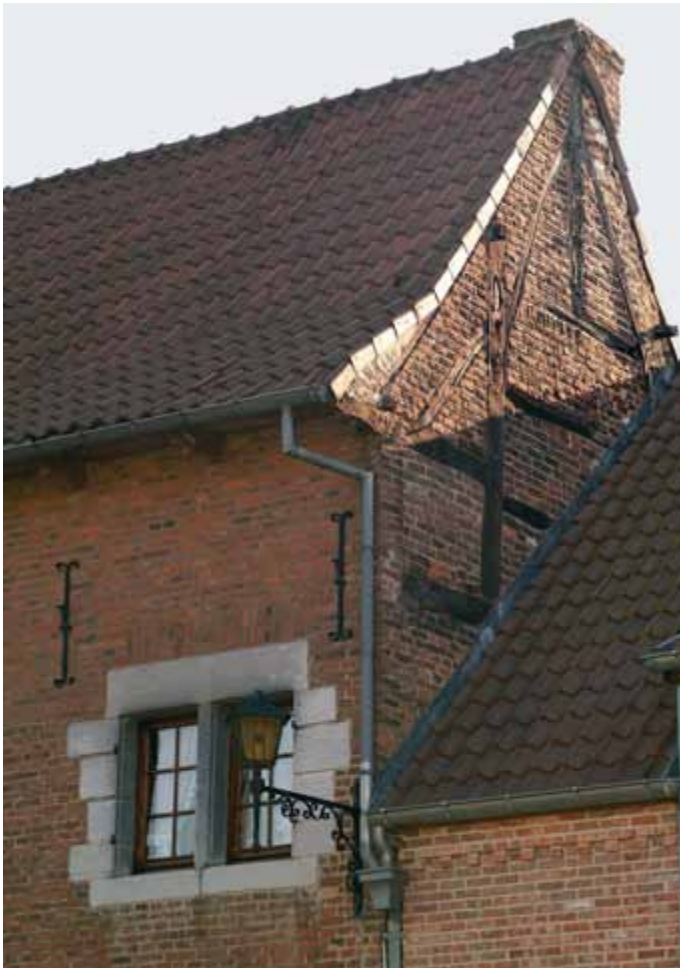
[4.32] Dubbelhuis nr. 10, noordelijke zijgevel (PCCE, Eddy Daniëls, 2006).
