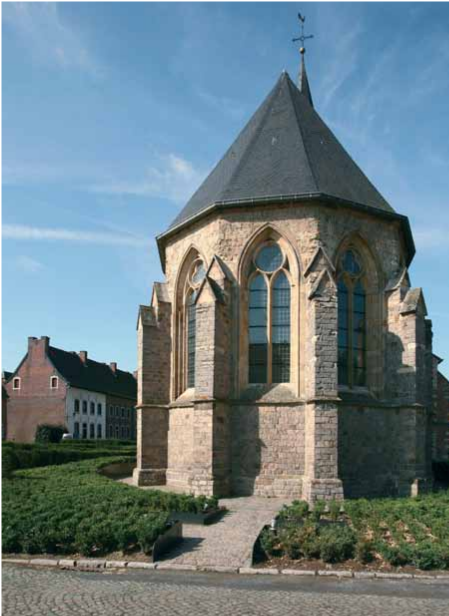
[6.63] Gezicht op de koorapsis. Het materiaalverschil onderscheidt duidelijk de twee oudste bouwfasen (Chris Vandevorst, 2007).
