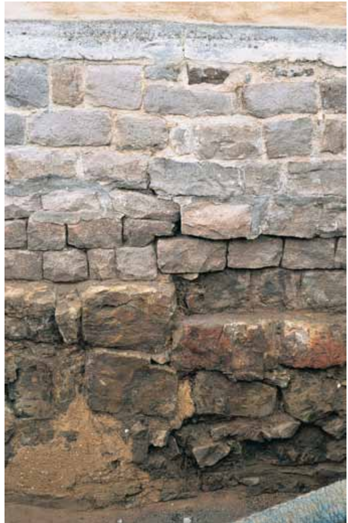
[6.15] Fundering van de noordelijke zijbeuk, proefput onder de bouwnaad in de tweede travee door het Archeologisch Projectbureau ARON (THOC, 2004).
