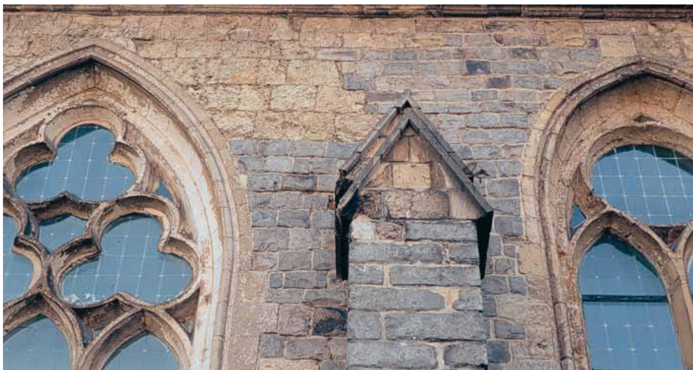
[5.10] Lincentufsteen boven de vensters van het koor. De grijze parementsteen is Tiens kwartsiet (THOC, 2004).
