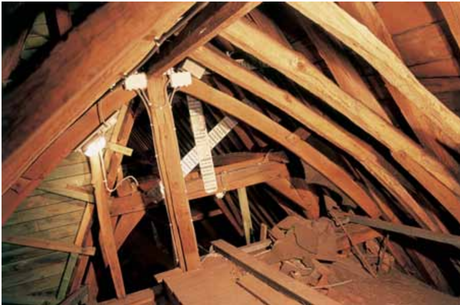
[6.29] Overgang van de kap tussen oost- en westschip, gezien vanuit het westen (THOC, 2004).
