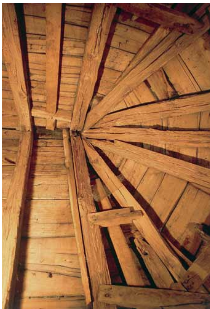
[6.27] Polygonale afsluiting van het dak boven de koorapsis (THOC, 2004).
