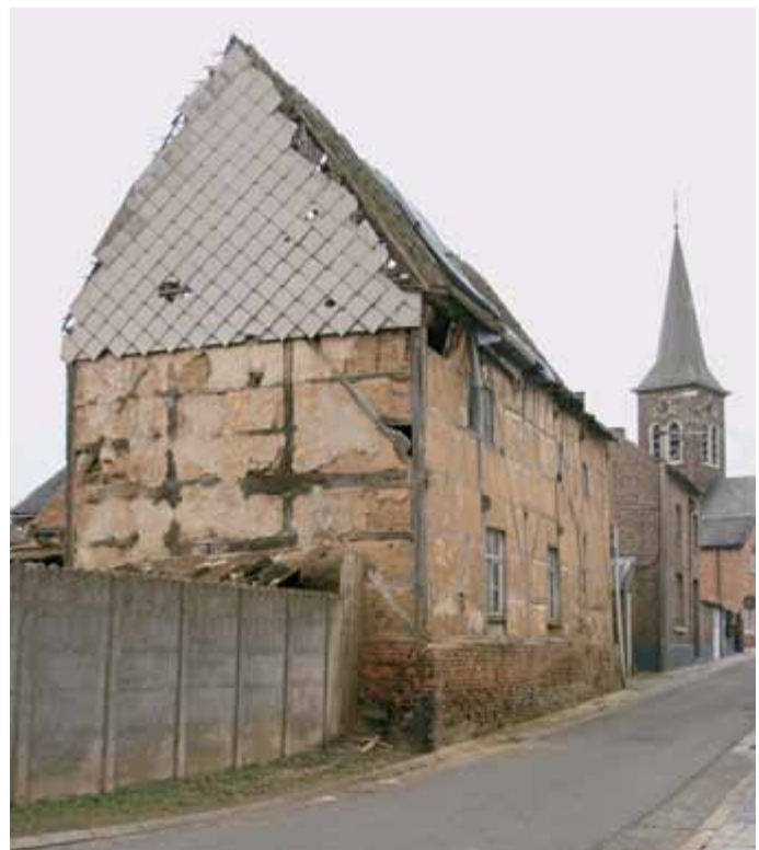
[4.34] Vakwerkhuis uit Attenhoven, uit het einde van de 16de of de eerste helft van de 17de eeuw (PCCE, 2006).
