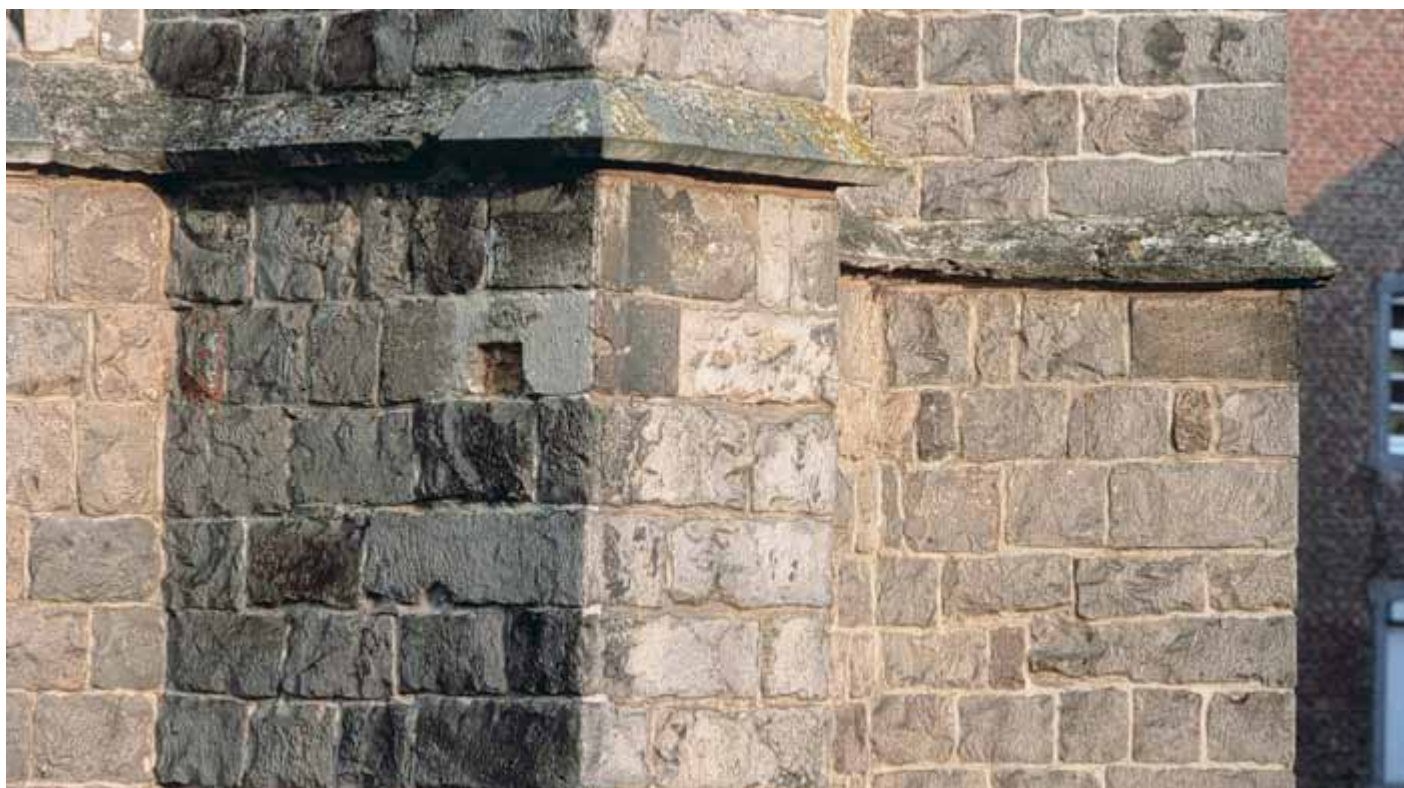
[5.4] Tiens kwartsiet als onderdeel van steunberen aan het koor van de begijnhofkerk. De waterlijst in Gobertangesteent is gekoloniseerd met algen en mossen (THOC, 2004).
