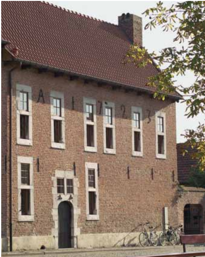
[4.50] Dubbelhuis nr. 61, voorgevel na de restauratie (PCCE, Eddy Daniëls, 2006).
