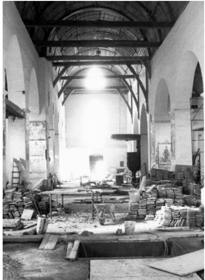
[6.12] Het schip tijdens het plaatsen van de vloerverwarming in 1980 (Marjan Buyle, archiefphoto).
