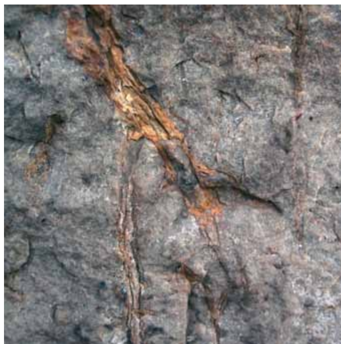
[5.6] Detail van een blok Tiens kwartsiet met geelbruine verkiezelde vertakte wortels. Ondermuur westgevel begijnhofkerk (Roland Dreesen, 2006).
