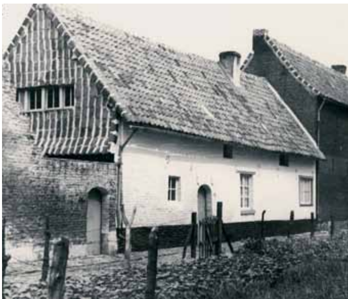
[4.42] Dubbelhuis Infirmieriesteeg nr. 55, voorgevel vóór de restauratie, ca. 1935 (foto PCCE,archieffoto, Achille Thijs).
