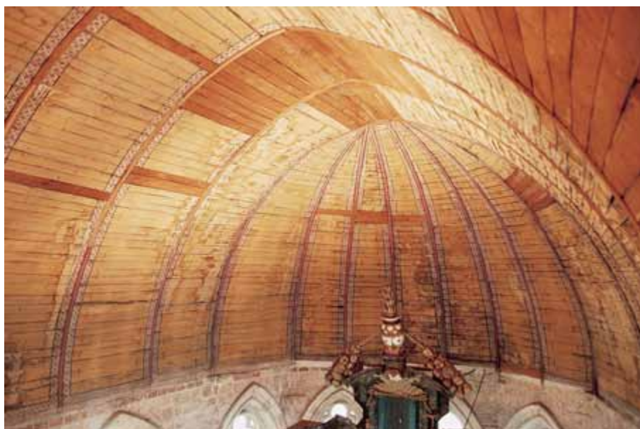
[6.26] De beschieting van het tongewelf op het koor draagt nog sporen van haar kleurrijke afwerking (THOC, 2004).
