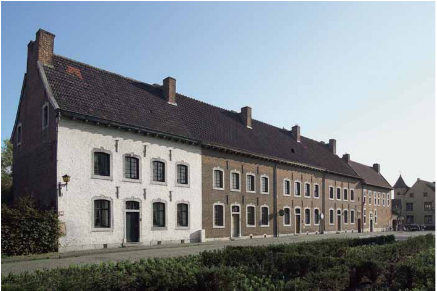
[4.56] Diepe dubbelhuizen nr. 57-60, voorgevels na de restauratie (PCCE, Eddy Daniëls, 2006).
