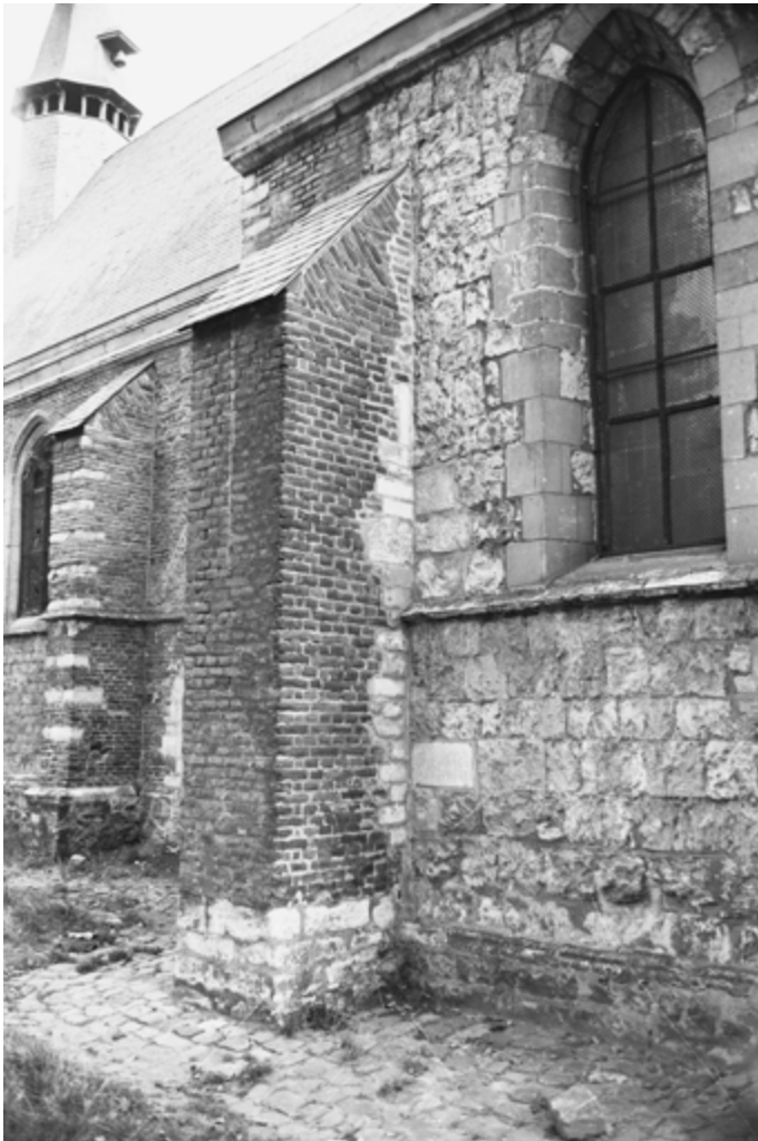
[6.19] Toegevoegde steunbeer aan de noordkant van het westschip (PCCE, Foto Graux, 1971).
