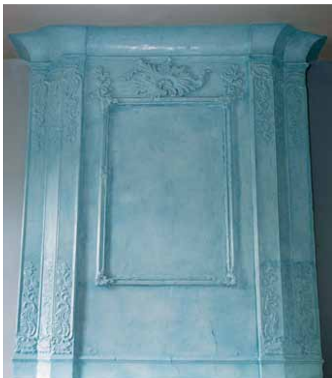
[4.52] Dubbelhuis nr. 61, schoorsteen in de noordoostelijke kamer op de begane grond (PCCE, Eddy Daniëls, 2006).
