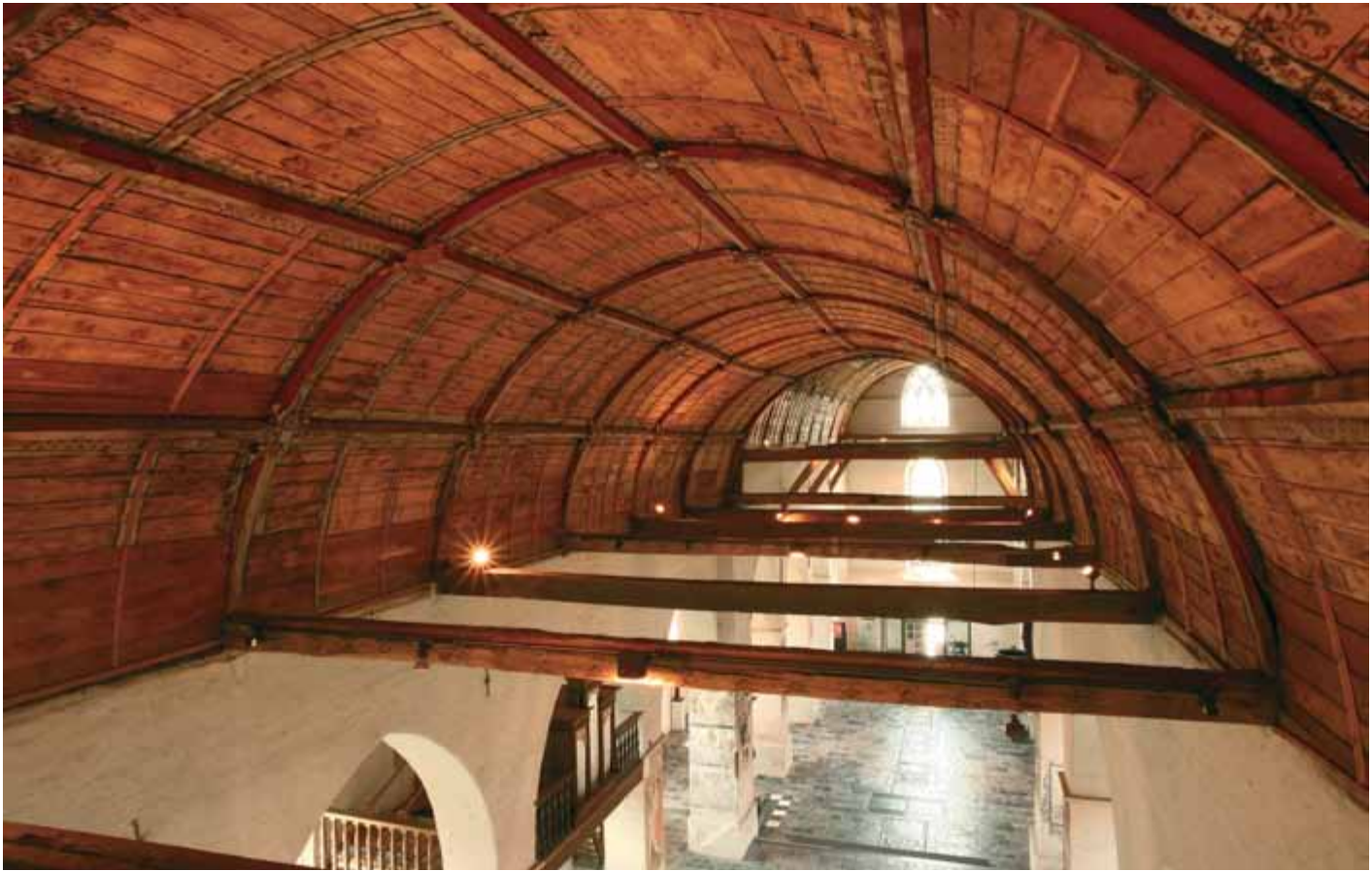
[6.23] Het houten tongewelf met ribben op het schip werd in twee fasen aangebracht (VIOE, Kris Vandevorst, 2007).
