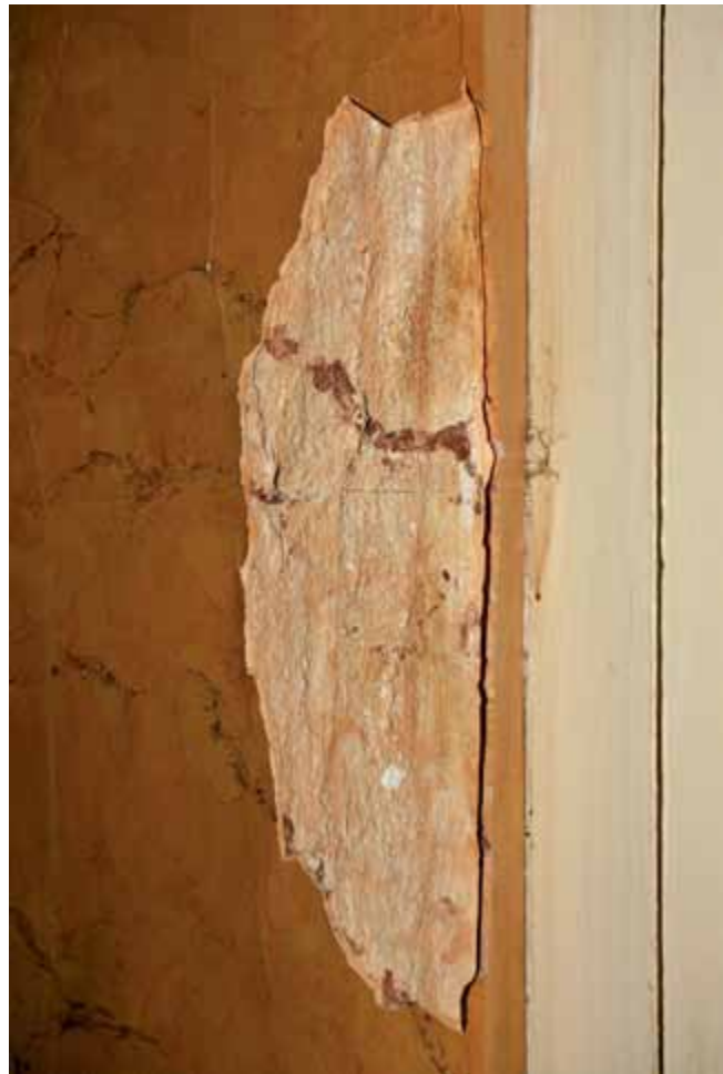
FIG. 20.4 Losgekomen stucmarmer en de onderliggende pleisterlaag met beschildering.
