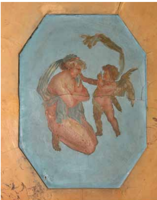
FIG. 20.11 De slordig aangebrachte blauwe overschildering rond de figuren. Bemerkt ook de barsten in het stucmarmer.
