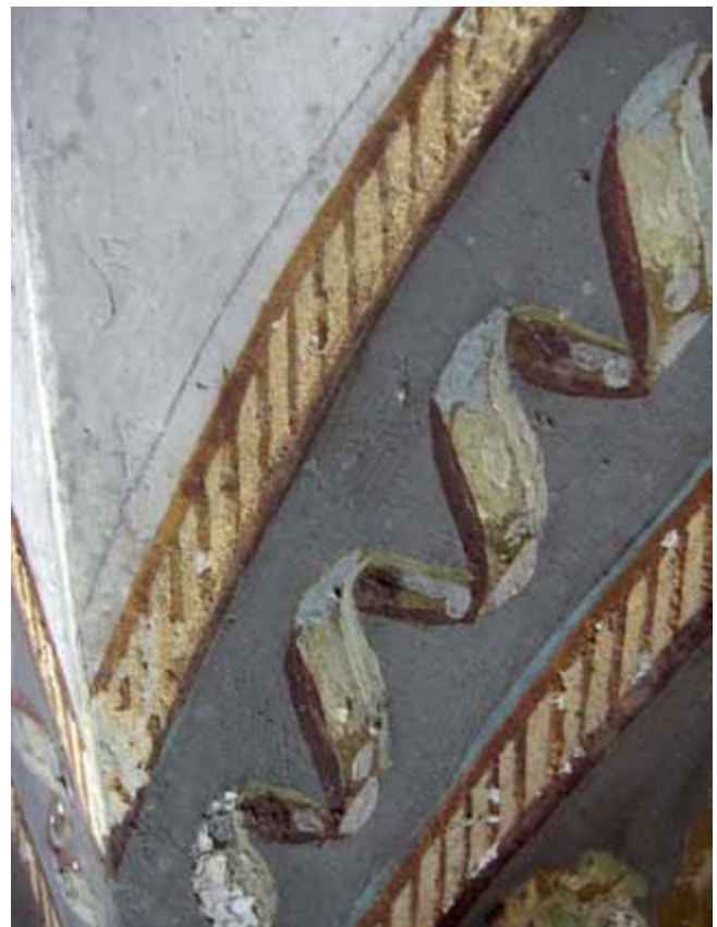
FIG. 20.19 De vergulde boorden onderaan de koepel. Bemerkt de potloodlijnen. (foto E. Jacobs, VIOE).
