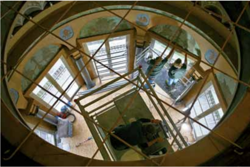
FIG. 20.2 Werkzaamheden tijdens het onderzoek.
