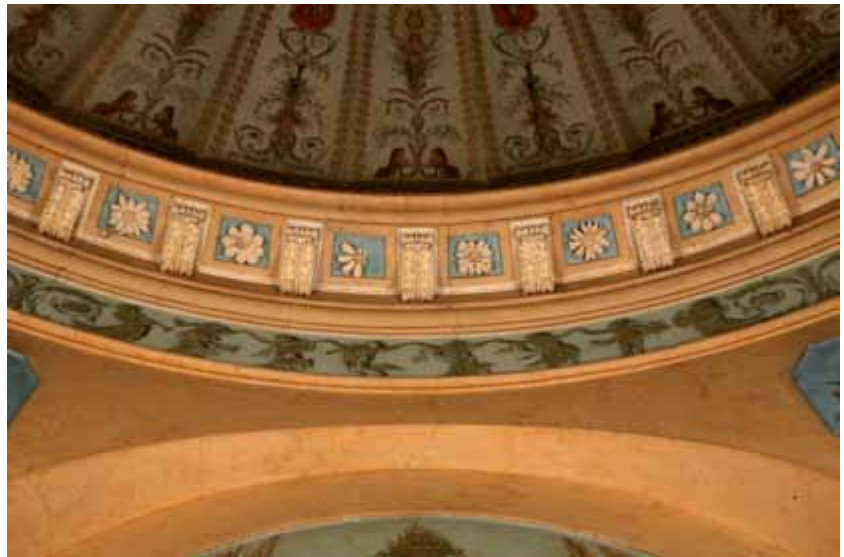
FIG. 22.25 Kroonlijst en aanzet van de koepel in het salon (2008).
