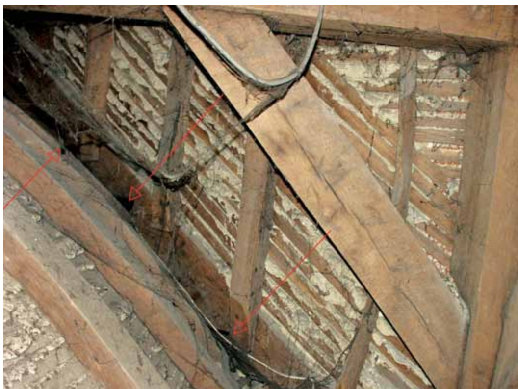
FIG. 13.25 Trapboom in de koepelconstructie.
