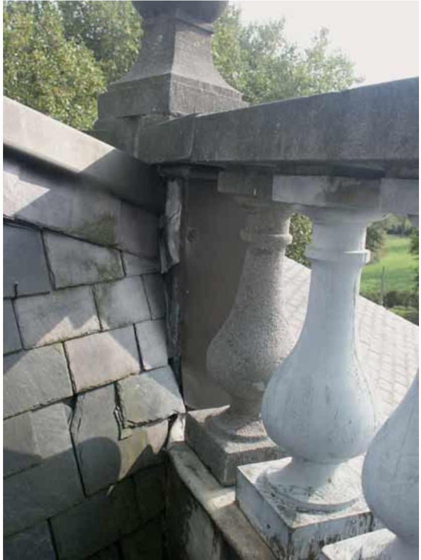
FIG. 13.21 Uitvullaag tussen de houten balusters en de handlijst (foto Willem Hulstaert, VIOE).
