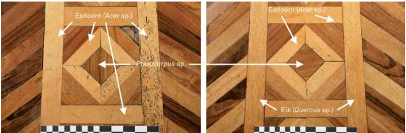
FIG. 17.5 Details van de parketvloer, met aanduiding van de verschillende houtsoorten.
