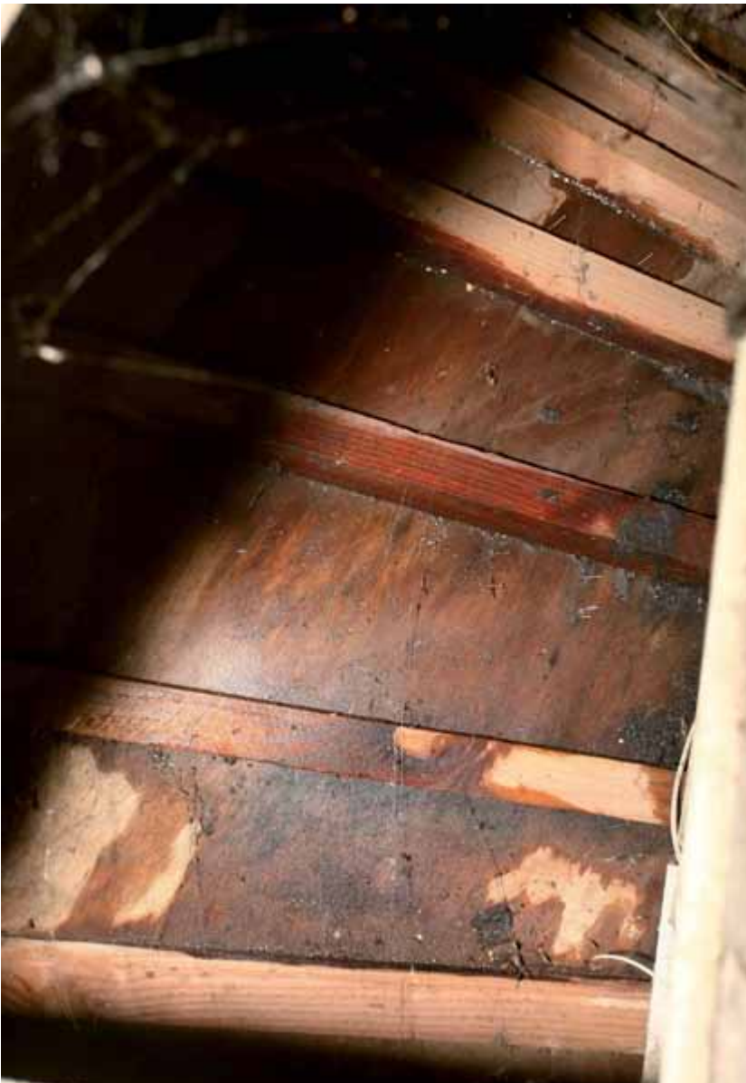
FIG. 13.27 Aantasting van het boogveld van de bovenste galerij van het salon.
