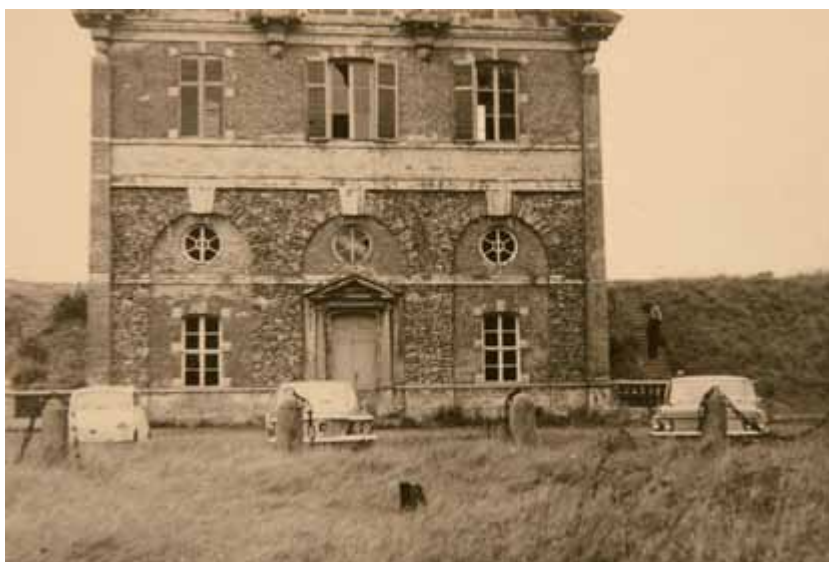
FIG. 10.3 De landgevel omstreeks 1960. Aan weerszijden van het paviljoen stond toen nog een balustrade. De trap op de dijk werd bij de restauratie van 1964–1965 afgebroken. Let op de beschadigde ruiten en het ontbrekende vensterluik (foto collectie L. Bovijn).
