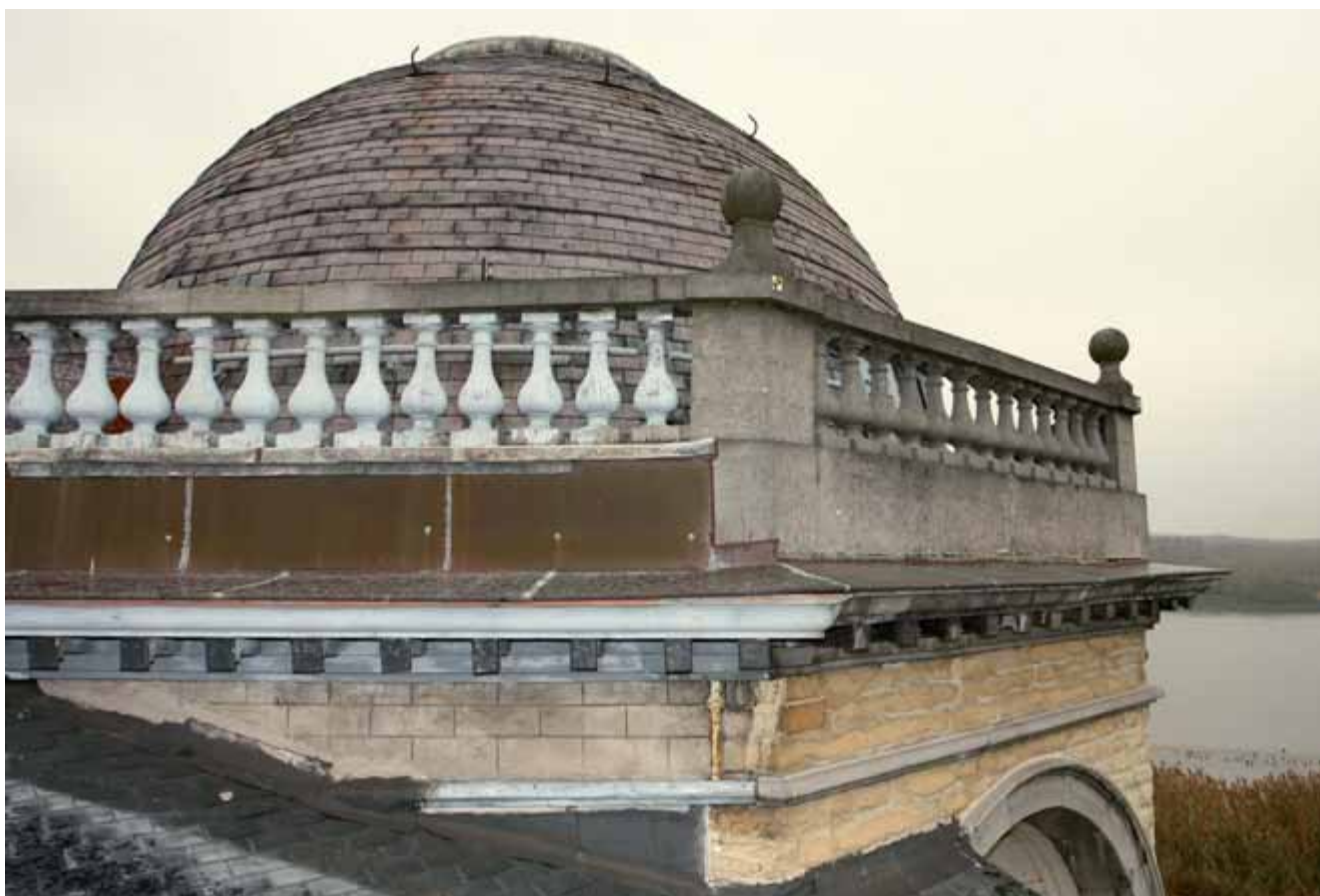
FIG. 10.2 De balustrade met houten balusters aan de achterzijde van de bovenste galerij. De balk waarop ze staan is deels met koper en deels met lood bekleed.
