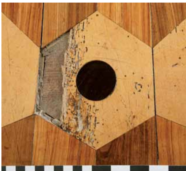
FIG. 16.2 Loszittende plankjes van de parketvloer kunnen weggenomen worden zodat de onderliggende vloer zichtbaar wordt.
