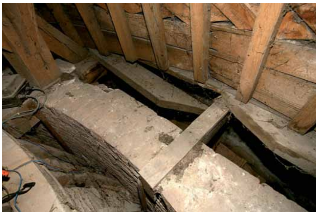
FIG. 13.24 Minimale opleg van de muurplaat.
