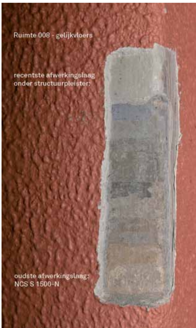
FIG. 15.7 Stratigrafisch venster op de doorgang tussen ruimten 007 en 008, met een vijftigtal flinterdunne kalklagen in lichte tinten.
