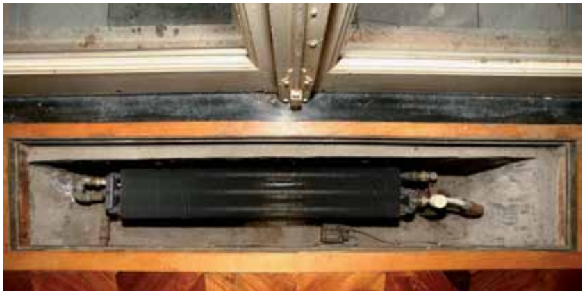
FIG. 13.36 Een van de convectoren in het salon.
