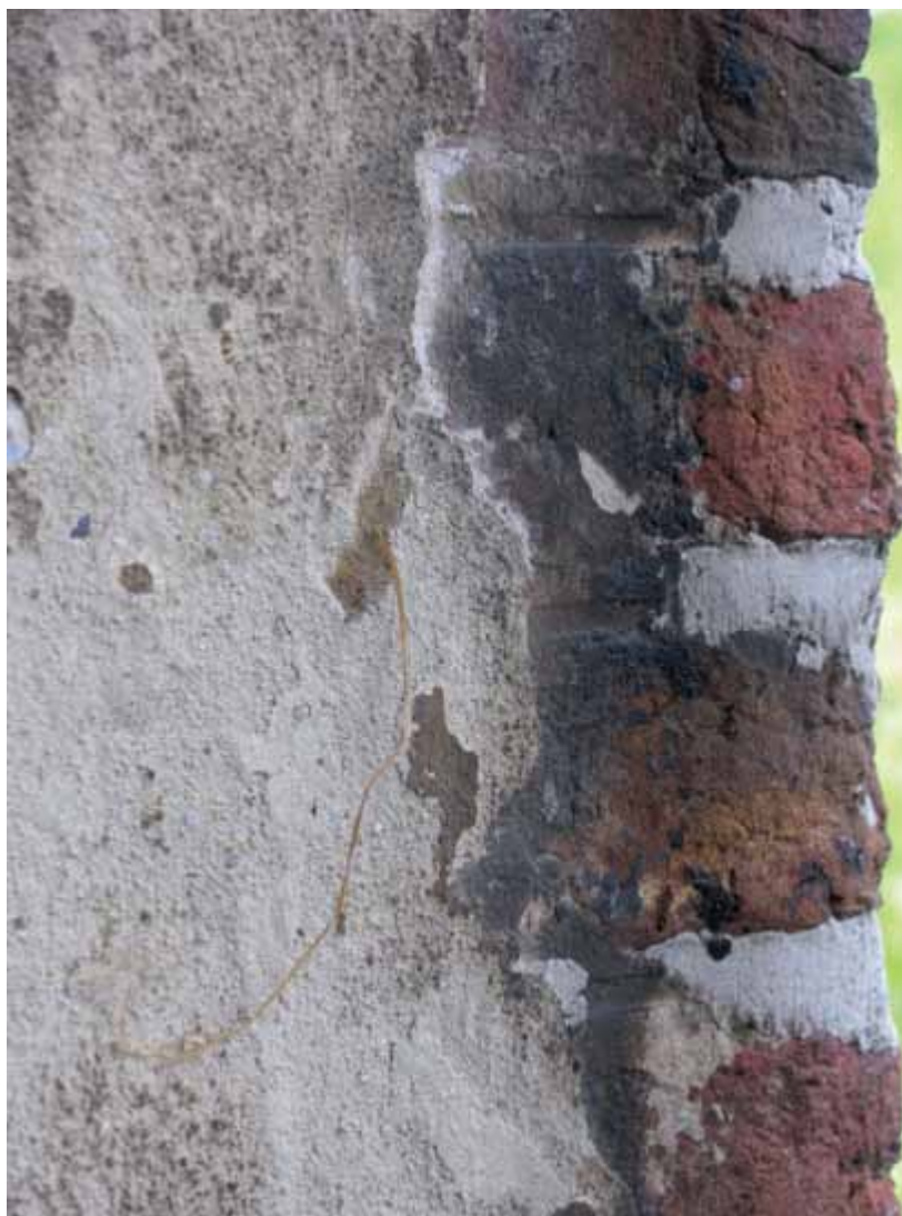
FIG. 11.9 Resten van een afwerking met ingedrukte imitatievoegen, op de westelijke dagkant van de doorgang van de tussenverdieping naar de Scheldedijk.
