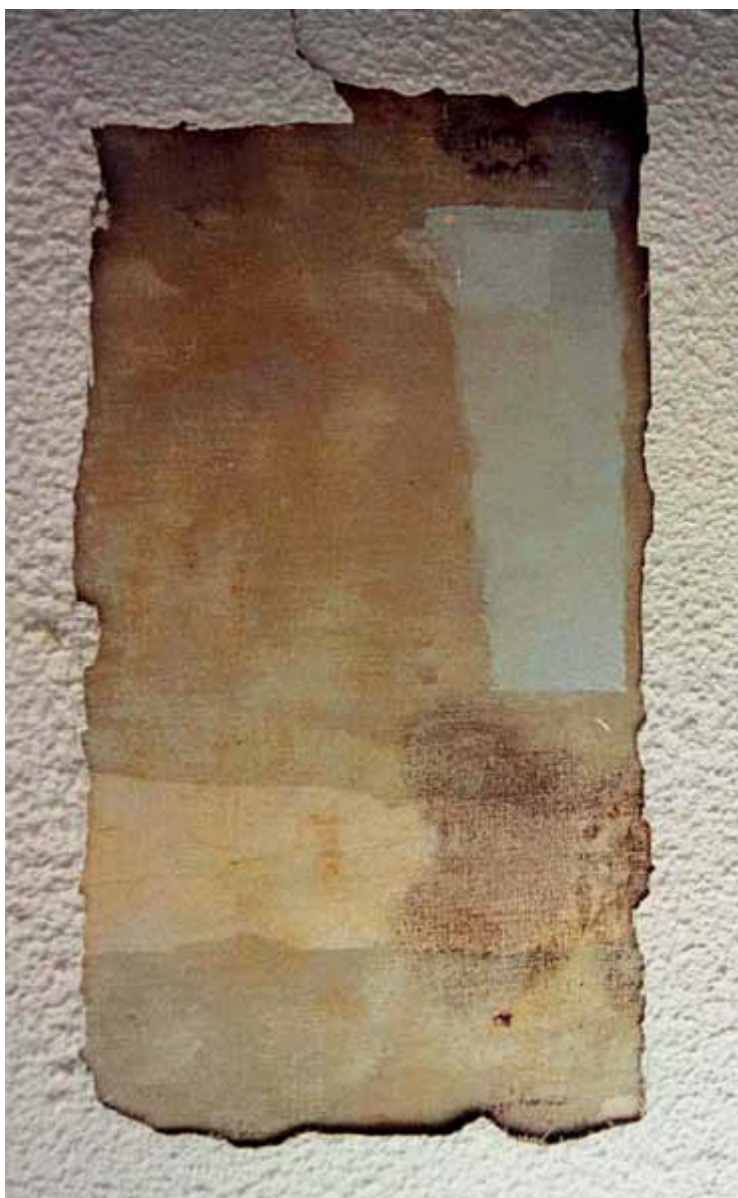
FIG. 15.12 Muurvlak in lichtblauw in het oostelijke petit salon (kleurenonderzoek 2000; foto Marjan Buyle, VIOE).
