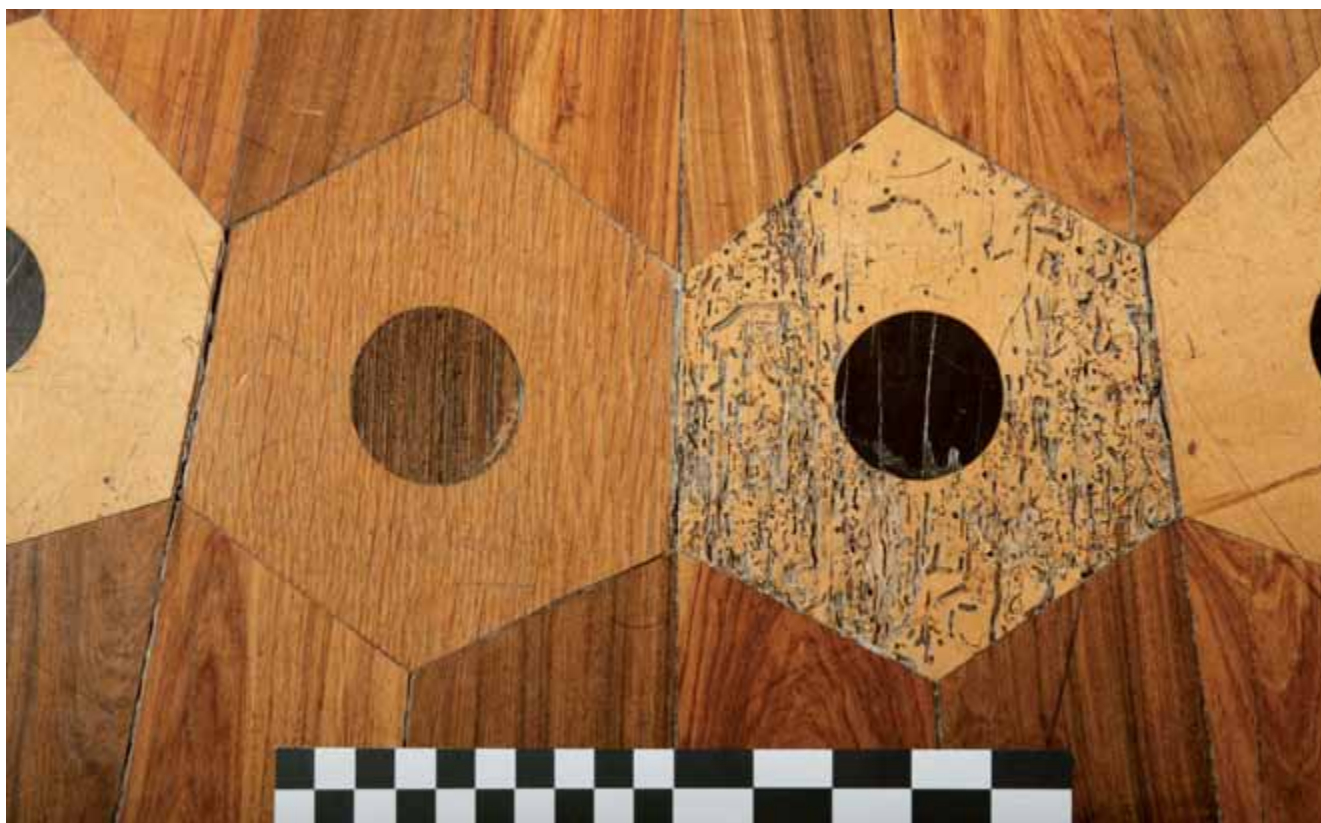
FIG. 17.10 Detail van de parketvloer, met een zeshoekig stuk esdoorn dat zwaar aangetast is door insectenvraat.
