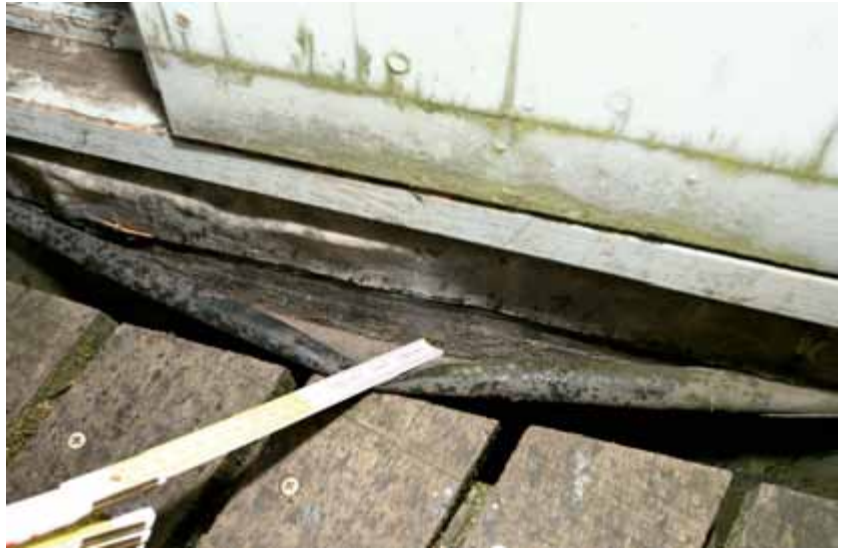
FIG. 13.28 Onder de deurdorpel is de rubberen gootbekleding van de bovenste galerij losgekomen.
