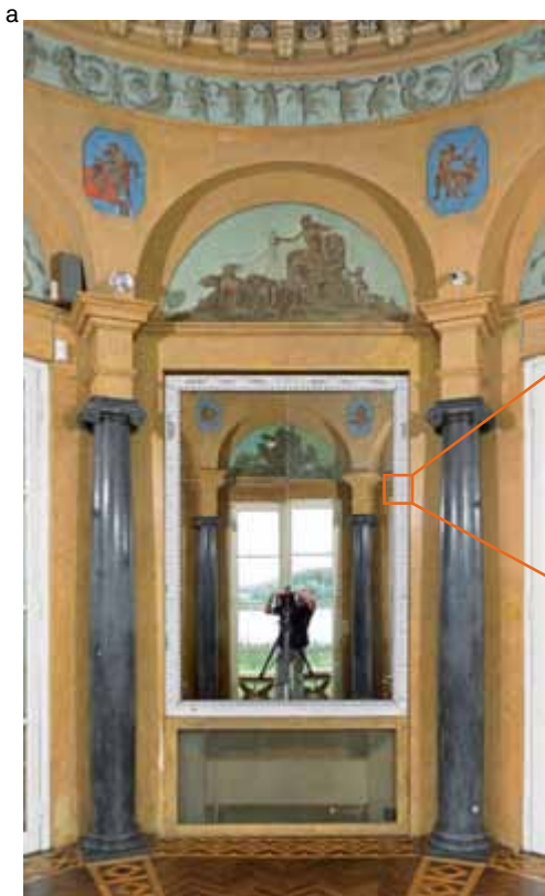
FIG. 15.15 a: Algemeen zicht met de spiegel en de aankleding van het salon rond . Op het paneeltje linksboven is de originele rode achtergrondkleur opnieuw zichtbaar gemaakt die later blauw werd overschilderd; b: Kleurenonderzoek van de spiegellijst; c&d: Kleurenreferenties van de spiegellijst.
