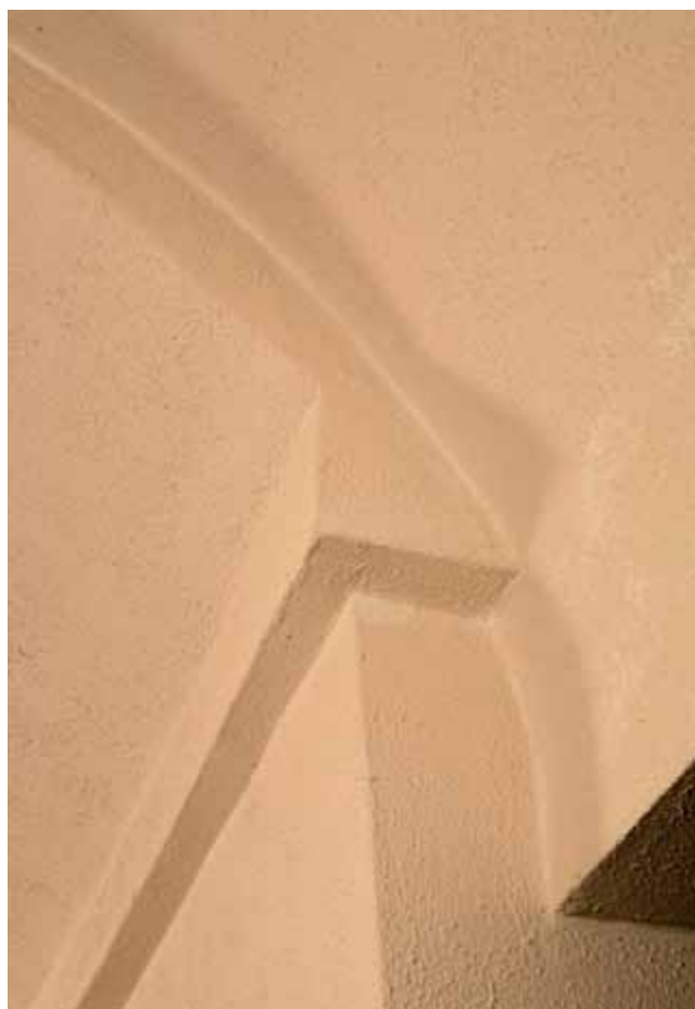
FIG. 15.6 Het twintigste-eeuwse structuurpleister dat de meeste bouwonderdelen van de beneden- en tussenverdieping overdekt en het onderzoek bemoeilijkte.
