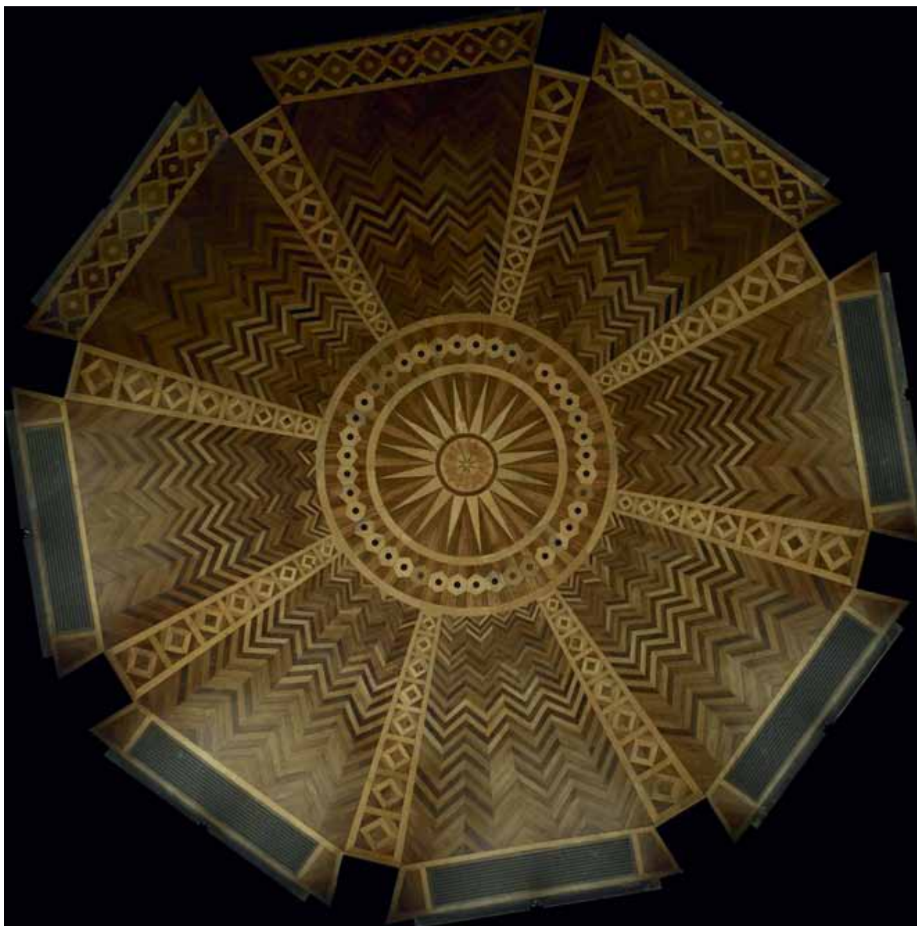
FIG. 13.16 Orthofoto van de parketvloer in het ronde salon (foto ATO, Vlaamse overheid).
