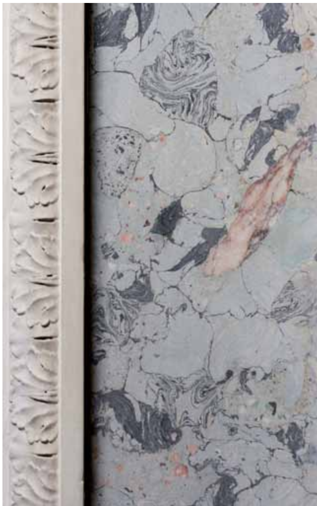
FIG. 19.33 Buitengoed Walckiers (thans Belvédère) in Laken. Stucmarmer in de werkkamer (foto KIK-IRPA).
