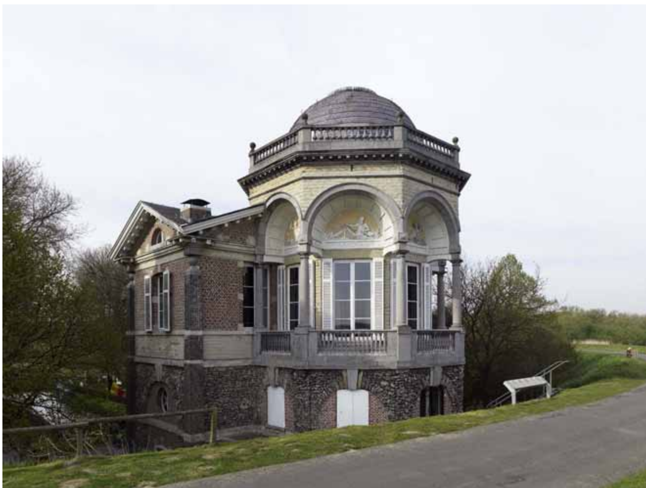
FIG. 3.4 De belvédère en oostelijke zijgevel in 2008.
