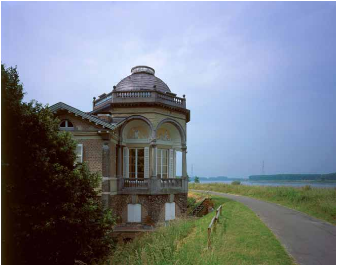
FIG. 3.3 De belvédère en oostelijke zijgevel in 2001.
