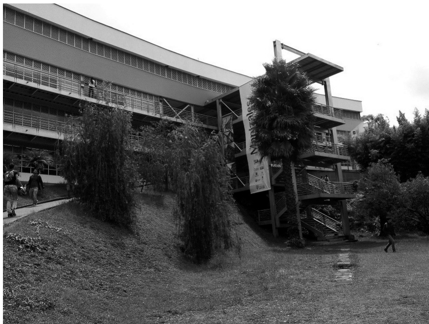
Figura 10.20 Acceso a la parte superior del campus a través de una rampa empinada, una rampa o una escalera
