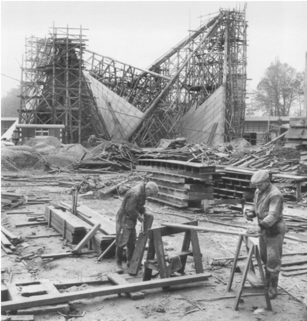
Figure 10 : Vue du chantier du Pavillon Philips (été 1957), montage des panneaux préfabriqués.
