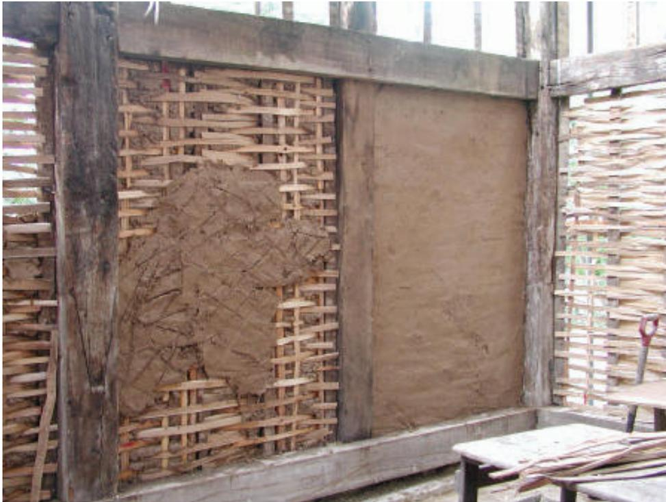
*Figura 2.2: Paredes de terra sobre engradado em madeira*
