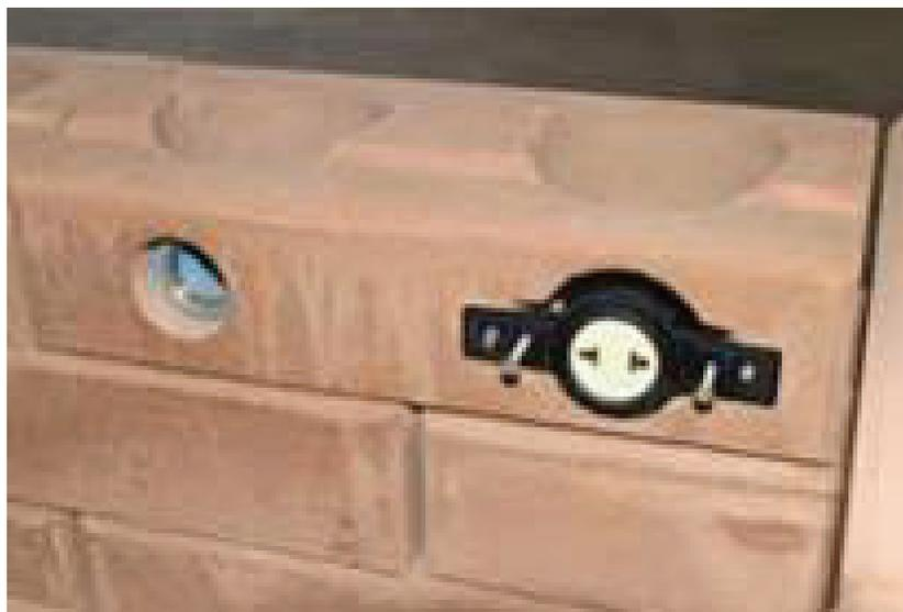
*Figura 2.20: BTC com encaixes tipo machofemêa: a) Unidades simples; b) Unidades de BTC com instalações eléctricas*
