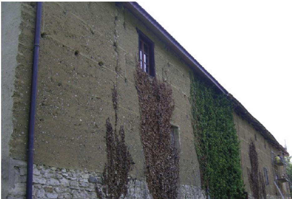
*Figura 5.1: Casa com parede de taipa com 150 anos no Sul de França (Bui et al., 2008)*
