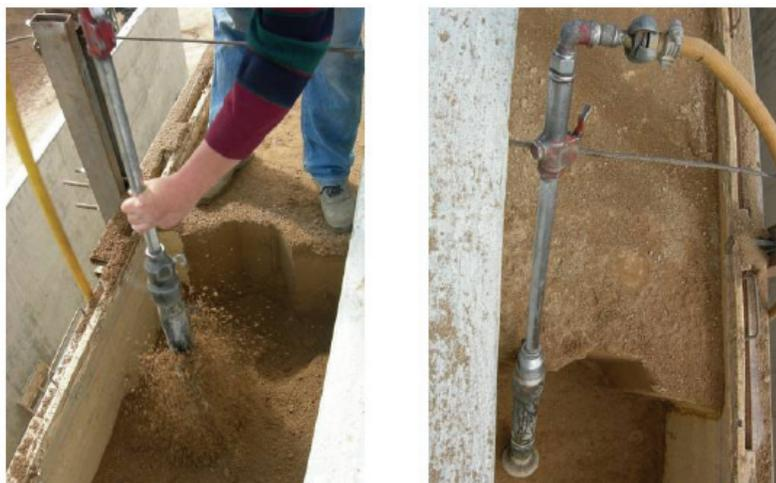
*Figura 2.10: Compactação de terra por meios mecânicos (Foto da firma Betão e Taipa- Construção de adega, Herdade do Rocim)*
