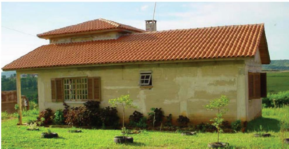
*Figura 5.2: Casa com paredes de solo-cimento compactado após 1 ano de uso (Soares et al., 2004)*
