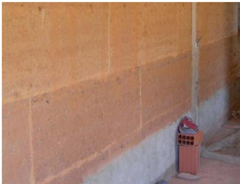
*Figura 8.8: Reconstrução de parede de taipa com subida do lintel de fundação*
