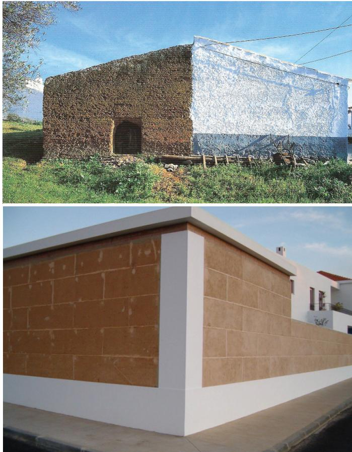
*Figura 6.1: Alvenaria de taipa: a) Solução tradicional com revestimento somente na parte habitacional; b) Solução contemporânea sem revestimento*
