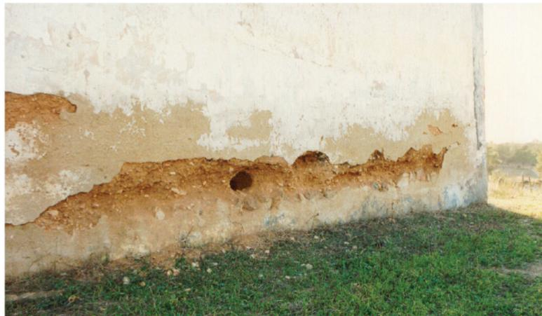
*Figura 7.4: Erosão da base de uma parede em terra por acção da água*
