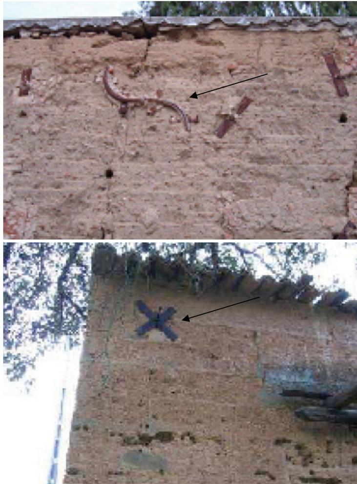
*Figura 4.14: Construção corrente em taipa reforçada com tirantes de aço, correspondente à medida de reforço 3 (Gomes, 2008)*
