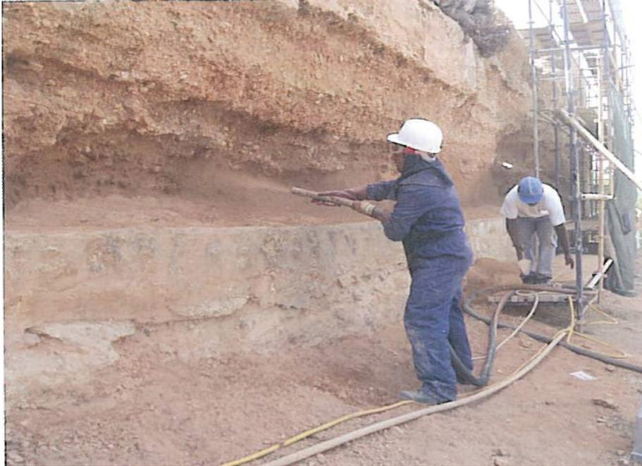
*Figura 8.3: Reabilitação de alvenaria com projecção de terra a alta pressão*
