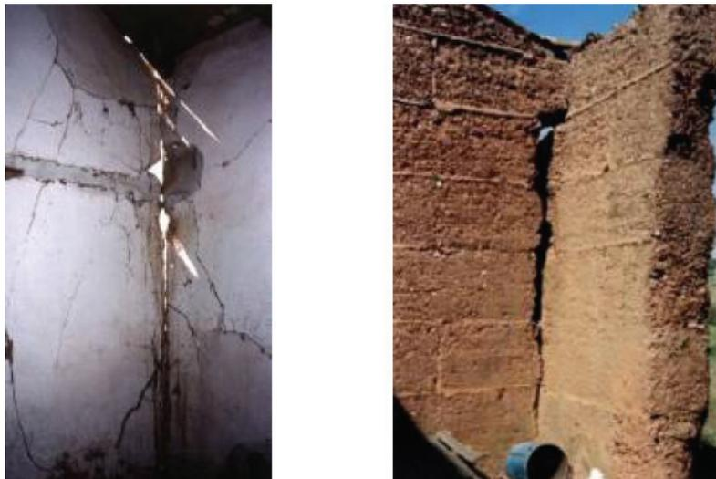
*Figura 7.2: Desligamento de panos de parede por rotação da fundação*
