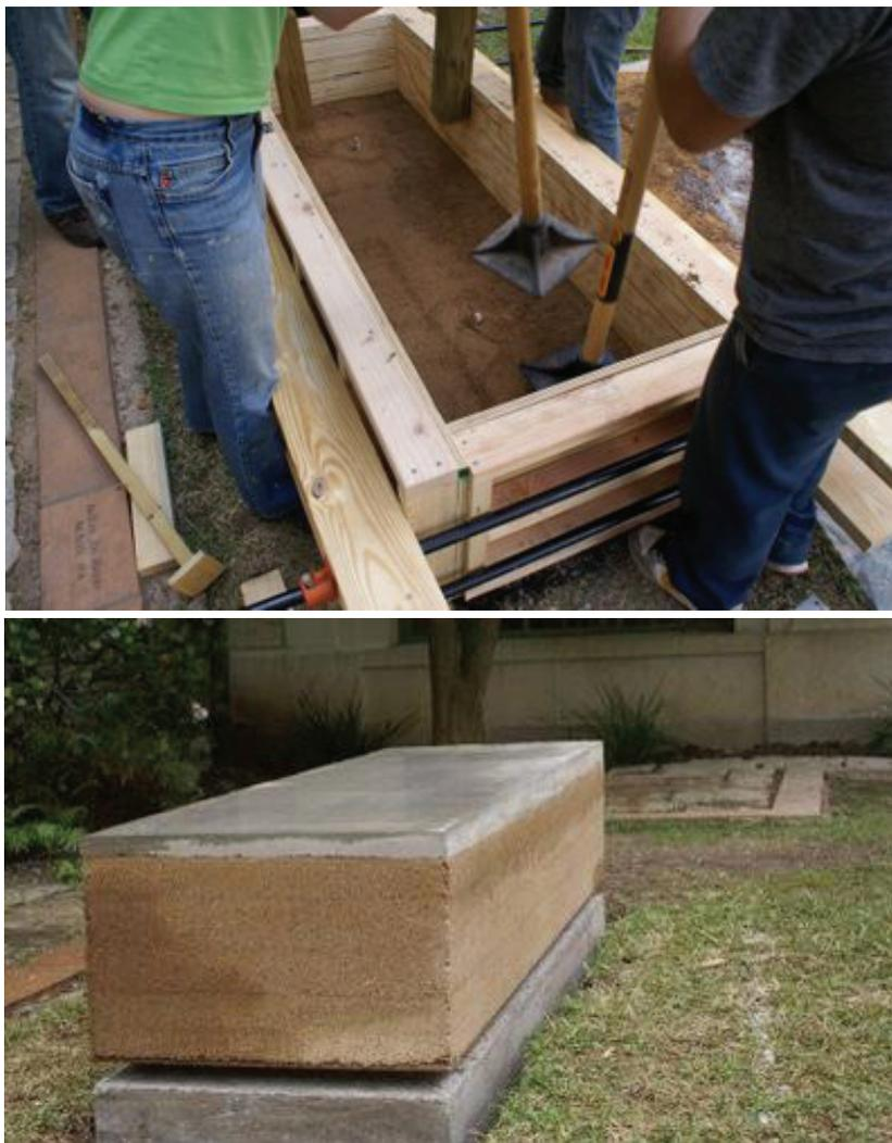
*Figura 1.13: Construção de banco de jardim: a) Compactação da taipa; b) Execução do topo do banco com betão; c) Aspecto final.*
