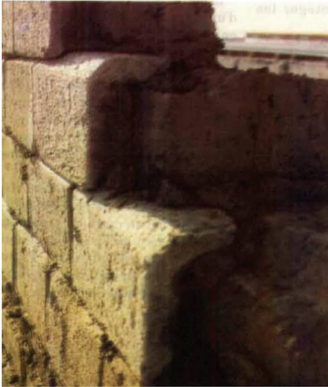
*Figura 2.15: Construção de parede em "Adobeton" (Martin, 1998)*
