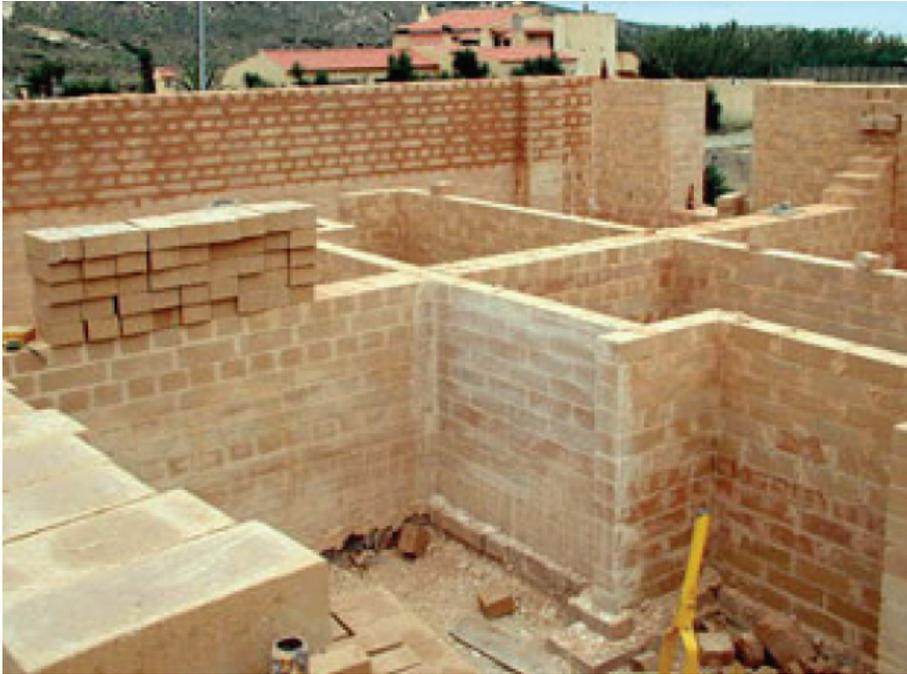
*Figura 2.17: Construção de alvenarias com recurso a BTC, Alentejo*
