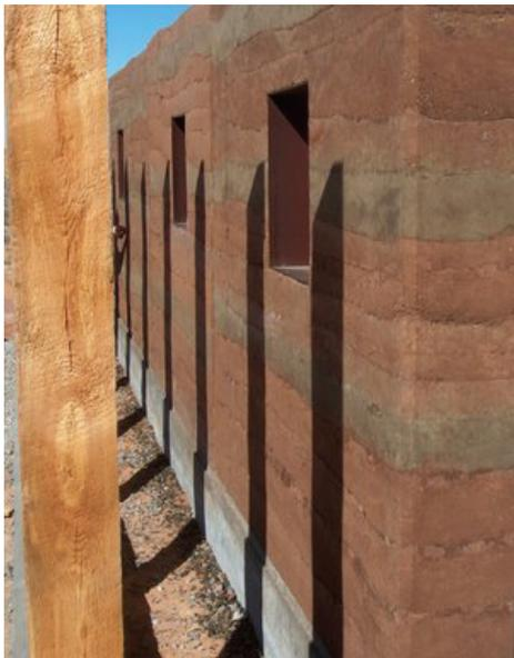
*Figura 1.12: Parede de Trombe em taipa construída no âmbito do programa Design Build Bluff*
