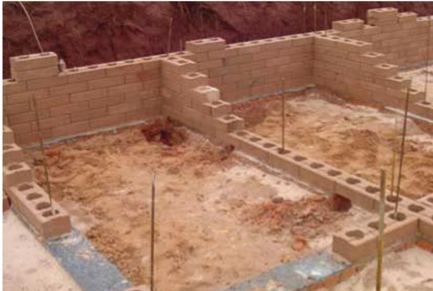
*Figura 2.19: Construção em BTC com estrutura incorporada*
