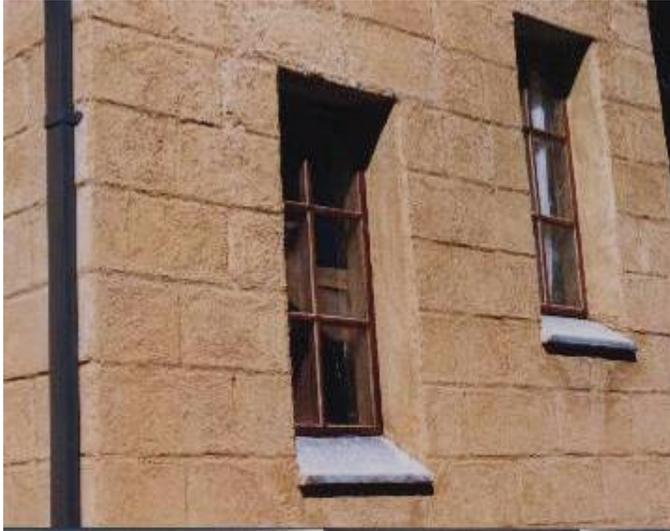
*Figura 2.16: Edifícios em adobe moldado in-situ (adobes desmoldados na hora)*
