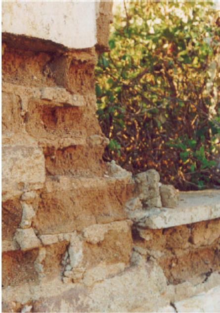
*Figura 7.1: Utilização de tijolos de barro cozido no confinamento do vão (Marques, 2002)*
