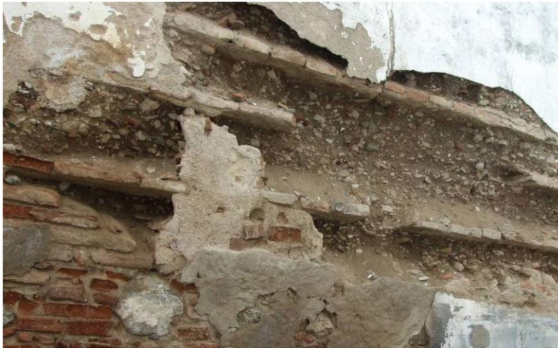
*Figura 2.4: Parede exterior em taipa reforçada com tijolo cerâmico, Serpa, Alentejo*
