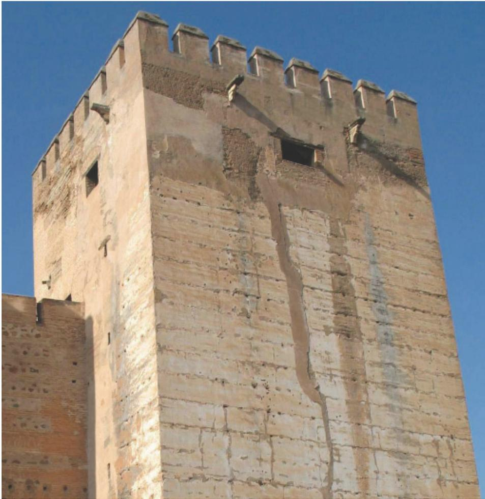
*Figura 8.2: Preenchimento de fissuras em paredes de terra, Granada-Espanha (Jaquin, 2008)*
