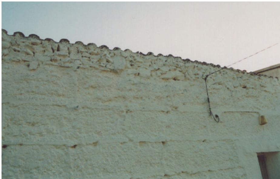
*Figura 6.2: Alvenaria de taipa revestida com pintura por caição.*
