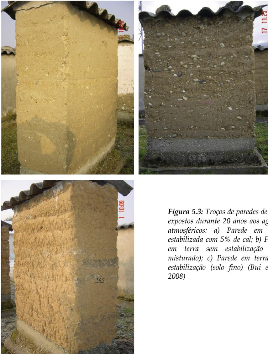
*Figura 5.3: Troços de paredes de taipa expostos durante 20 anos aos agentes atmosféricos: a) Parede em terra estabilizada com 5% de cal; b) Parede em terra sem estabilização (solo misturado); c) Parede em terra sem estabilização (solo fino) (Bui et al., 2008)*
