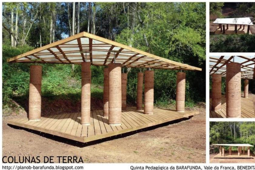
Figura 1.14: Estrutura para realização de eventos com colunas de terra
