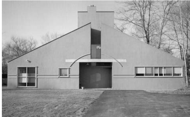
105. Vista do alçado principal
