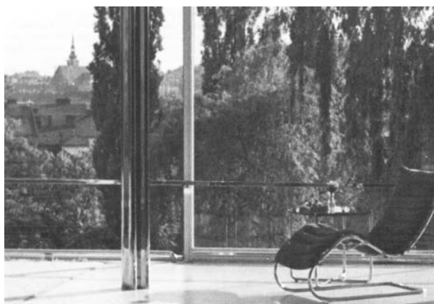
57. Casa Tugendhat. Vista da sala, com os panos de vidro rebaixados
