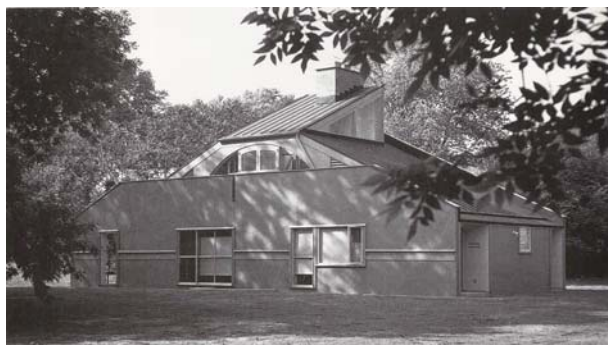
107. Vista do alçado lateral esquerdo
