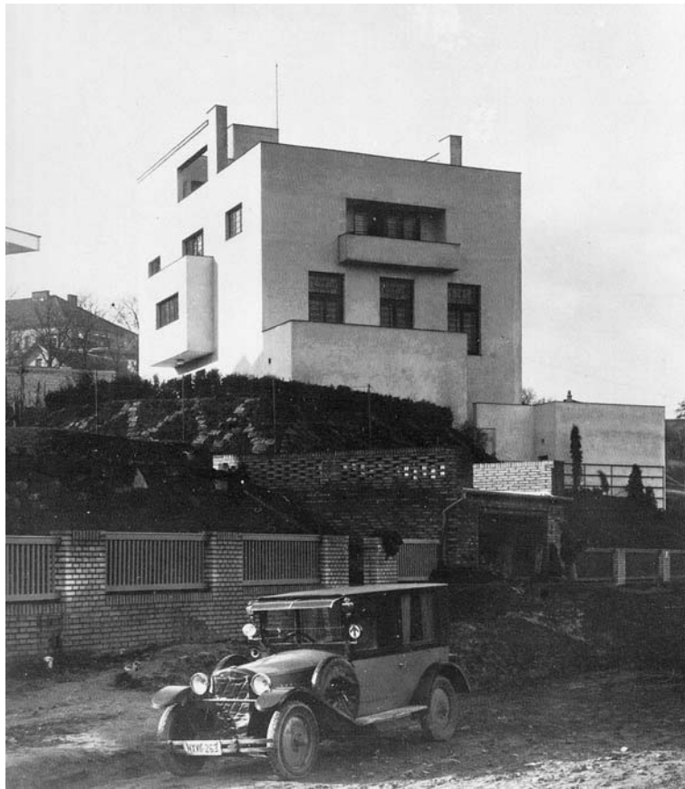
198. Casa Müller , fachada lateral e posterior, Praga, 1930
