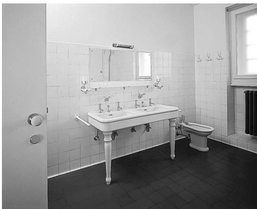
233. Casa Müller , instalações sanitárias do casal
