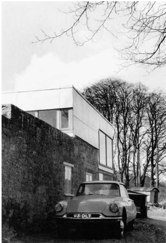
149. Solar Pavilion : Fotografias das instalações existentes e fotografia tirada do lado da rua, 1962
