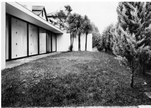
184. Vista da casa da Rua do Padrão
