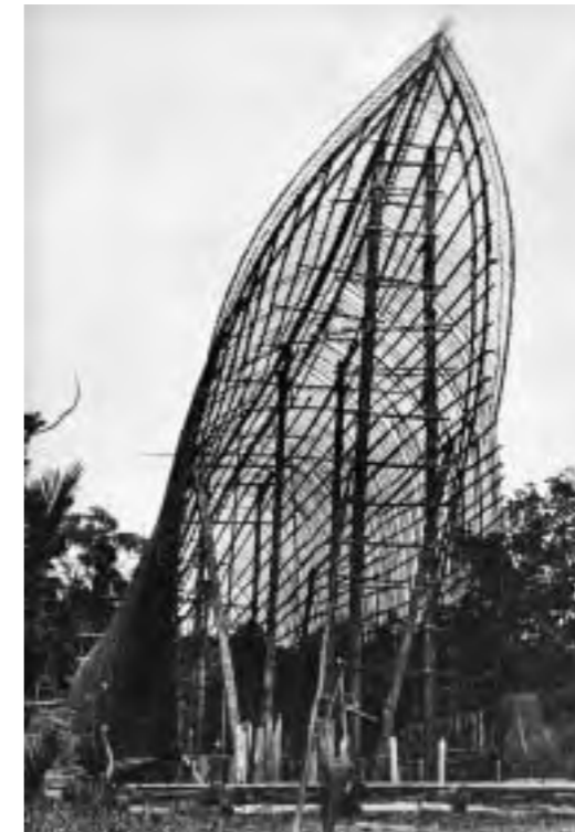
Costruzione di un club per uomini a Maipua, nel golfo della Nuova Guinea. La struttura in bambù sarà rivestita di paglia.
