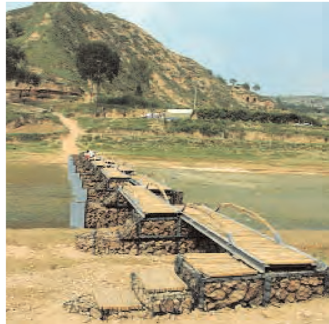
17 luglio 2005, il ponte è completato.
