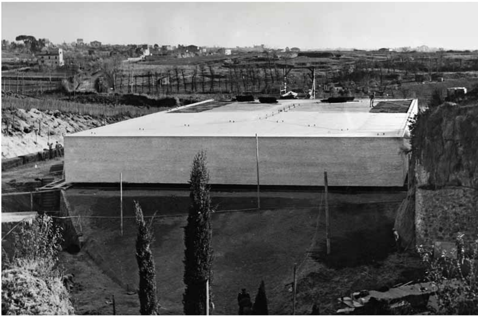
26 -il monolite disarmato in attesa del rivestimento della copertura nell'ottobre 1948 -the stripped monolith awaiting cladding of the roof in October 1948 27 -completamento della copertura del monolite nel novembre 1948 -completion of the roof of the monolith in November 1948
