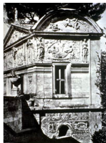
Fig.64c - Facciata Sud-Ovest della Loggia
