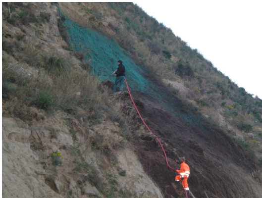
Figura 8. Applicazione della tecnica dell'idrosemina a matrice di fibre legate tipo Soilguard in due passaggi nel territorio di Villarosa in provincia di Enna.
