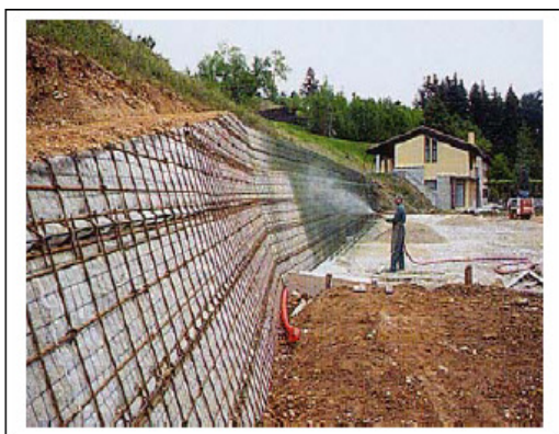
Figura 3. Applicazione dell'idrosemina a spessore su terre rinforzate; il colore verde del mulch permette un controllo diretto della miscela irrorata da parte dell'operatore.
