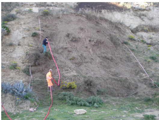
Figura 5. Applicazione della tecnica dell'idrosemina a spessore in un unico passaggio nel territorio di Villarosa in provincia di Enna.
