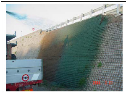
Figura 4. Applicazione dell'idrosemina a spessore su terre rinforzate in due passaggi.
