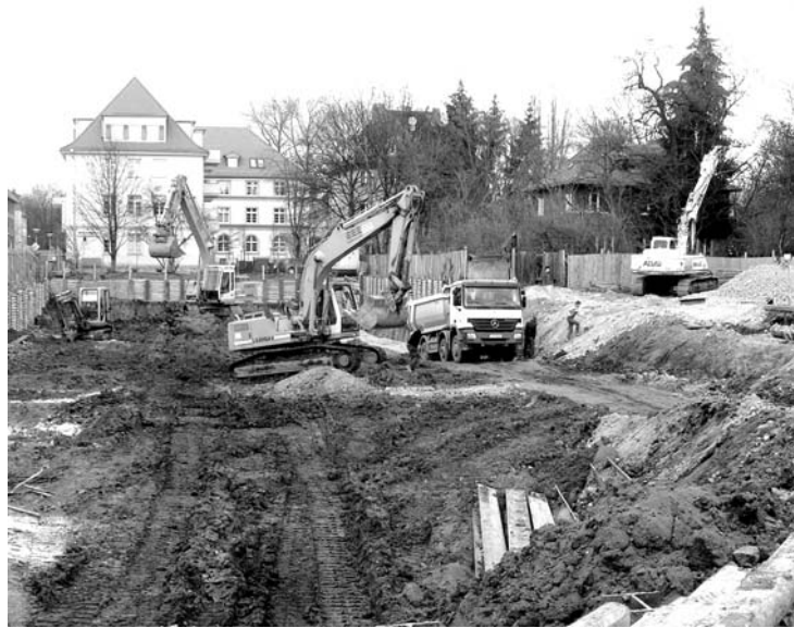
Abb. 2.1 Erdarbeiten auf der Baustelle des CIB.Weimar Coudraystraße im Dezember 2006
