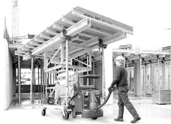
Abb. 3.10 Versetzen eines vorgefertigten Schaltisches mit Hubwagen und Spezialgerät (DOKA)
