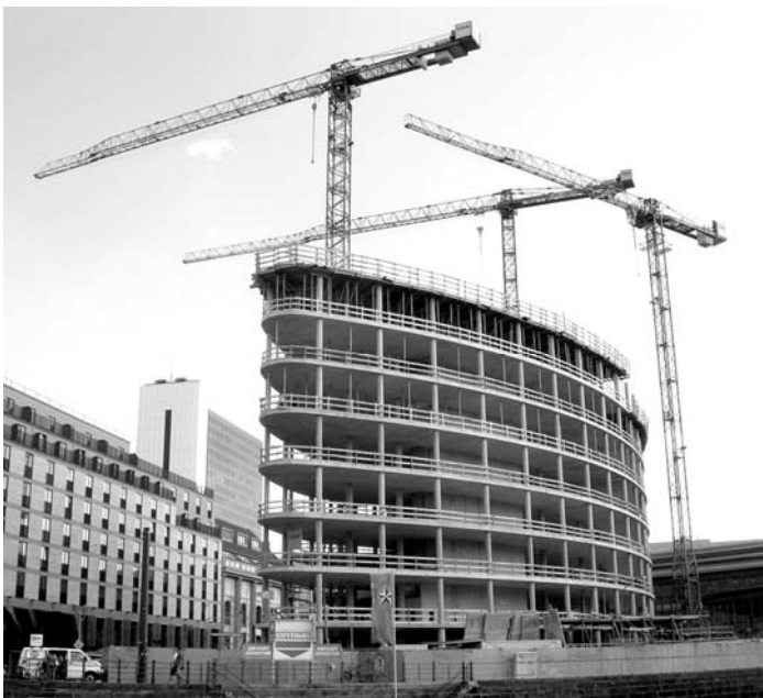
Abb. 5.6 Obendreher-Krane, gestaffelt angeordnet, nicht verfahrbar, auf einer Baustelle in Berlin, Friedrichstraße, 2008
