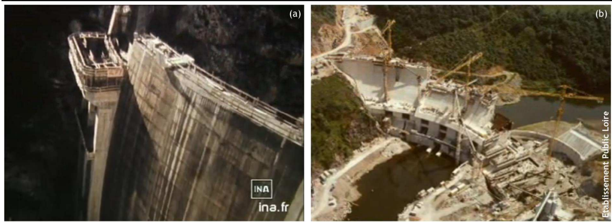
Figure 54 – Illustrations photographiques d'ouvrages structurants en construction faisant l'objet d'aides dans le cadre des programmes d'intervention des AE : (a) le barrage de Sainte-Croix sur le Verdon (AE RMC) (1973) et (b) le barrage de Villerest sur la Loire (AE LB) (1982).
