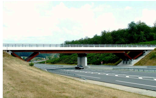
(d) Passage supérieur du Chavanon (19)
