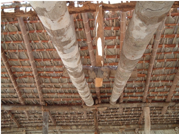
Photographie 38 : Détails de la charpente d'une case dans le village de Boeny-Aranta
