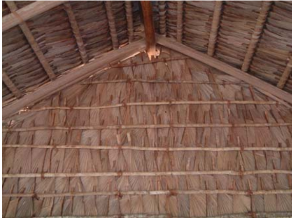
Photographie 44 : A Ampasimaloatra, comblement de l'espace entrant – faitage à l'aide d'assemblages de demi-feuilles de satrana
