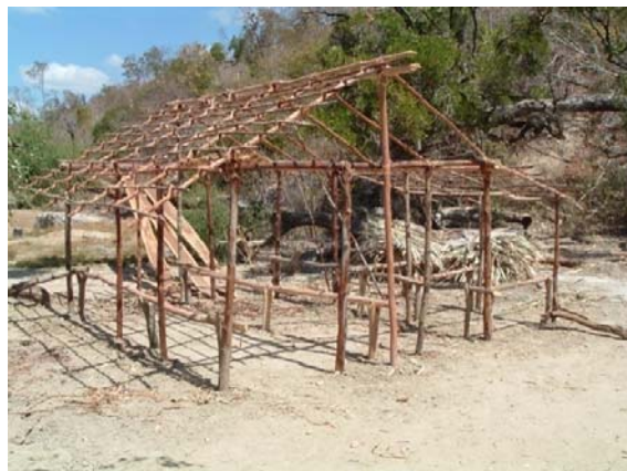
Photographie 46 : Cases de Matahitromby construites sur pilotis en zone submersible à chaque marée haute
