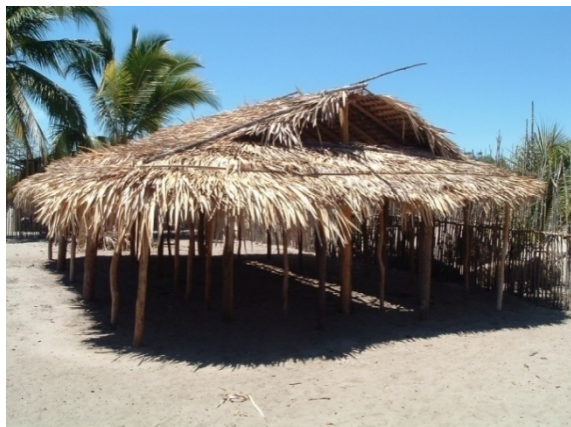
Photographie 40 : Couverture de case réalisée en feuille de palmier satrana be
